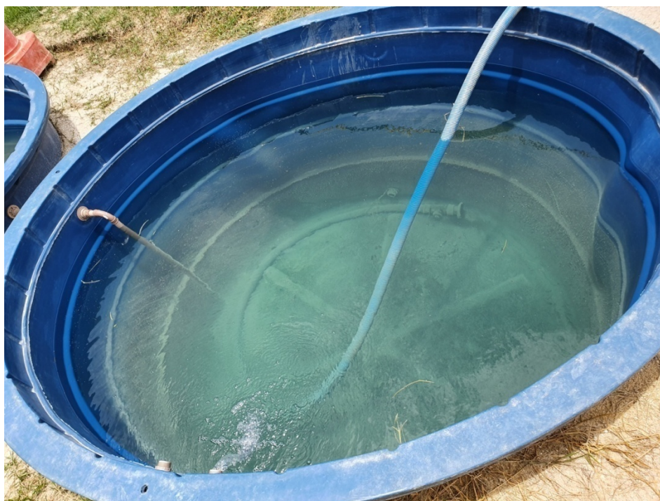
Figura 9: Local de armazenamento de água de reuso (efluente após passar pelo tratamento).
