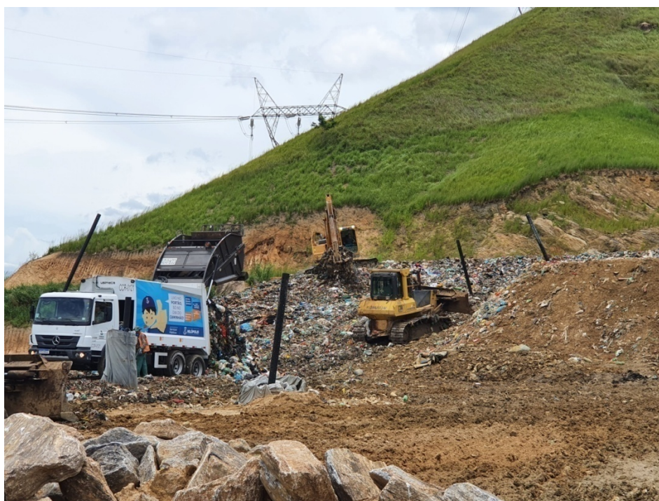
Figura 4: Vista da frente de trabalho.
