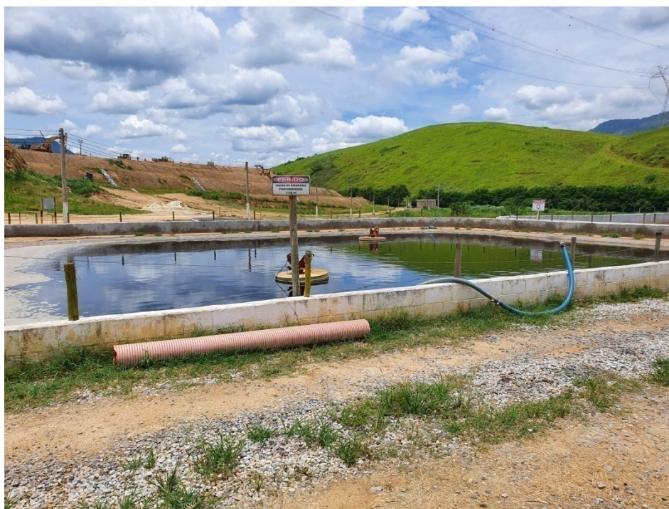
Figura 10: Lagoa de tratamento de chorume.
