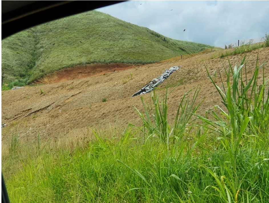
Figura 5: Vista das camadas já operadas onde foi feita a hidrossemeadura.
