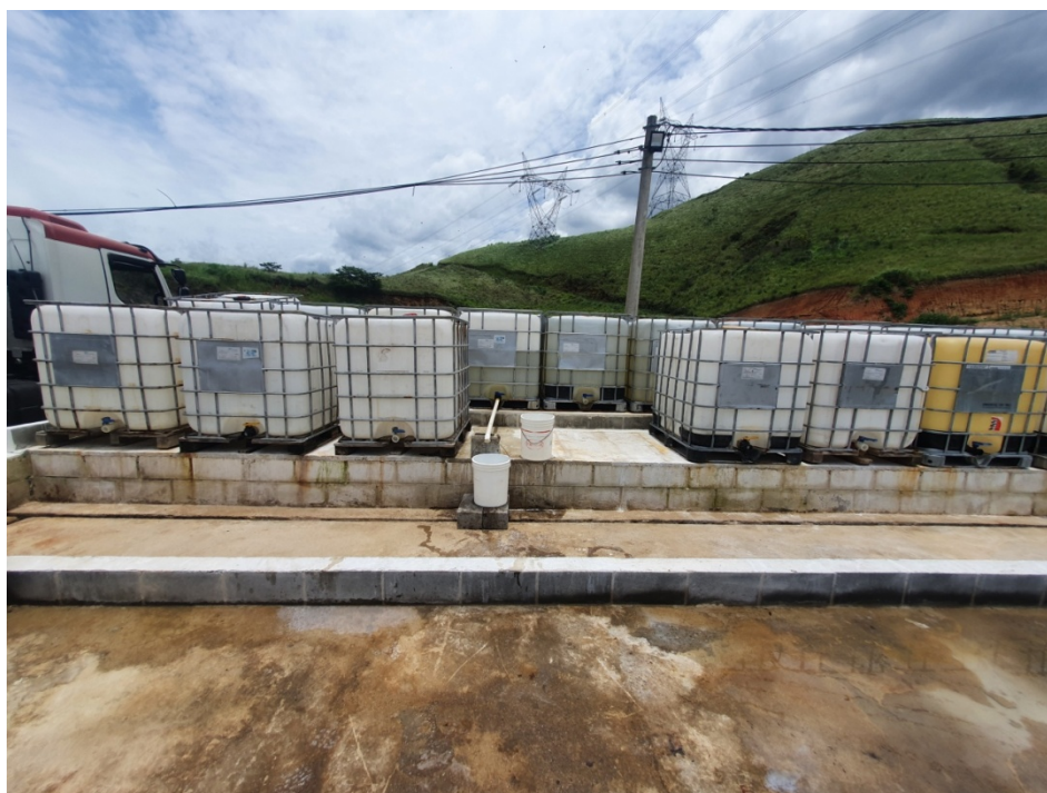
Figura 7: Local de armazenamento de produtos a serem utilizados no tratamento do chorume.
