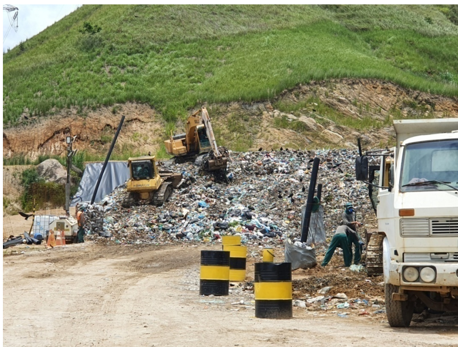
Figura 3: Vista da frente de trabalho.
