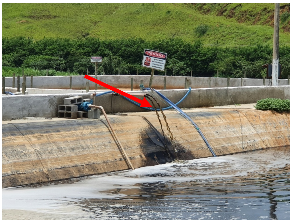
Figura 8: Lagoa de acumulação de chorume. Na imagem é possível visualizar o momento no qual o chorume entra na lagoa, conforme demonstrado pela seta em vermelho
