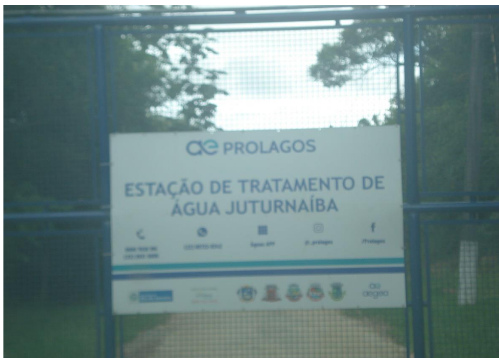
Foto 01 – Entrada da ETA da PROLAGOS
