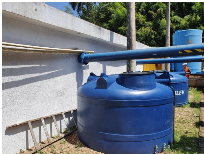
3 adutoras de Ferro Fundido DN 150 mm.
