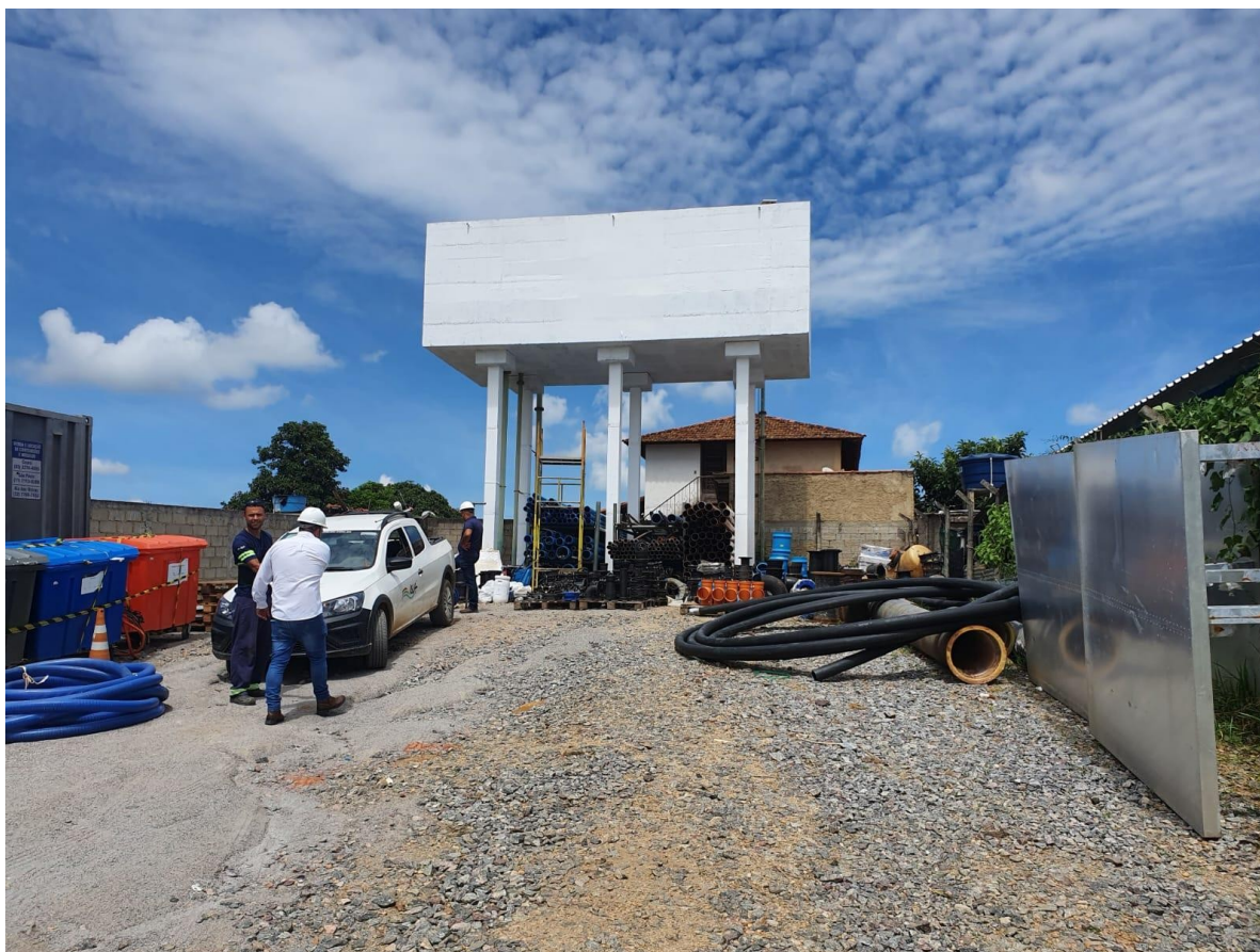
Pátio do reservatório e almoxarifado.
