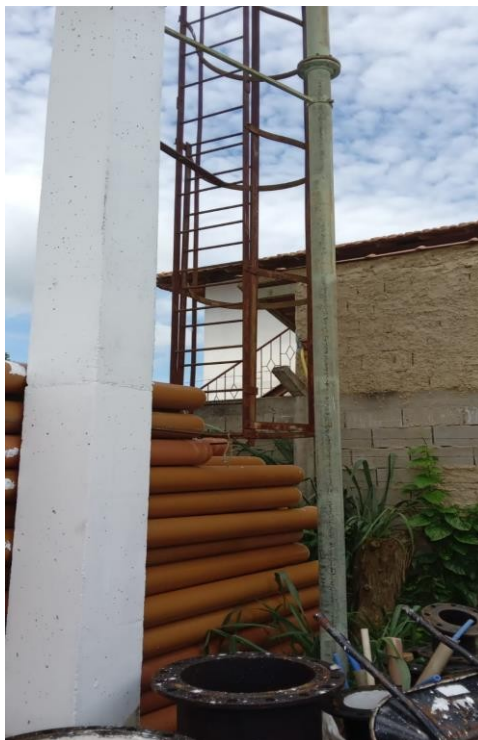
Escada de acesso ao reservatório.
