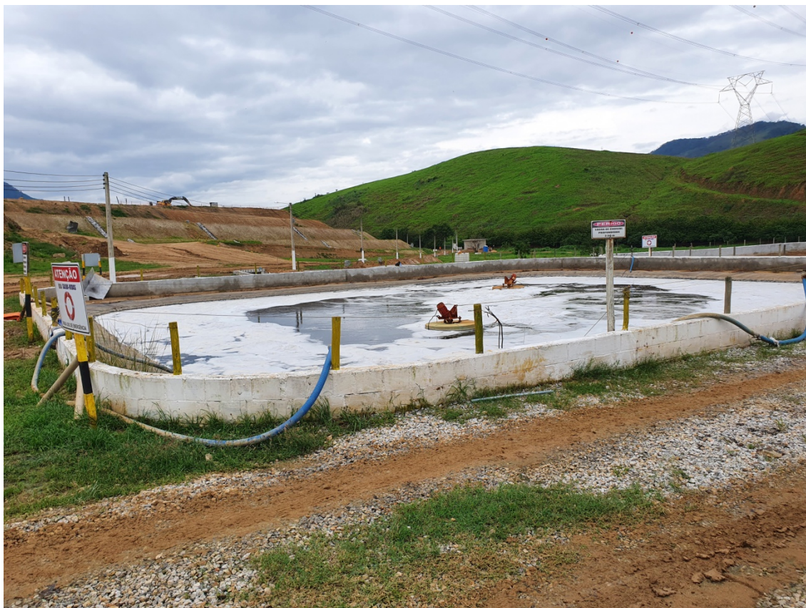
Figura 07: Lagoa de chorume com aerador em funcionamento.
