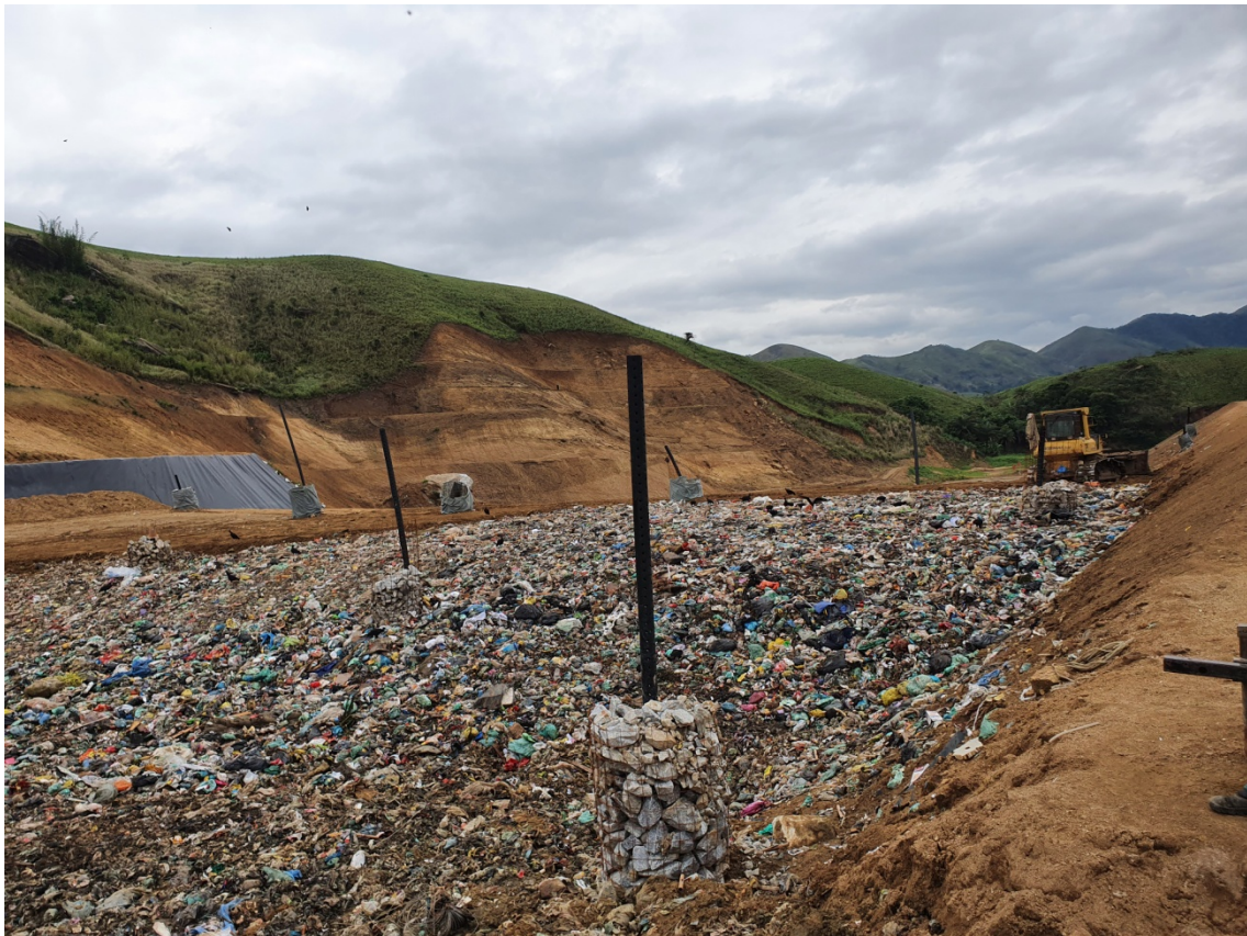
Figura 04: Vista da frente de trabalho.
