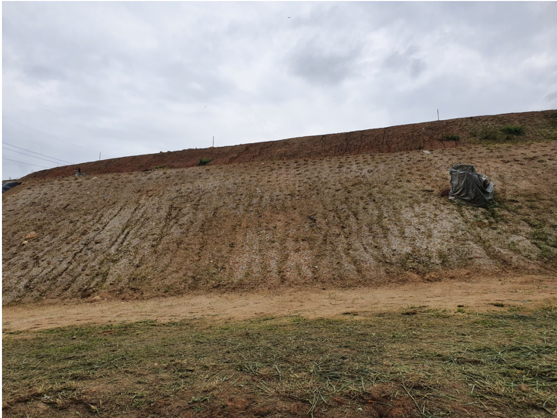
Figura 05: Hidrossemeadura sendo feita.
