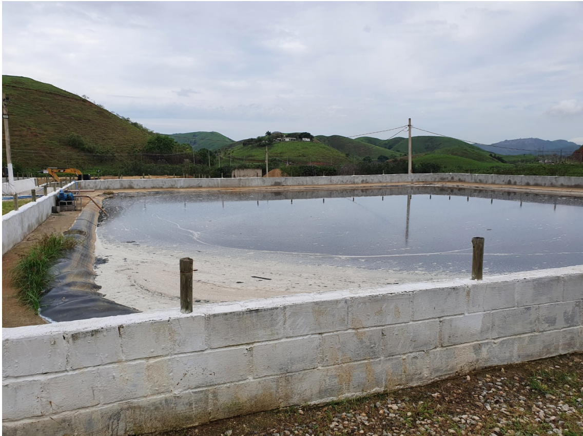
Figura 08: Lagoa de tratamento de chorume.
