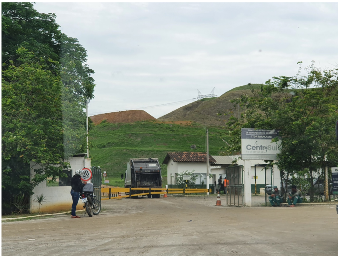
Figura 02: Vista da entrada do aterro.
