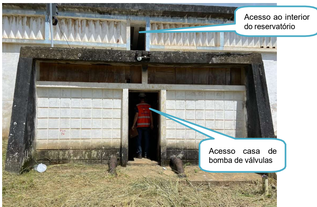
Entrada da casa de bombas e válvulas e entrada do interior do reservatório
