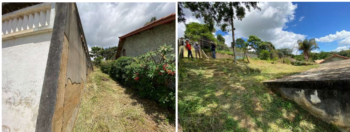
Vista das laterais do reservatório
