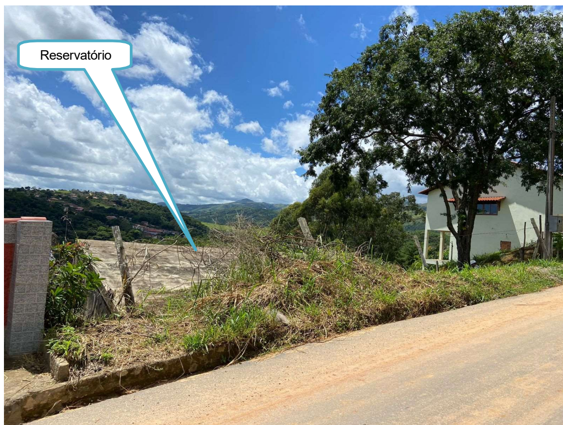
Reservatório – vista frontal
