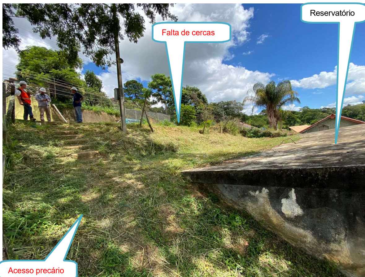
Entrada do reservatório
