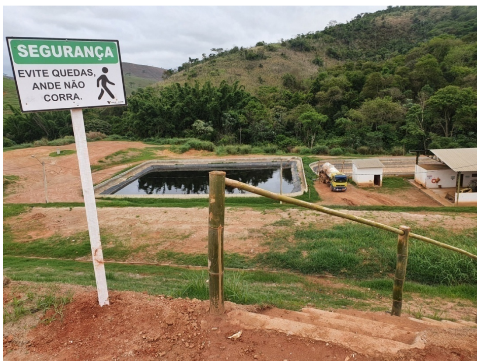
Figura 10: Vista da escada e corrimão instalados nos taludes para facilitar o deslocamento de funcionários e visitantes na célula do aterro.
