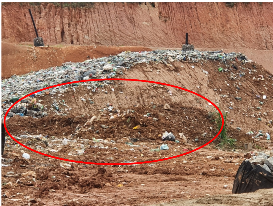
Figura 7: Vista da frente de trabalho ao fundo e, à frente, conforme marcado, pode ser visto o lodo que está sendo recebido no CTDR. O mesmo é misturado com terra e utilizado para realizar a cobertura dos resíduos.
