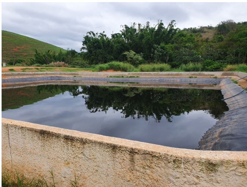
Figura 13: Lagoa de armazenamento de chorume.
