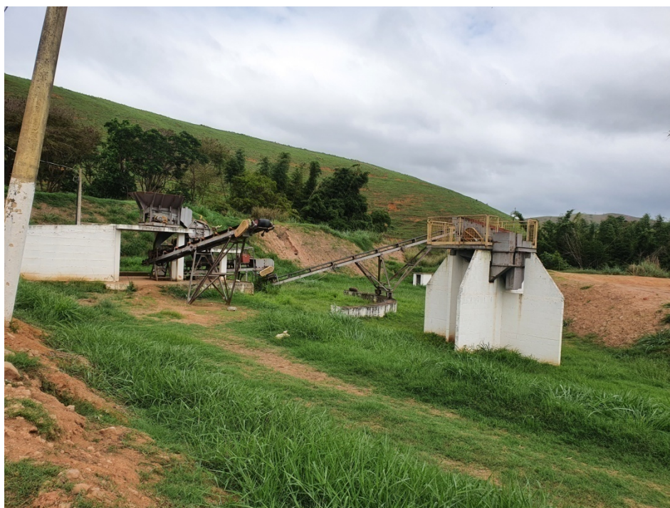
Figura 16: Britador de resíduos da construção civil inoperante.
