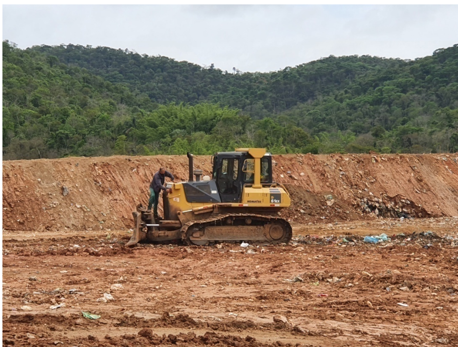
Figura 5: Trator inoperante devido problemas técnicos.
