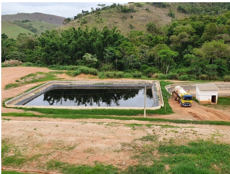
Figura 14: Lagoa de armazenamento de chorume e caminhão fazendo o recolhimento para ser direcionado ao CTDR/Paracambi e ser realizado o devido tratamento.
