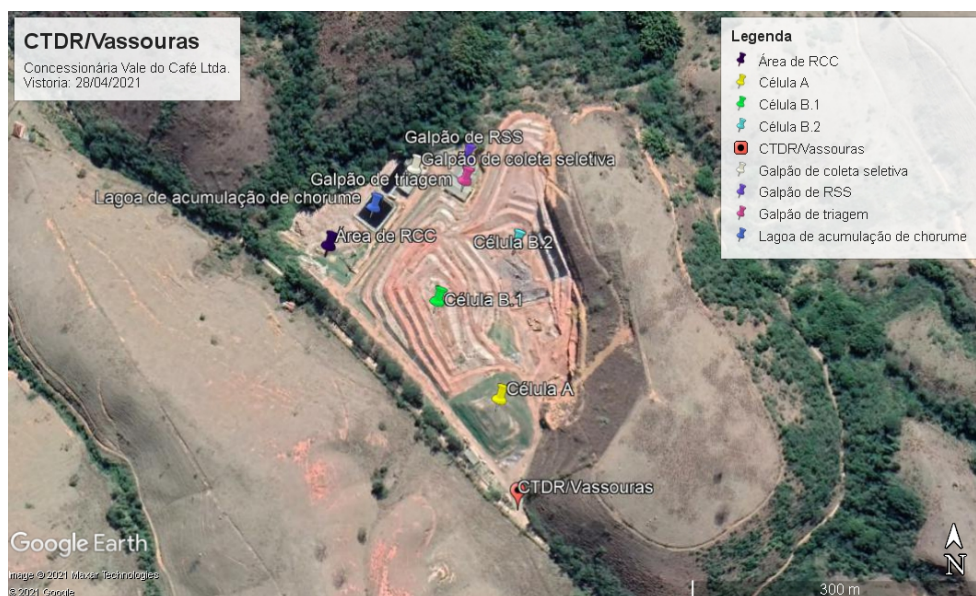
Figura 1: Vista aérea do CTDR/Vassouras. Fonte: Google Earth, 28/04/2021.
