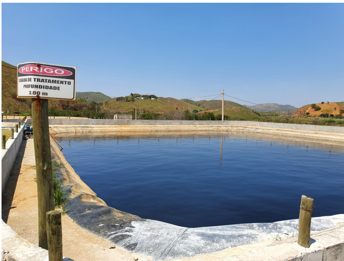
Figura 08: Lagoa de tratamento de chorume.
