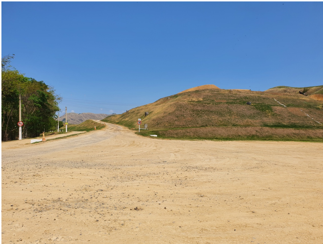
Figura 02: Vista da entrada do aterro.
