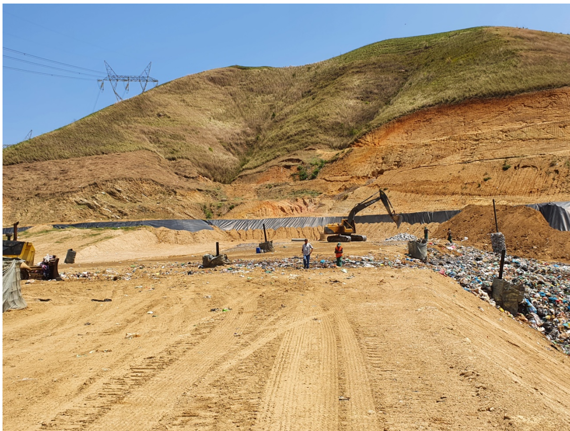
Figura 04: Vista da frente de trabalho.
