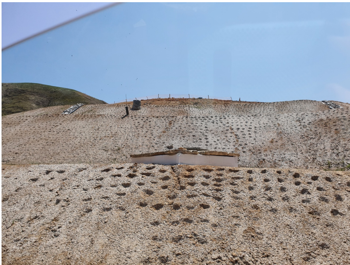
Figura 06: Vista da hidrossemeadura, nos taludes.
