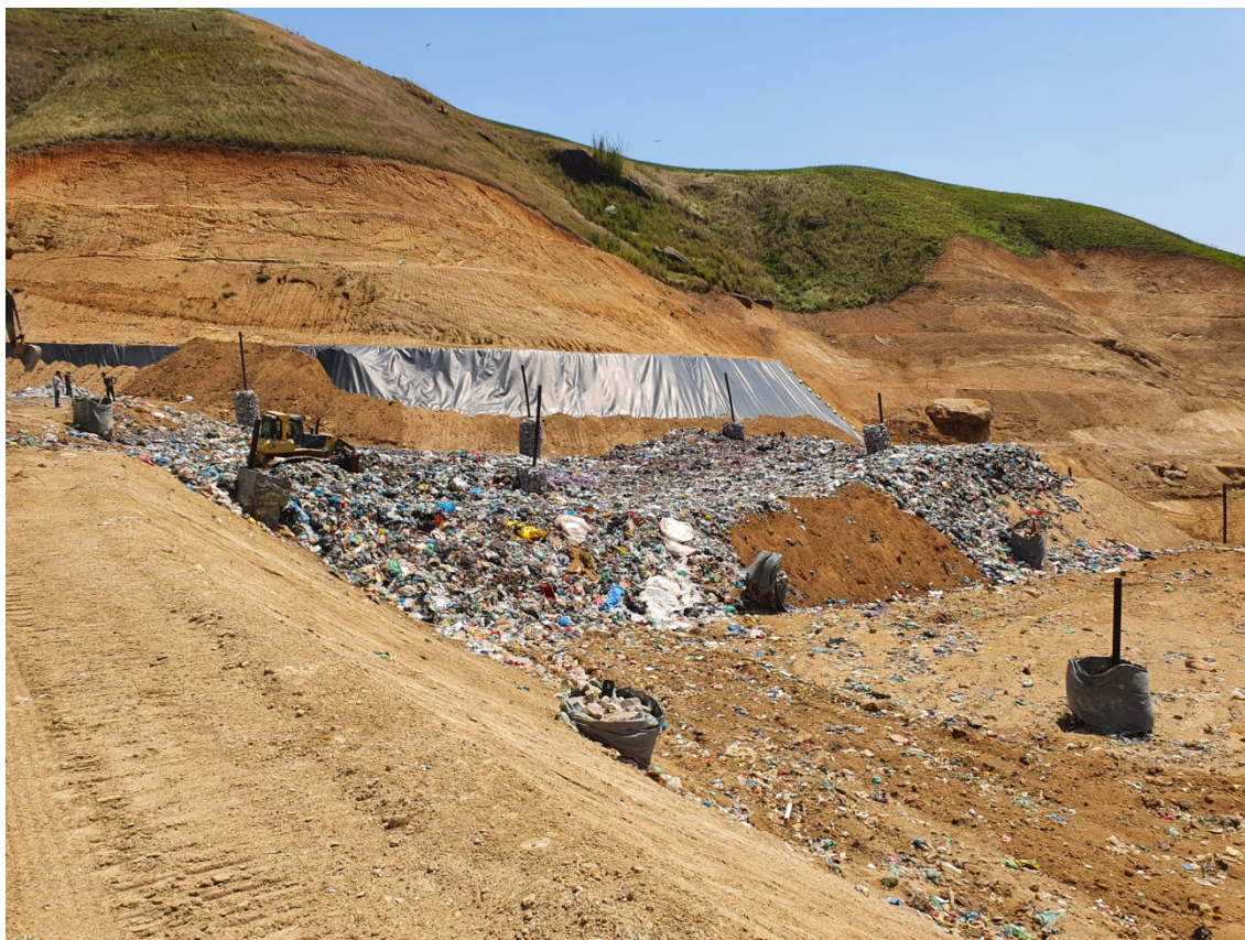
Figura 03: Vista da chegada da frente de trabalho.
