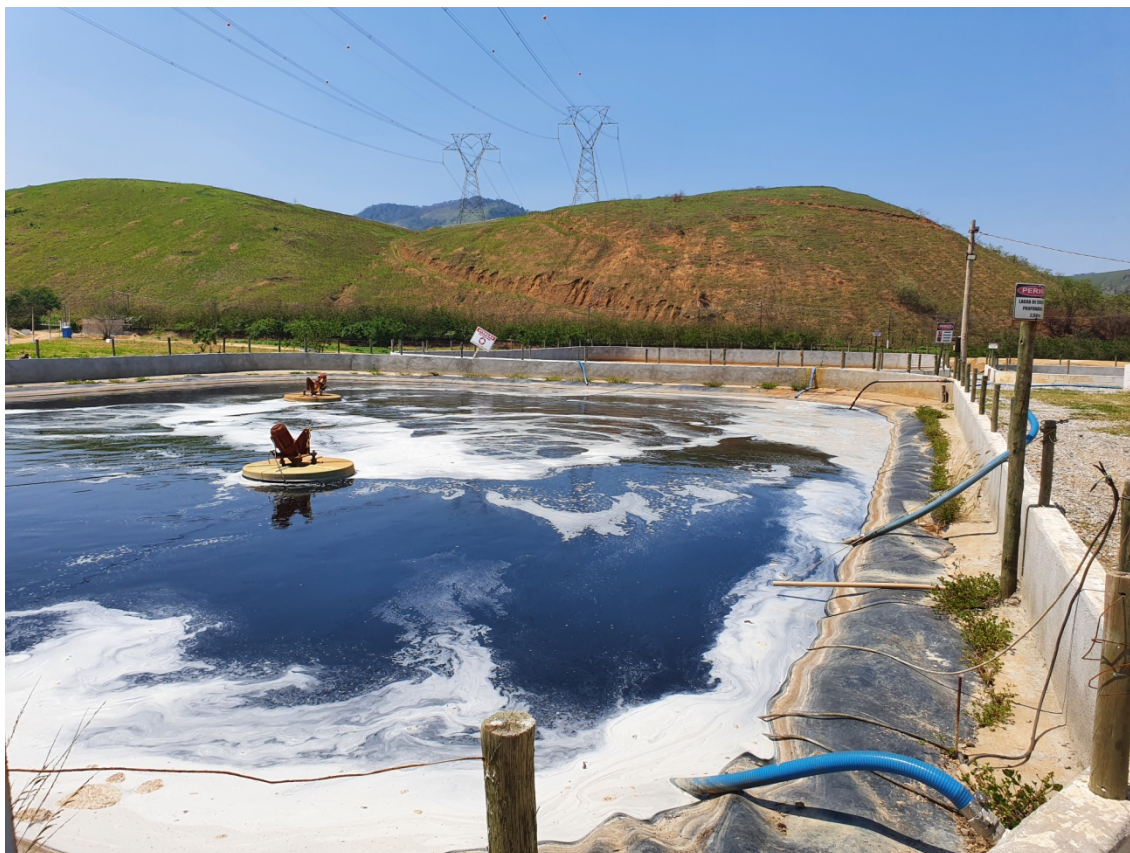
Figura 07: Lagoa de chorume com aerador em funcionamento.
