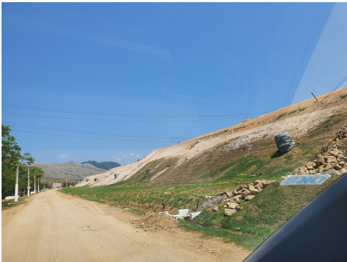
Figura 05: Vista da hidrossemeadura, nos taludes.
