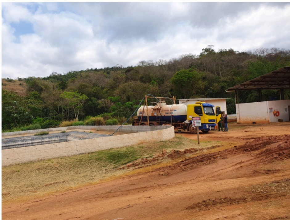
Figura 12: Vista da área das lagoas de acumulação de chorume
