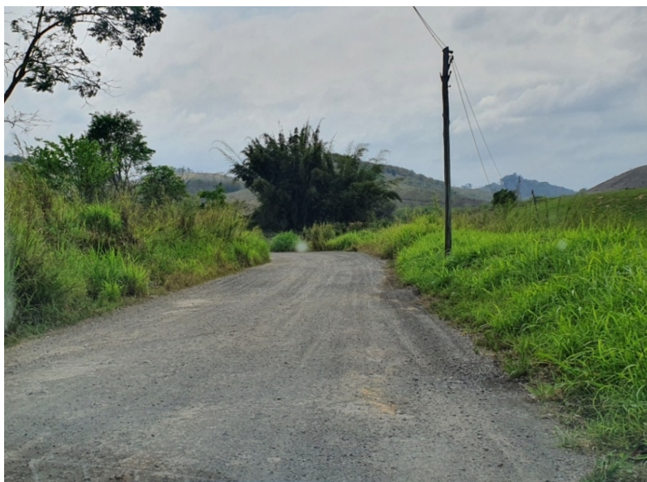
Figura 2: Estrada de acesso ao CTDR apresentando boas condições.
