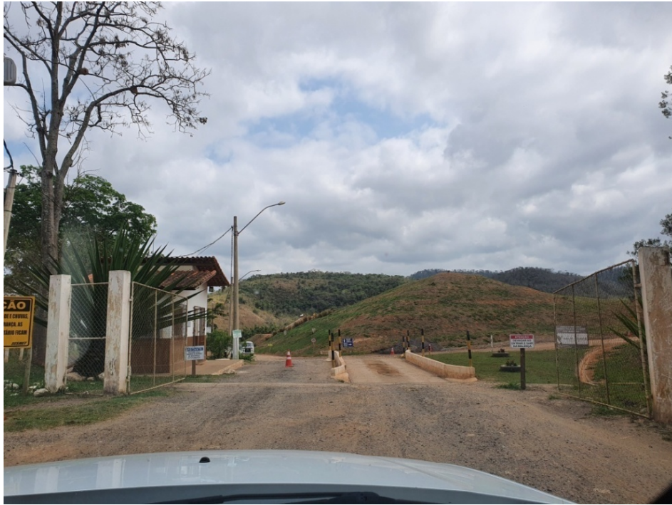
Figura 4: Vista da entrada do CTDR. À esquerda é possível observar a cabine de controle da balança.
