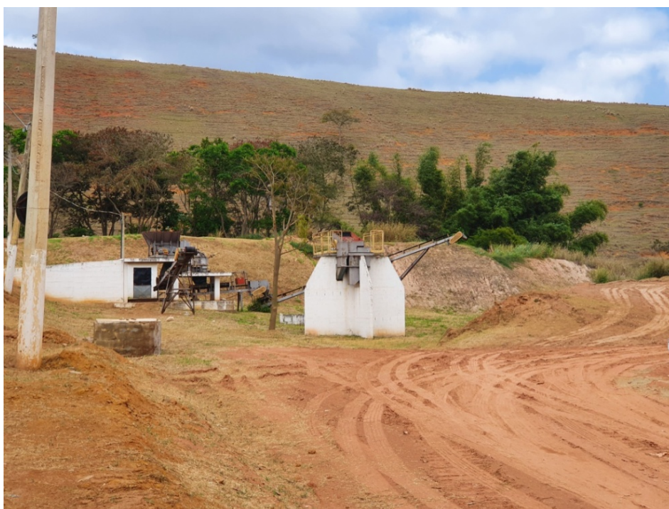
Figura 15: Britador disponibilizado para realizar a trituração de RCC. Inoperante.
