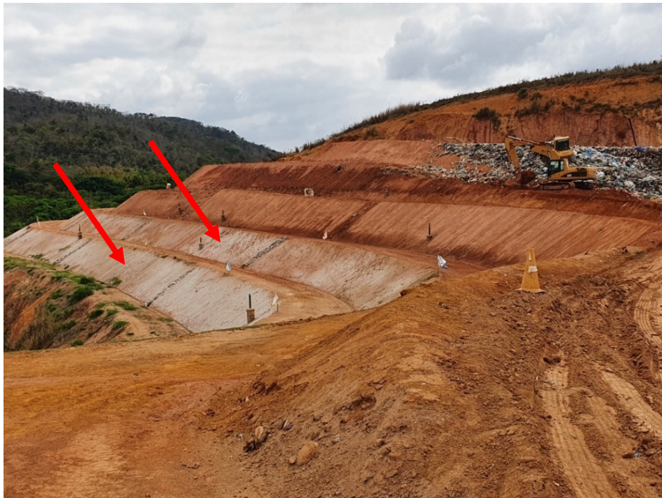
Figura 8: Vista das camadas da célula b, etapa 2. É possível observar coloração diferente em determinados taludes (destacados por setas) devido a técnica de hidrossemeadura.
