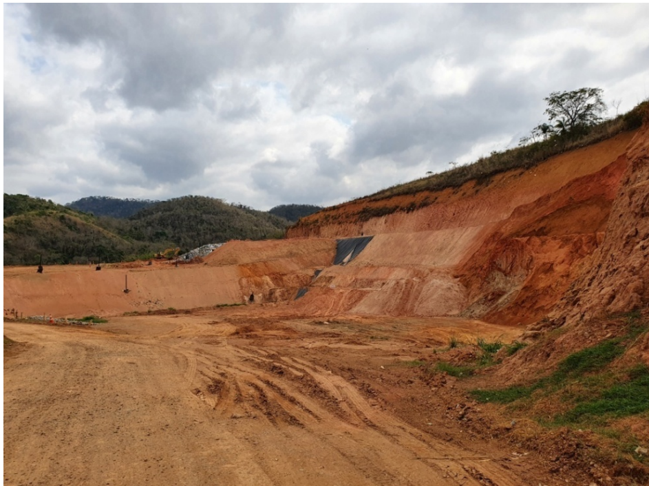
Figura 6: Vista da célula onde está sendo realizada a frente de trabalho. Célula B, etapa 2.
