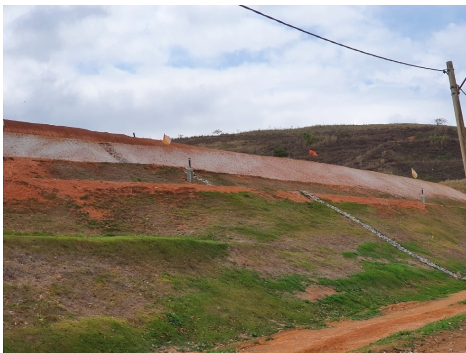
Figura 10: Vista das camadas da célula b, etapa 1. É possível observar taludes com cobertura de vegetação e, mais acima, talude com a técnica de hidrossemeadura.
