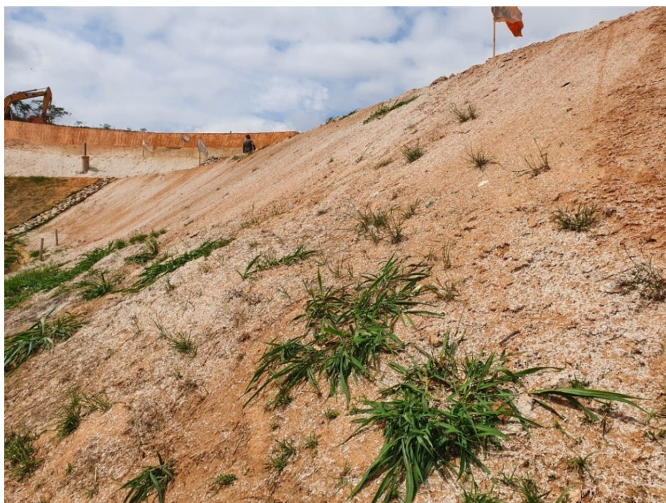
Figura 9: Vista aproximada da hidrossemeadura.
