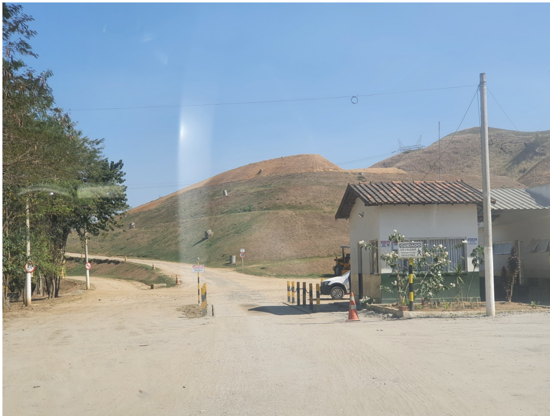
Figura 02: Vista da entrada do aterro.
