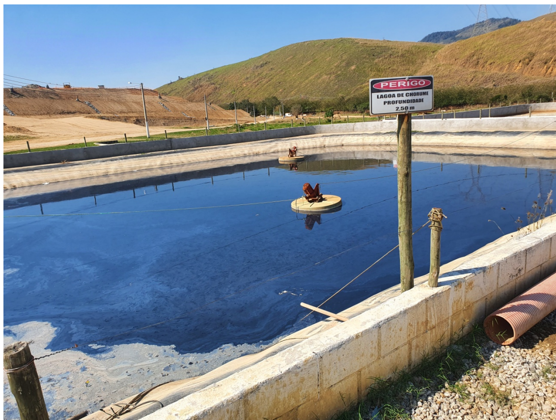
Figura 07: Lagoa de chorume com aerador sem funcionamento.
