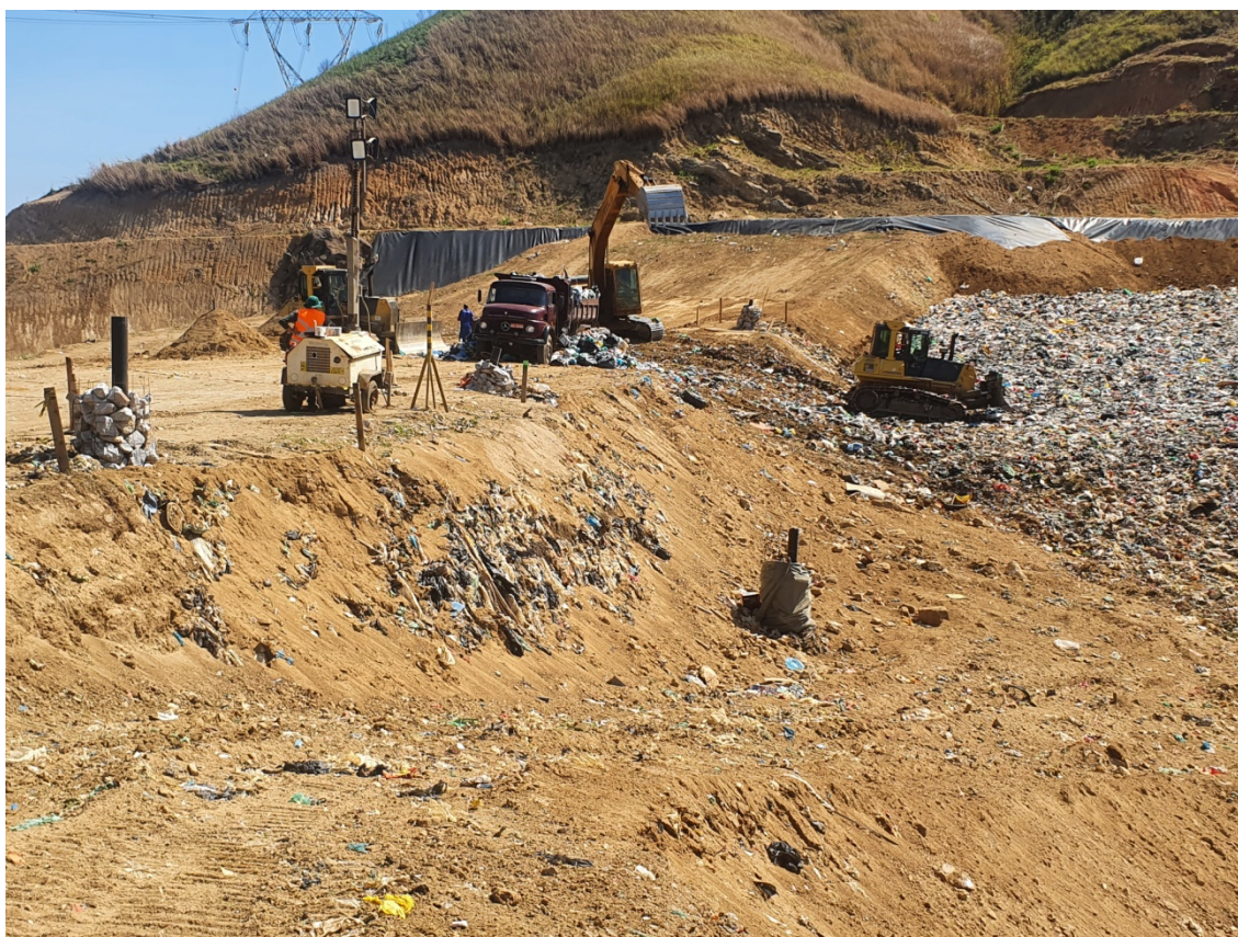
Figura 06: Vista da frente de trabalho.
