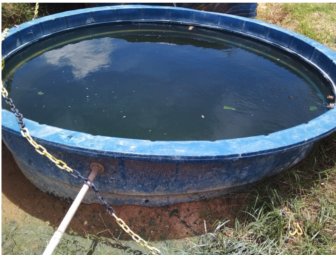
Figura 14: Reservatório do efluente após o tratamento (água para reuso).
