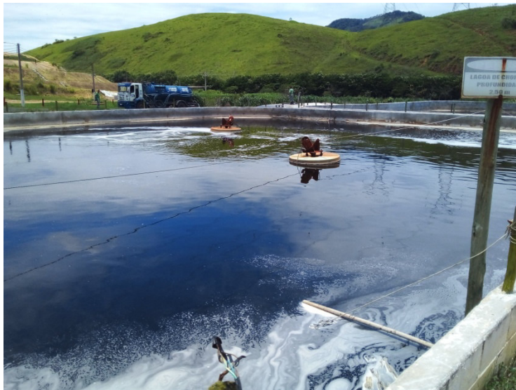
Figura 7: Lagoa de chorume primária com areador em funcionamento
