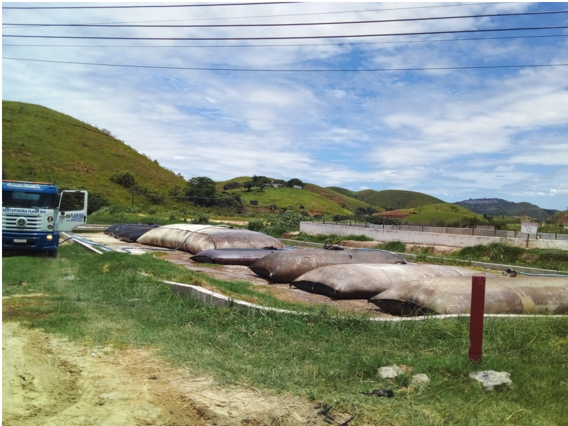
Figura 10: Vista dos Bags em funcionamento com caminhão recolhendo lodo
