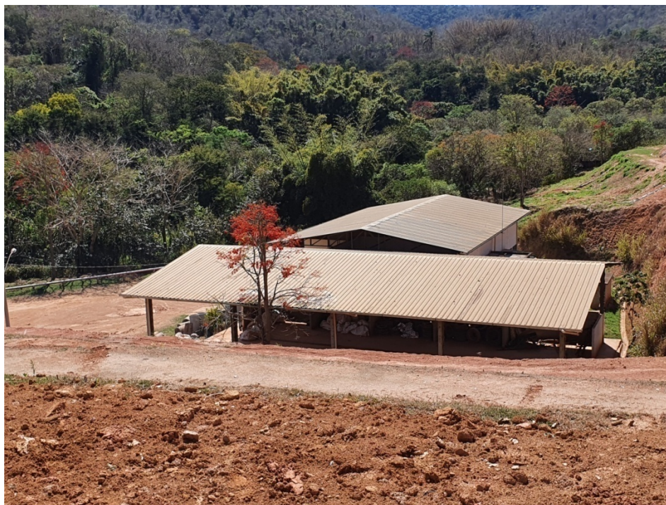
Figura 14: Vista do galpão para coleta seletiva e galpão de RSS.
