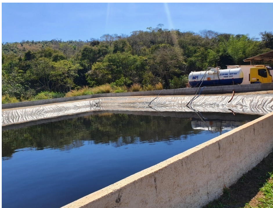
Figura 13: Lagoa de armazenamento de chorume e, à direita, caminhão pipa fazendo a retirada para encaminhar o chorume para a estação de tratamento de Paracambi.
