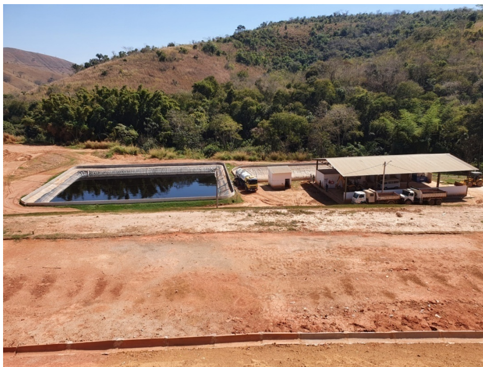
Figura 11: Lagoa de armazenamento de chorume.
