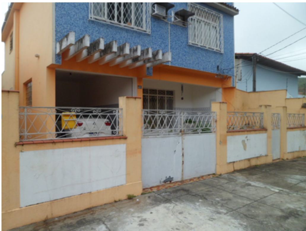
Foto 09 – Rua Monsenhor Marques, 455 - Pechincha – Jacarepaguá
