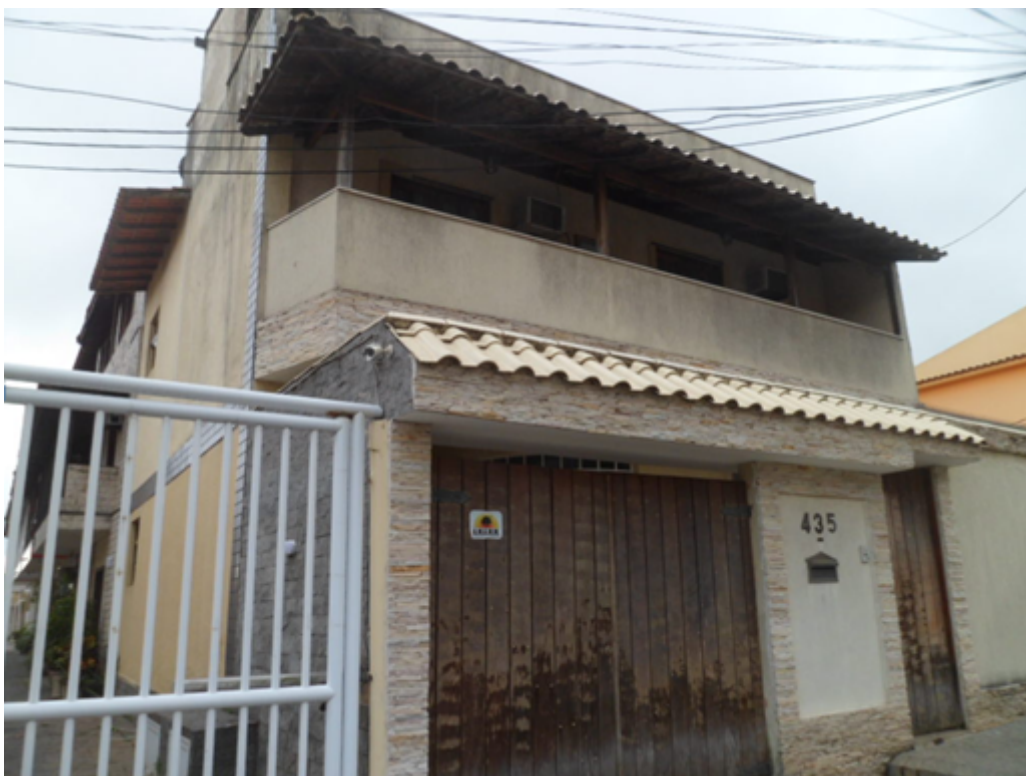
Foto 03 – Fachada da Residência do Reclamante, Rua Monsenhor Marques, 435 - Pechincha – Jacarepaguá
