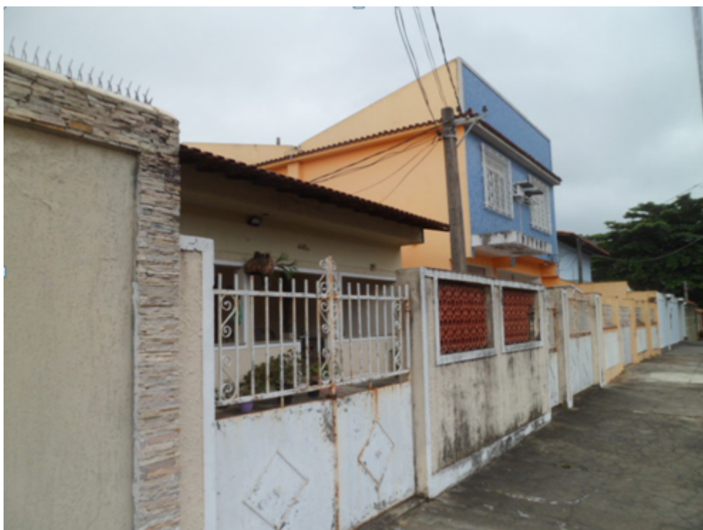
Foto 08 – Rua Monsenhor Marques, 445 - Pechincha – Jacarepaguá
