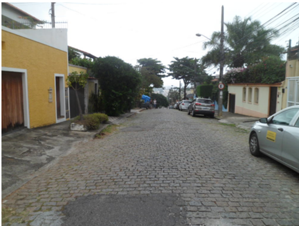
Foto 02 – Rua Monsenhor Marques - Pechincha – Jacarepaguá
