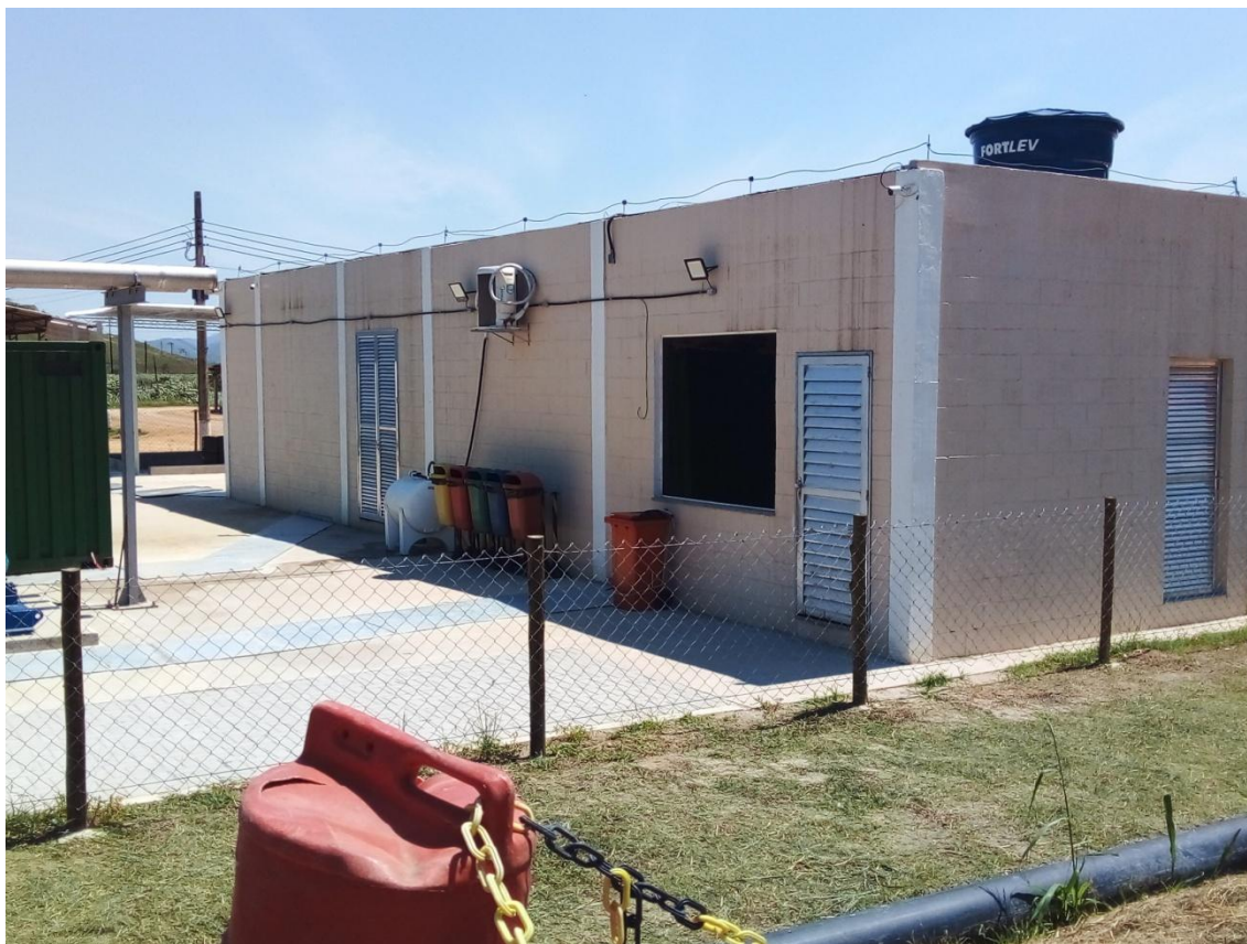
Figura 17: Vista da sala de controle da estação de Biogás
