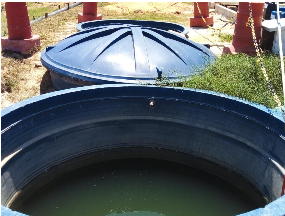
Figura 14: Reservatório do efluente após o tratamento (água para reuso).
