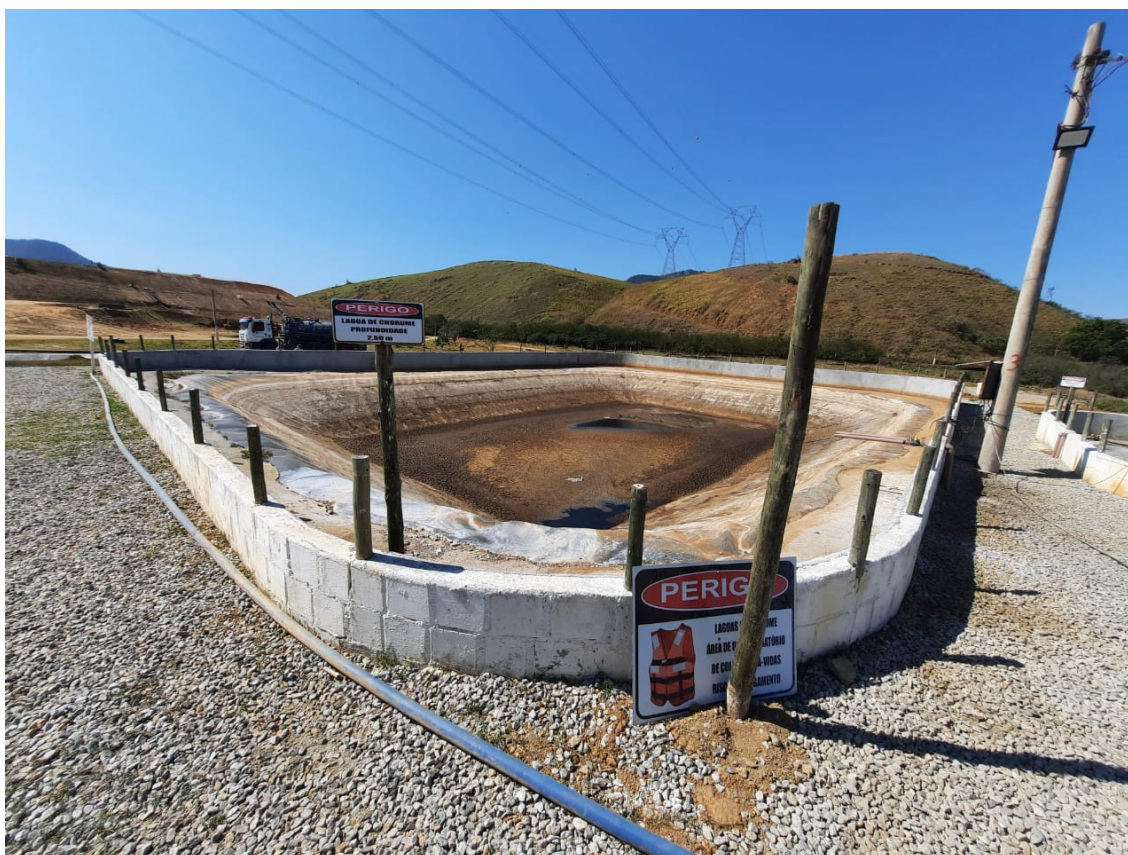
Figura 06: Lagoa de tratamento de chorume sendo realizada a limpeza.
