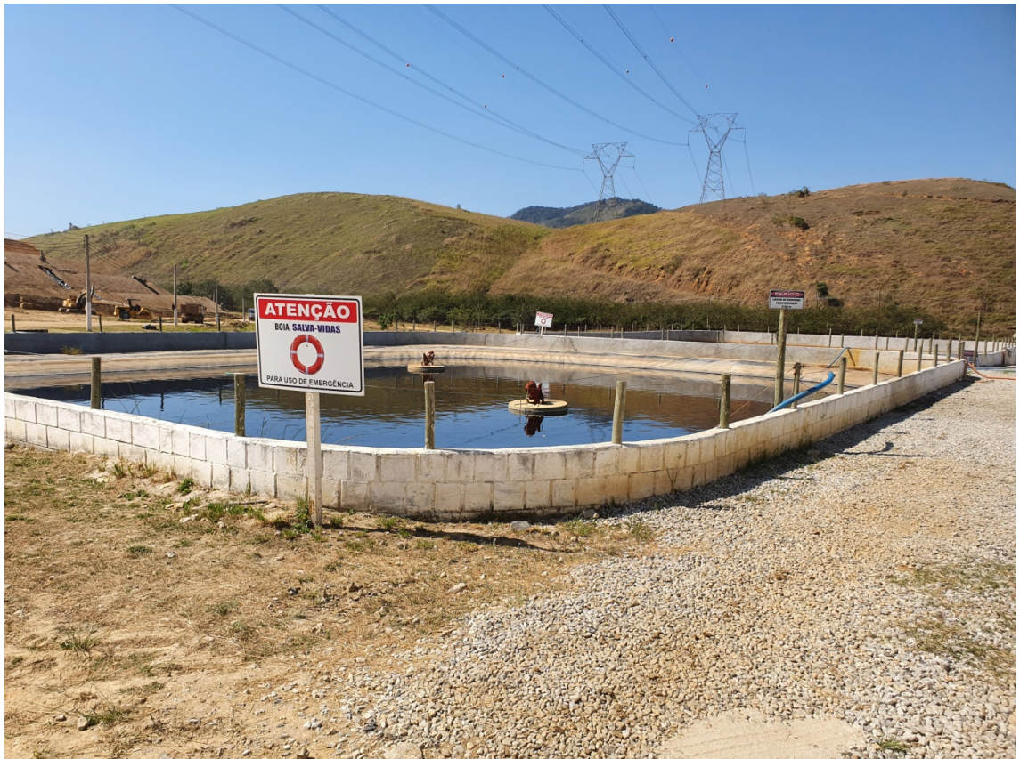
Figura 05: Lagoa de chorume com aerador sem funcionamento.
