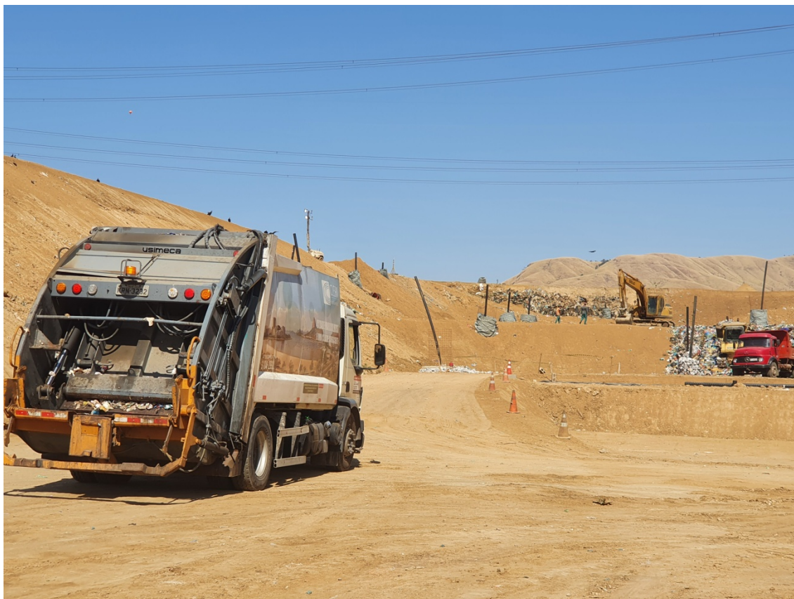
Figura 02: Vista da frente de trabalho
