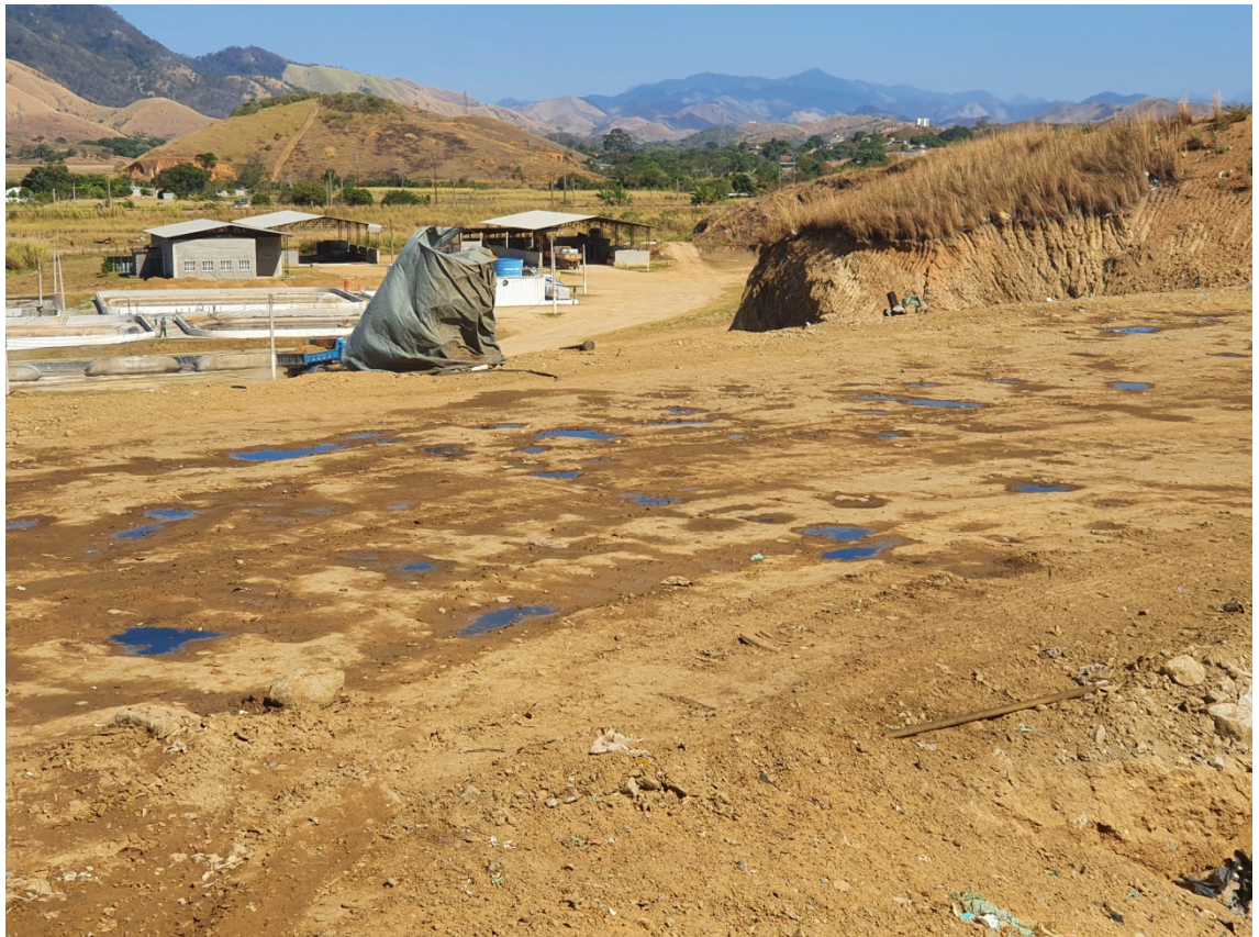
Figura 03: Vista da recirculação do chorume
