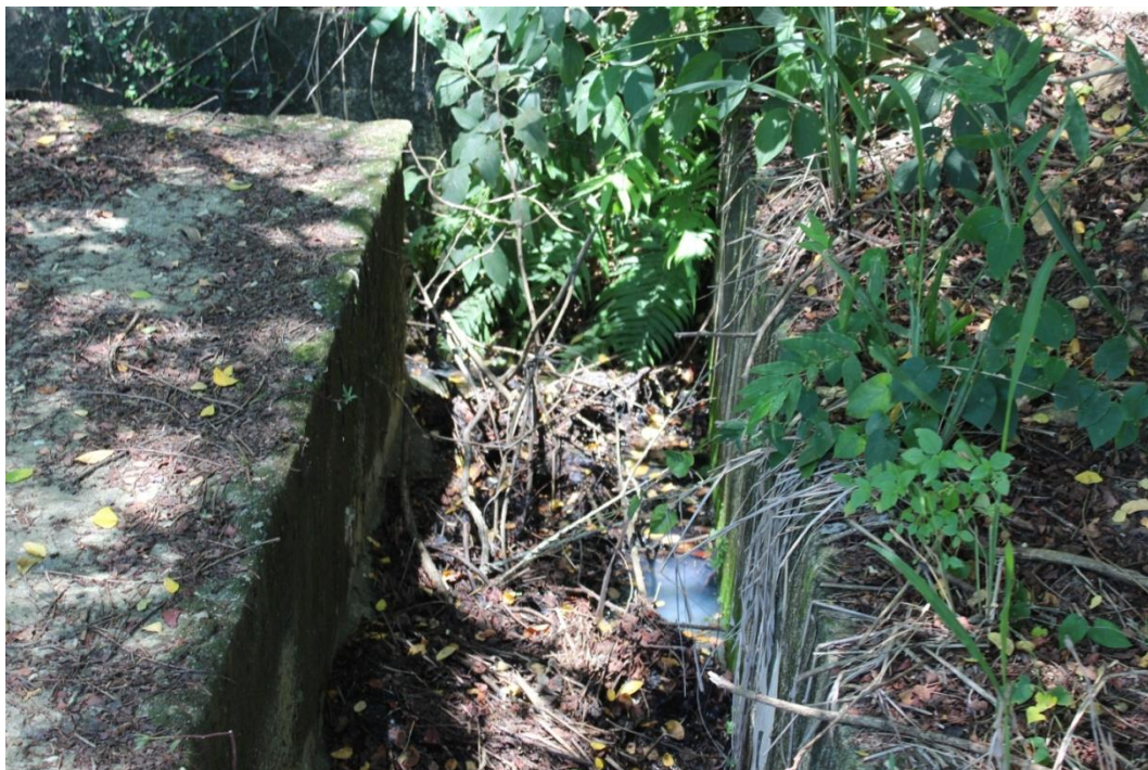
Calha que circunda o Reservatório
