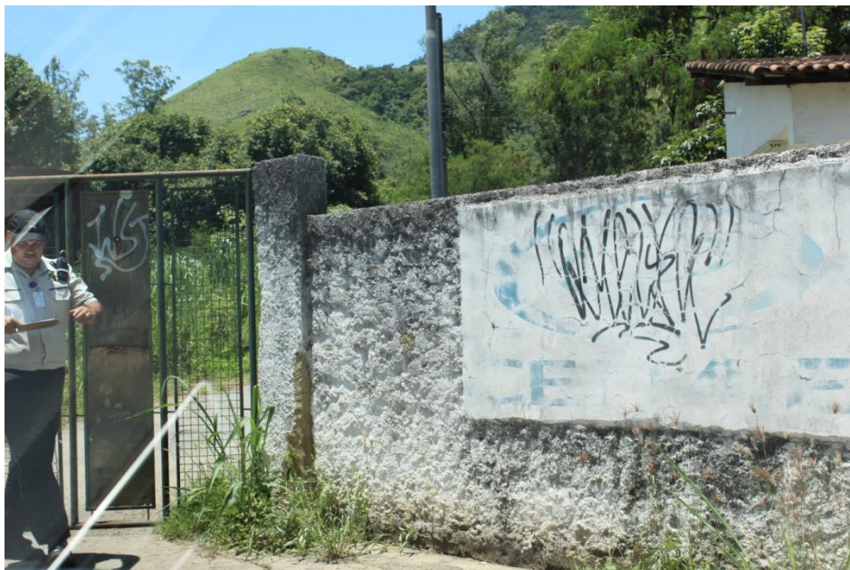
Portão de Acesso ao Reservatório de Marapicu
