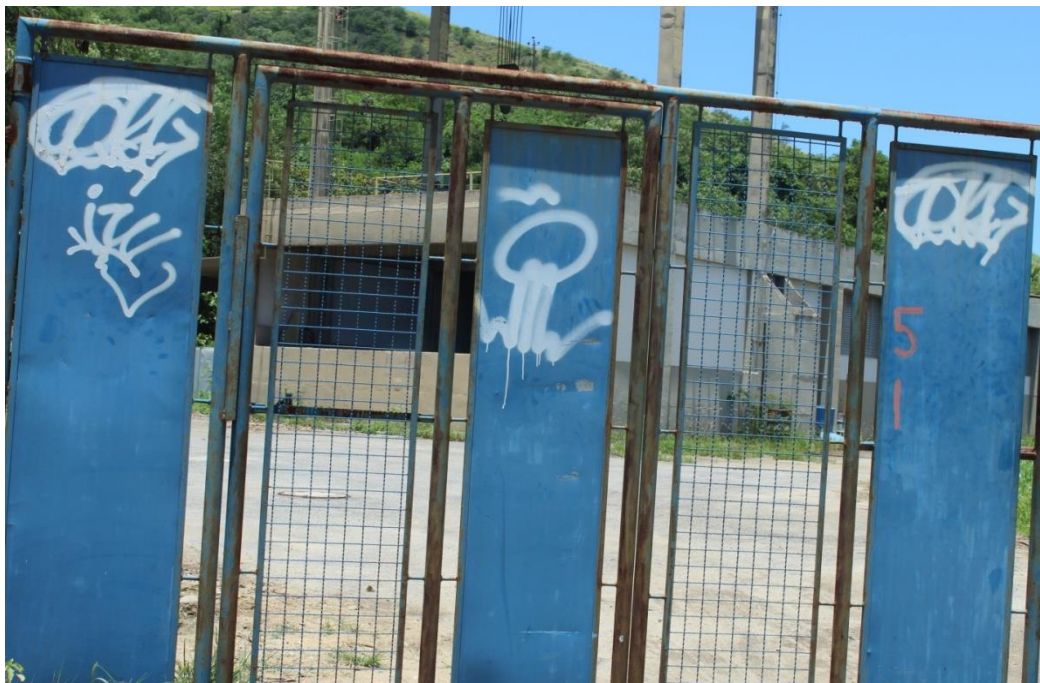
Portão de Acesso ao Reservatório de Marapicu
