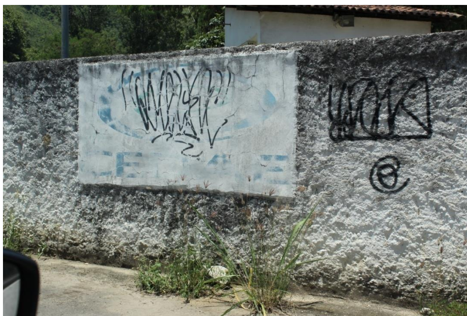
Placa de Identificação do Reservatório de Marapicu
