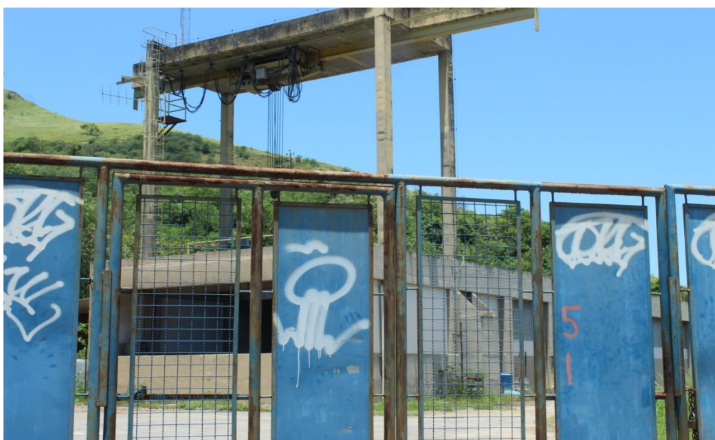
Portão de Acesso ao Reservatório de Marapicu
