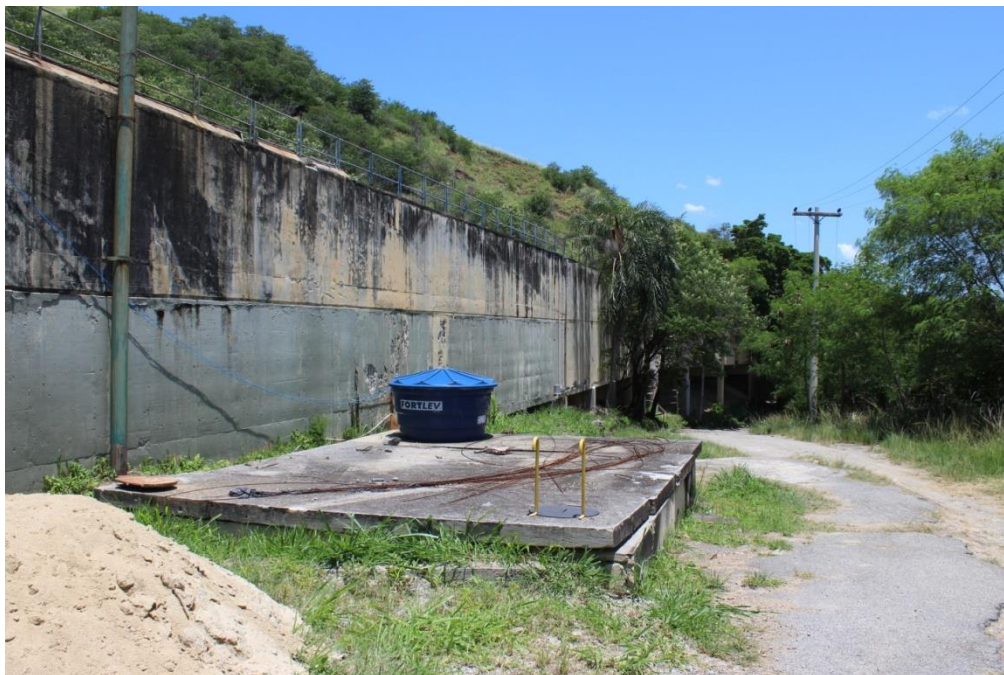
Acesso Interno ao Reservatório
