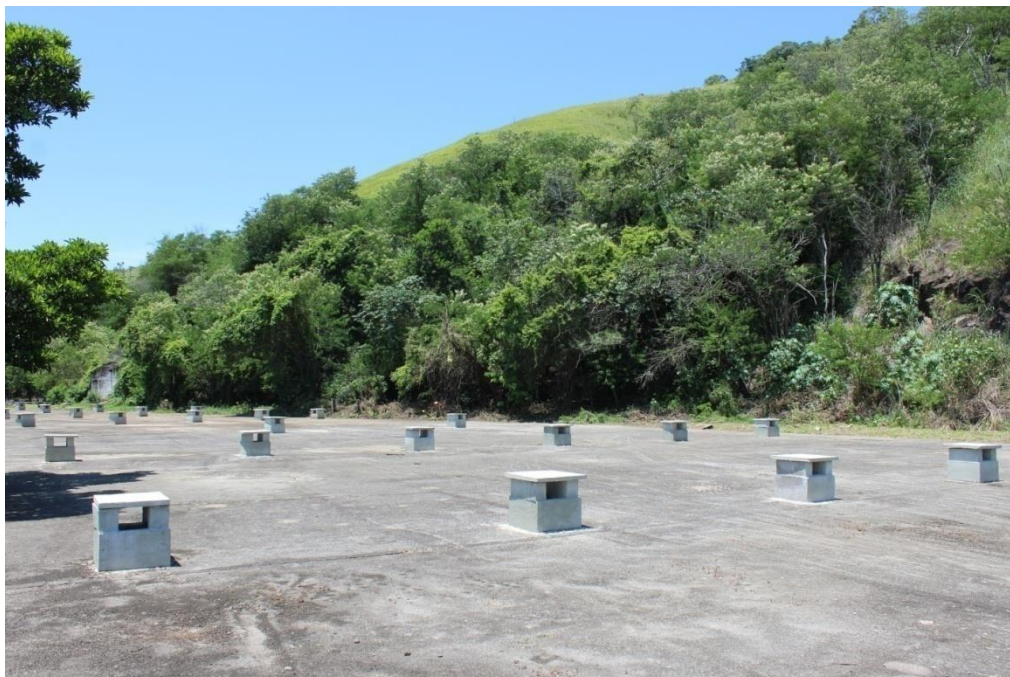
Laje do Reservatório
