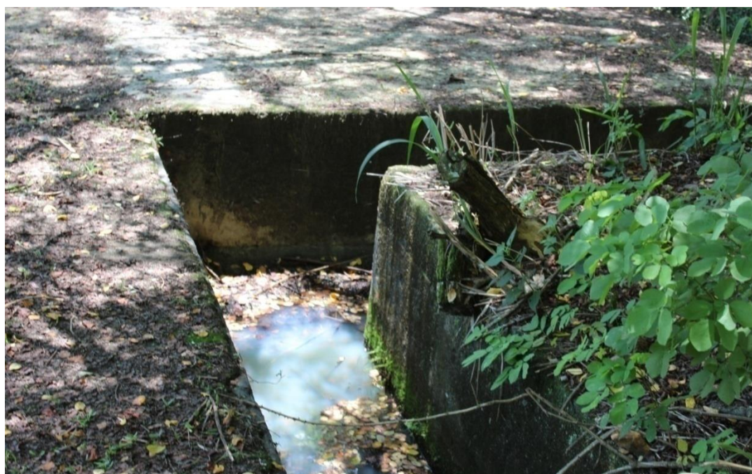
Calha que circunda o Reservatório
