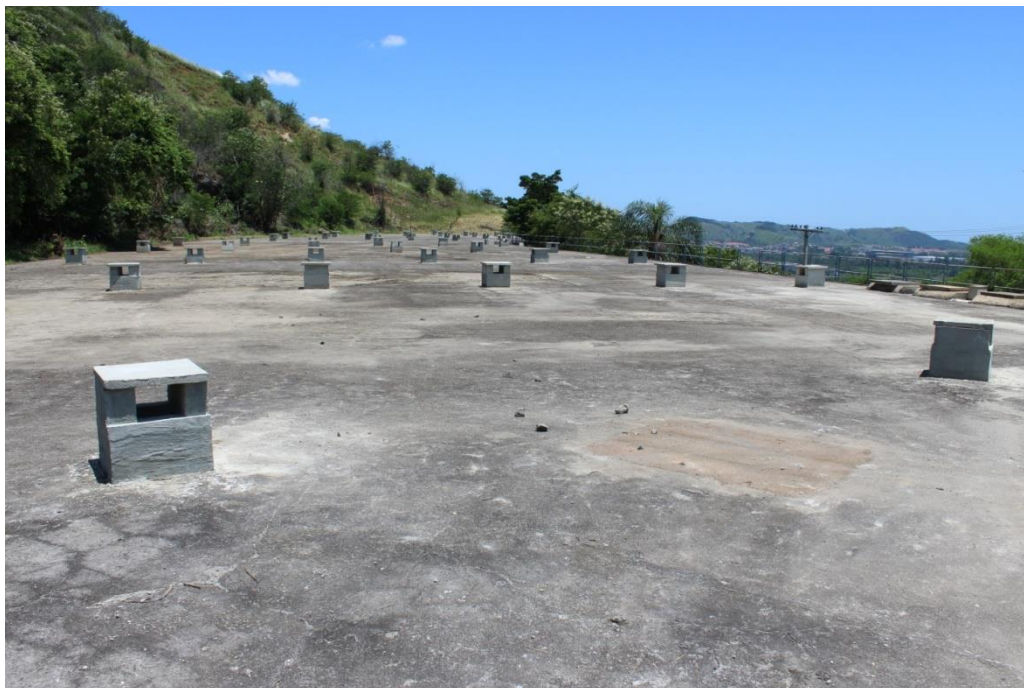
Laje do Reservatório
