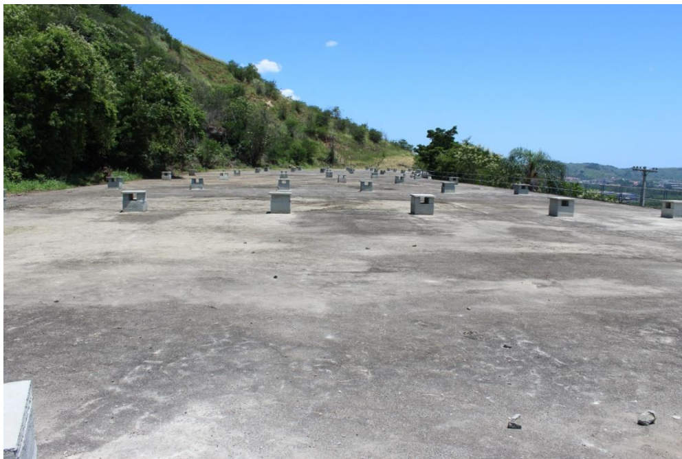
Laje do Reservatório
