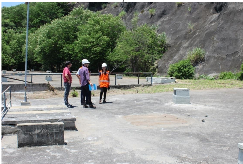
Laje do Reservatório
