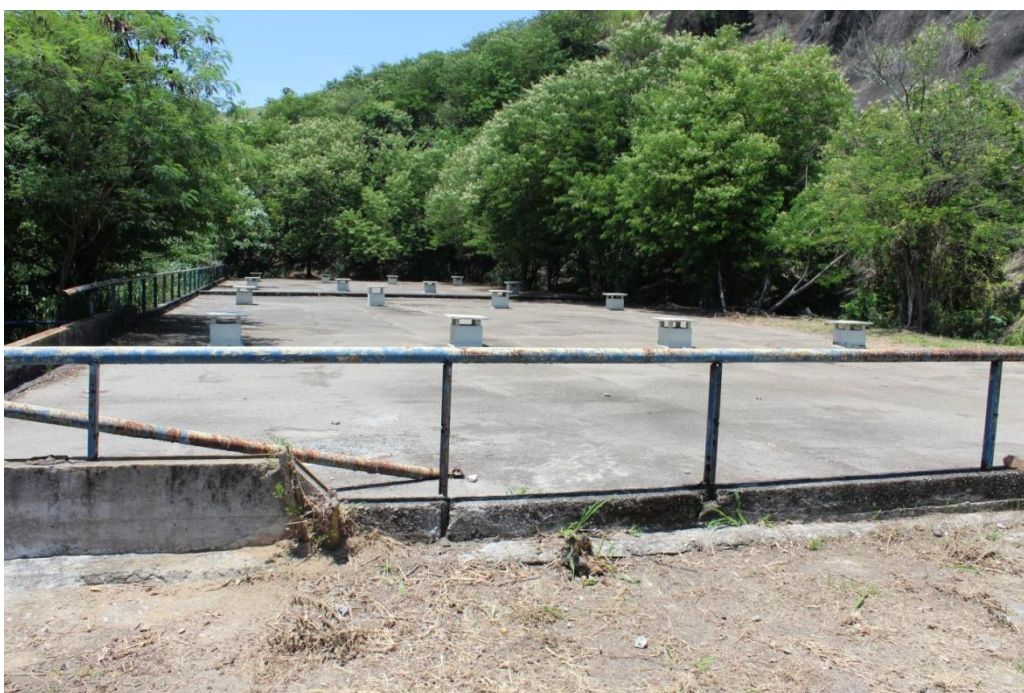
Laje do Reservatório
