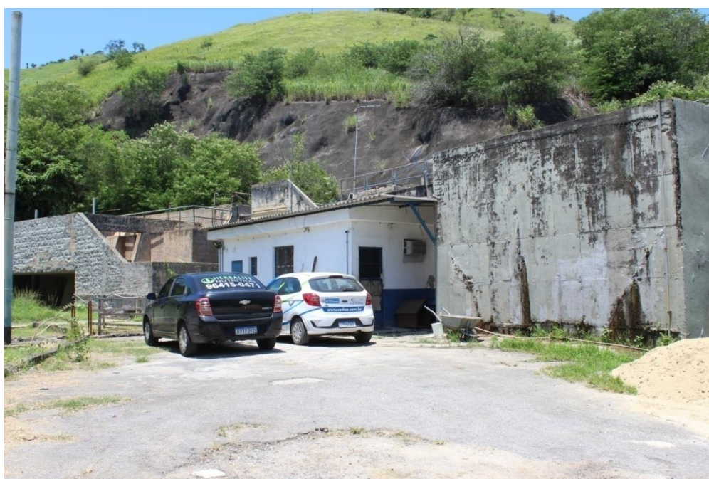
Acesso Interno ao Reservatório
