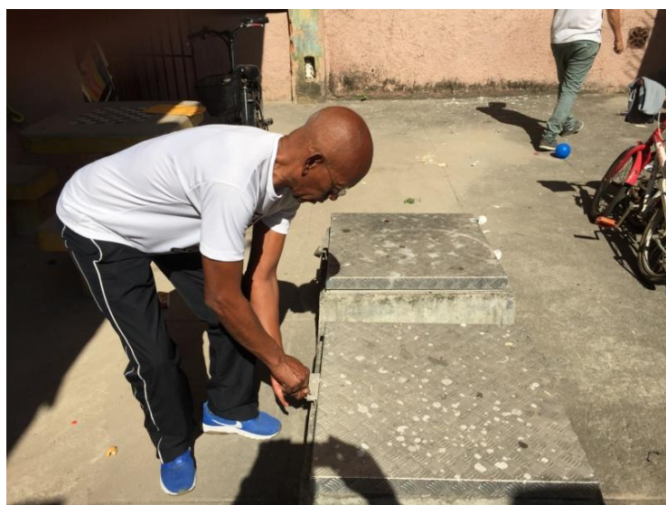
CISTERNAS DE 50.000 LITROS
