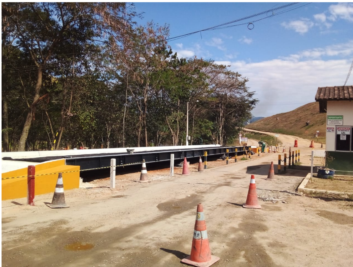
Figura 3: Detalhe da obra da nova Balança
