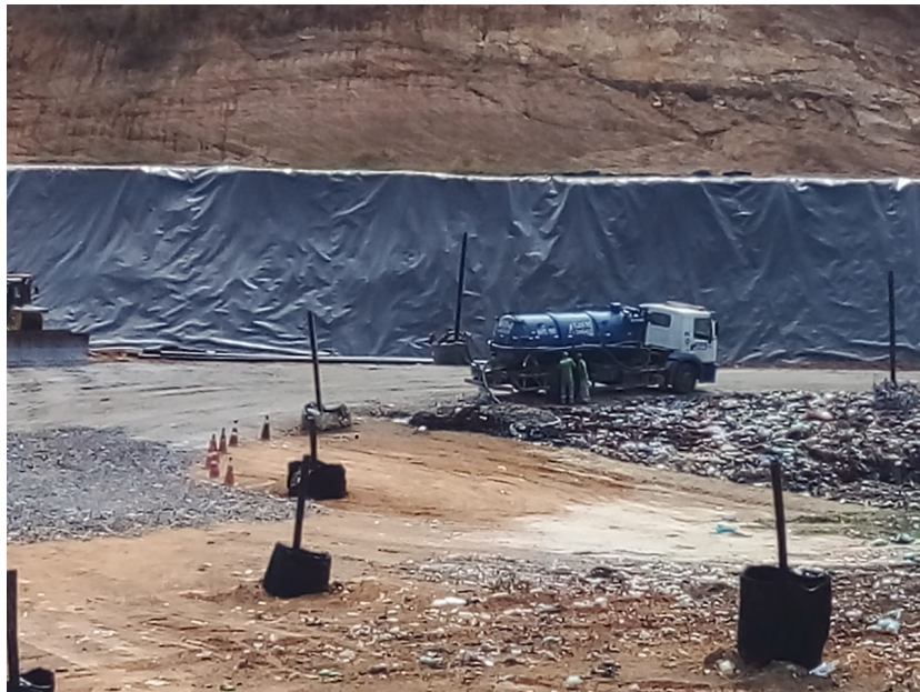
Figura 6: Frente de trabalho e ao fundo a aplicação da geomembrana.
