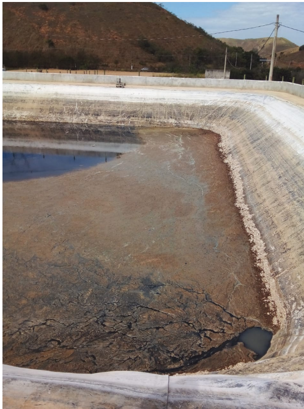
Figura 11 : Lodo da lagoa em manutenção
