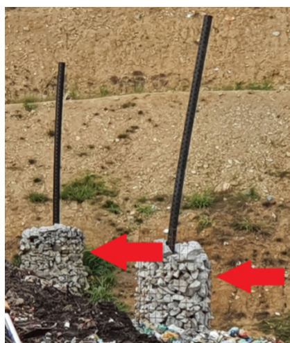
Figura 21: Vista dos dutos secundários de biogás
