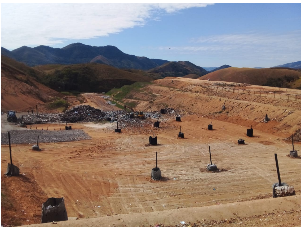
Figura 7: Vista aérea da frente de trabalho
