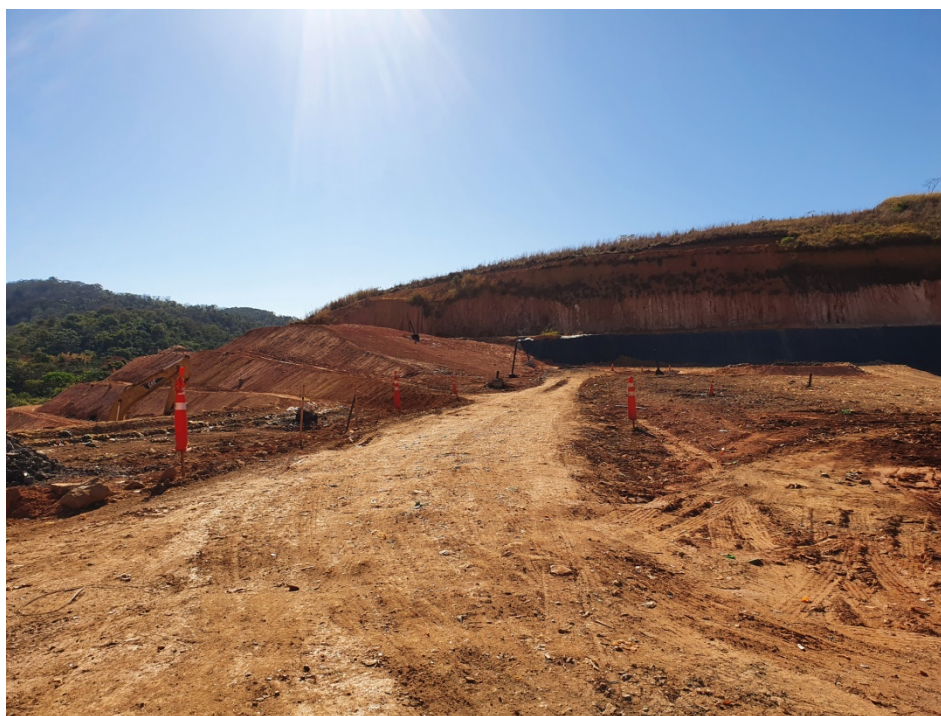
Figura 6: Vista de perfil da célula b.2, onde é possível visualizar três camadas, o sistema de drenagem de gases, com os drenos verticais (responsável por coletar e direcionar os gases de dentro do maciço para o ar atmosférico), geomembrana de PEAD e escavadeira
