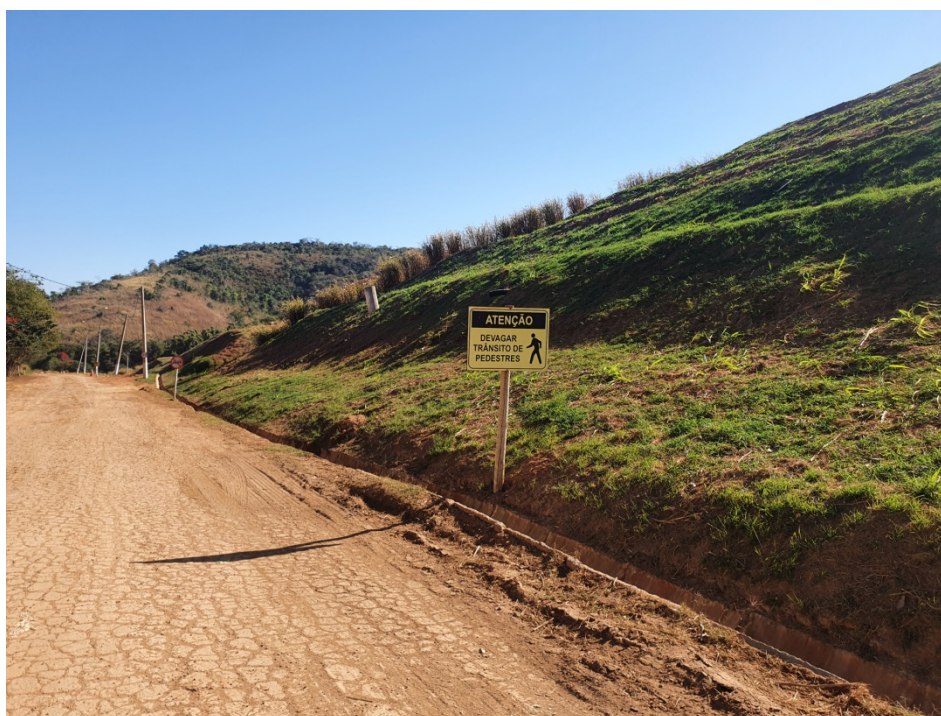
Figura 8: Vista do setor A, ainda sem remediação.
