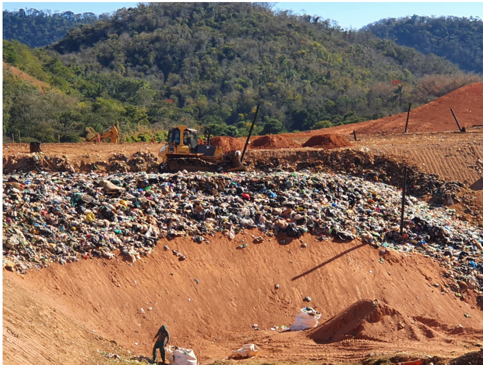
Figura 4: Frente de trabalho com resíduo sendo compactado.
