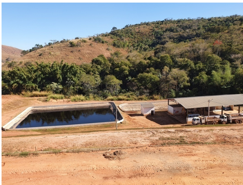
Figura 11: Vista, à esquerda, da lagoa de acumulação de lixiviado e, à direita, do galpão que seria utilizado para a realização da triagem, e/ou coleta seletiva.
