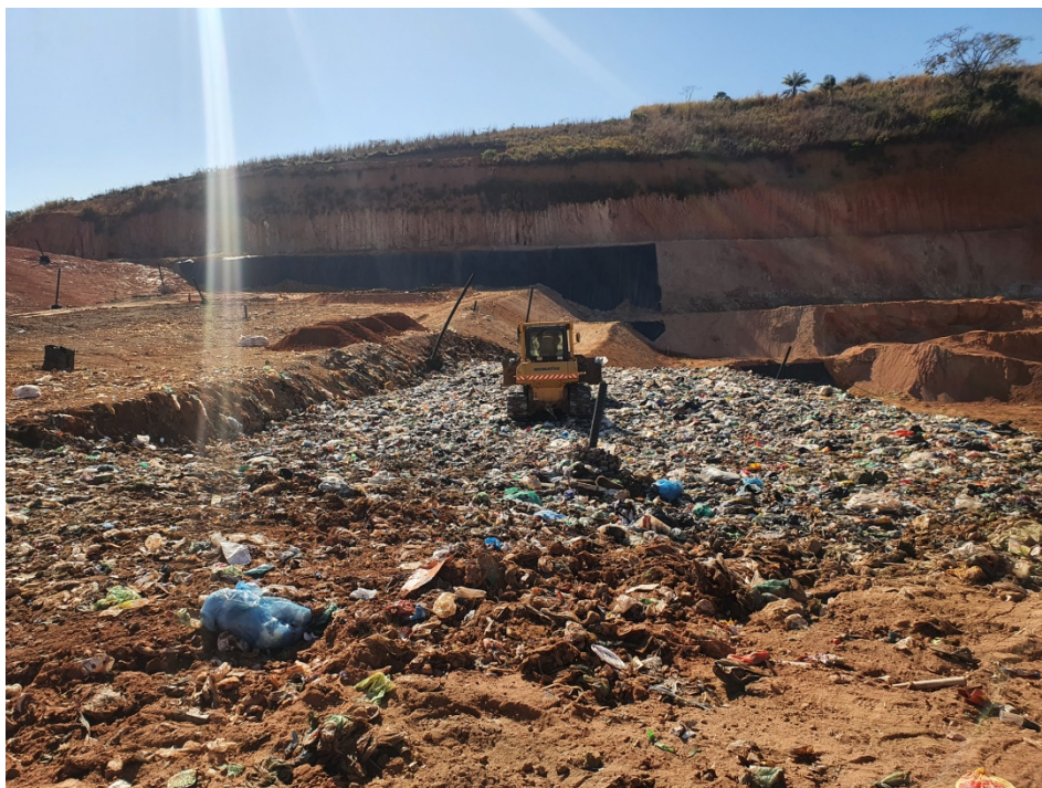
Figura 5: Vista da frente de trabalho.
