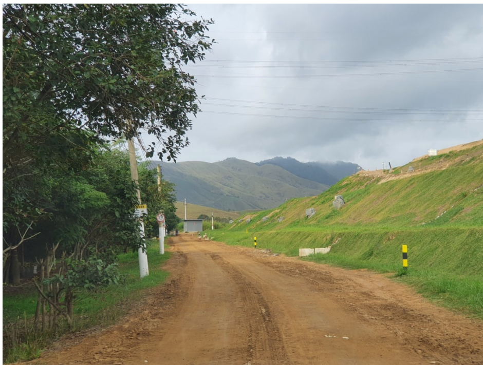
Figura 10: Estrada de acesso à Estação de Tratamento de Chorume.
