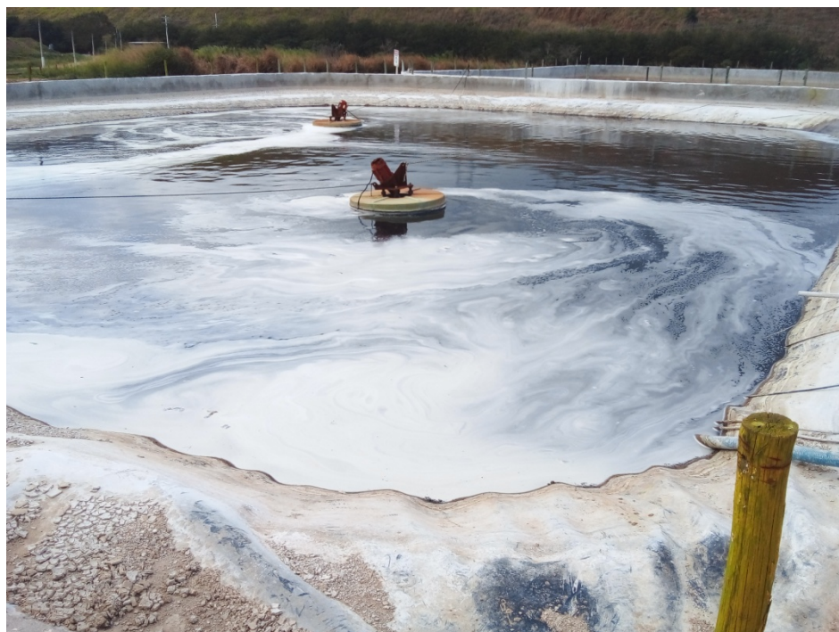
Figura 11: Lagoa de chorume com aerador em funcionamento, que são equipamentos que trabalham na superfície das lagoas e têm função de oxigenar o chorume, acarretando um processo mais rápido de decomposição.
