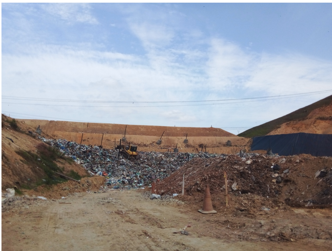
Figura 9: Vista das fases da frente de operação.
