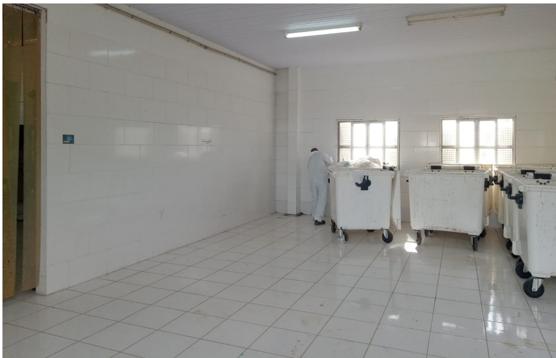
Figura 19: Vista do galpão de armazenamento temporário com presença de RSS nas caçambas.
