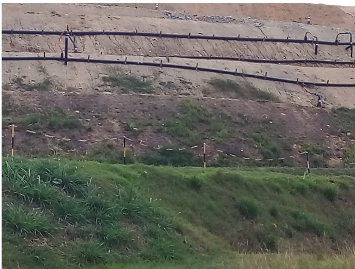
Figura 21: Vista das camadas do maciço e dos dutos de biogás.
