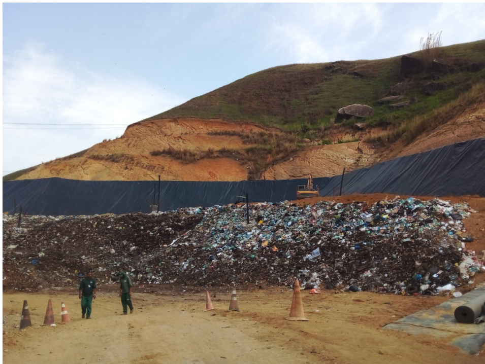
Figura 8: Vista das camadas com a aplicação da geomembrana.
