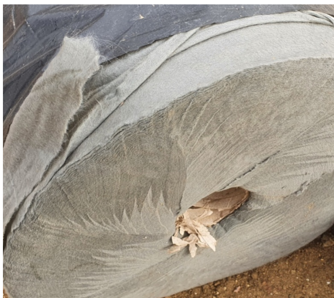
Figura 6: Manta geotextil utilizada acima da camada de proteção mecânica, a fim de que não haja passagem de resíduos para os dutos e drenos. Seu uso é feito abaixo do dreno para proteger a camada mecânica.
