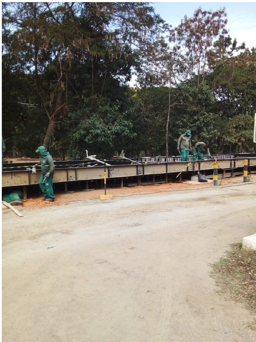
Figura 3: Vista da obra para instalação da nova balança de pesagem.
