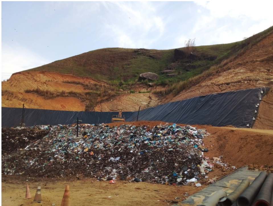
Figura 7: Vista das camadas com a aplicação da geomembrana.
