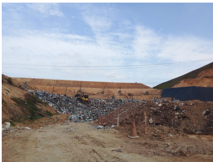
Figura 5: Vista do acesso à frente de trabalho.
