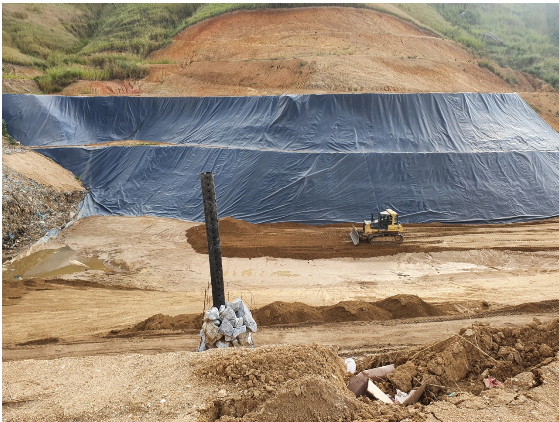
Figura 2: Vista da frente de trabalho sendo preparada.
