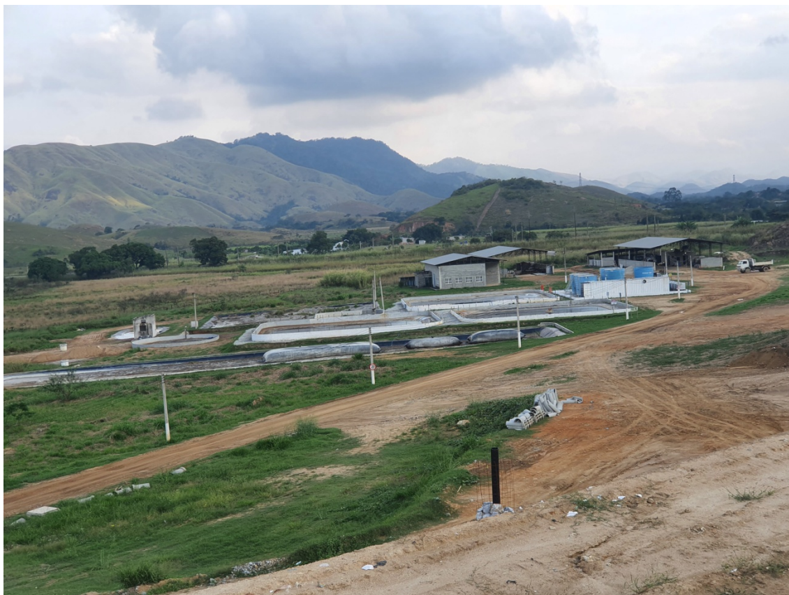
Figura 3: Vista da área do tratamento do chorume.
