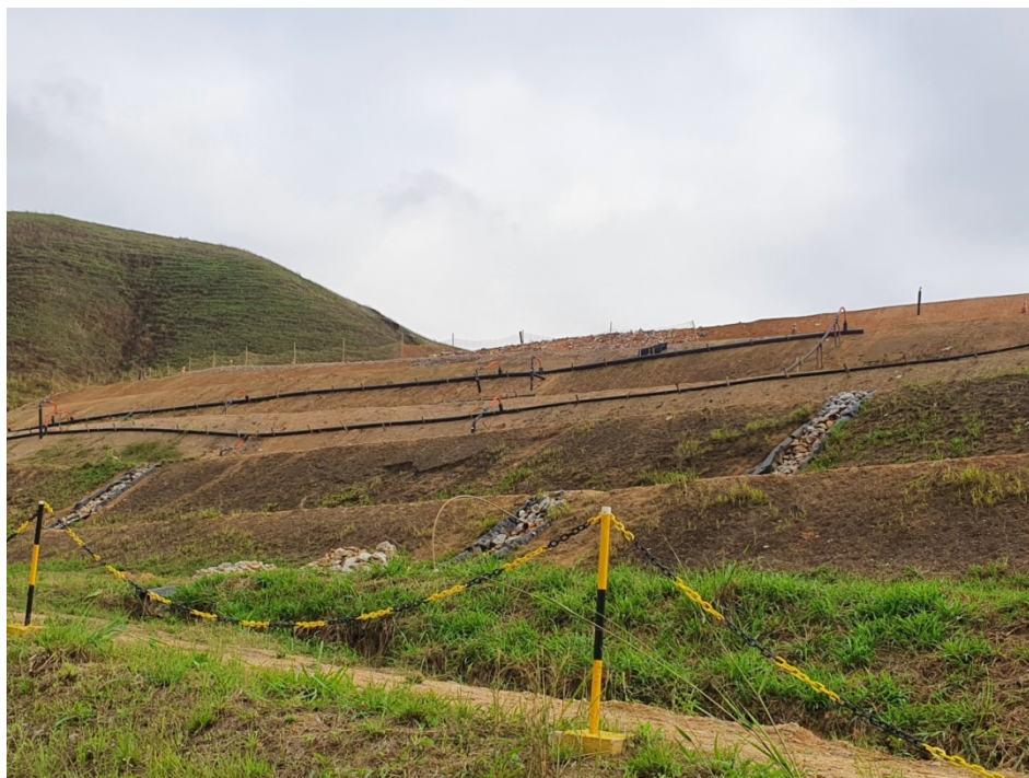
Figura 16: Vista das camadas do maciço e dos dutos de biogás.
