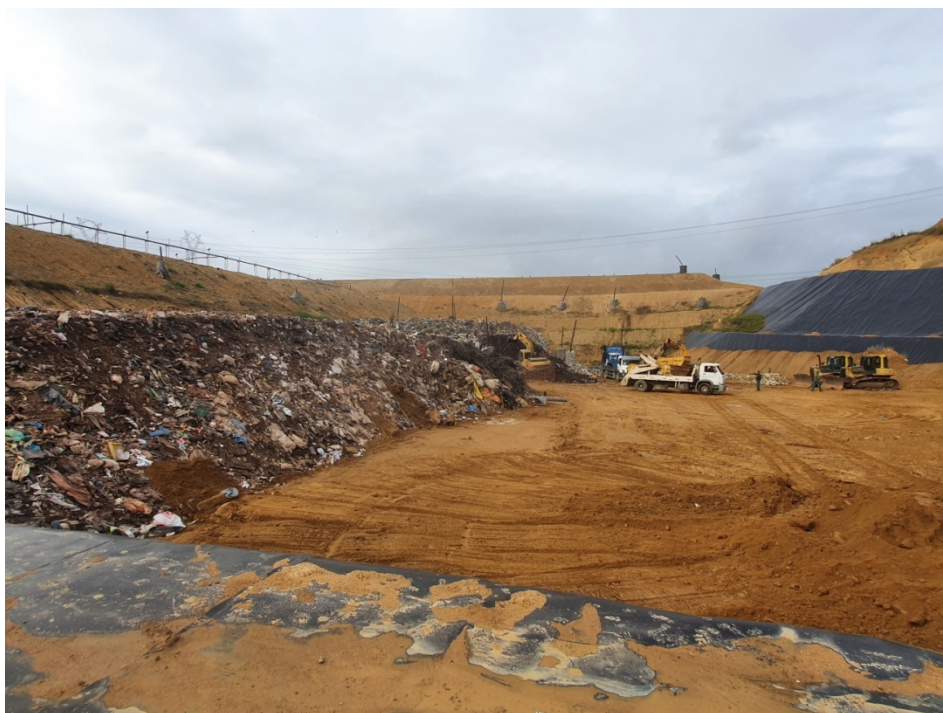
Figura 7: Vista das fases da frente de operação.
