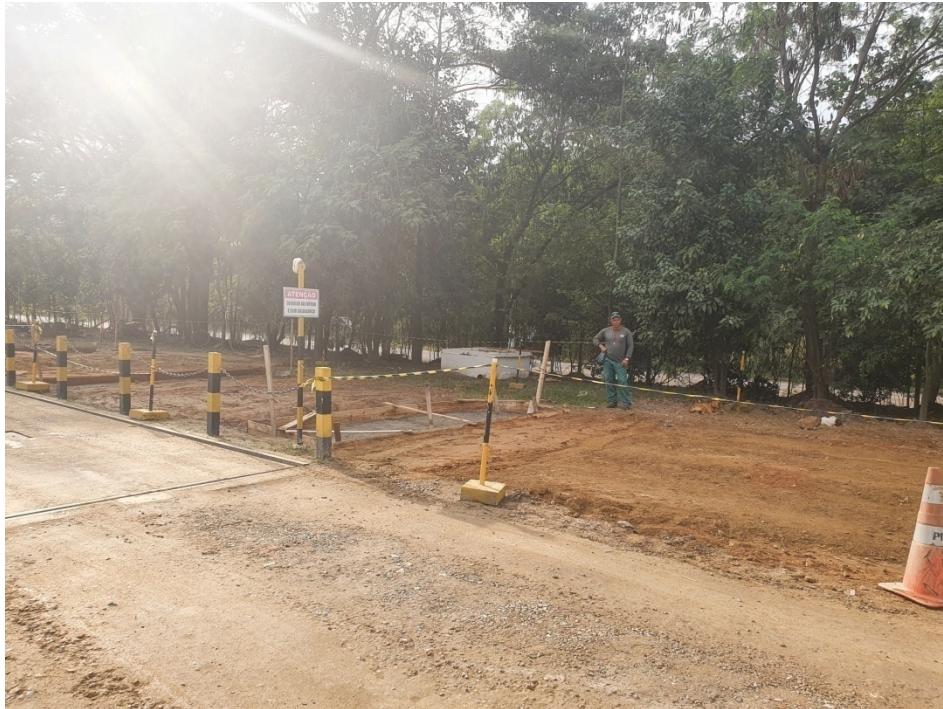
Figura 3: Vista da obra para instalação da nova balança de pesagem.
