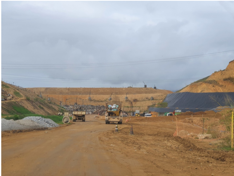
Figura 5: Vista do acesso à frente de trabalho.
