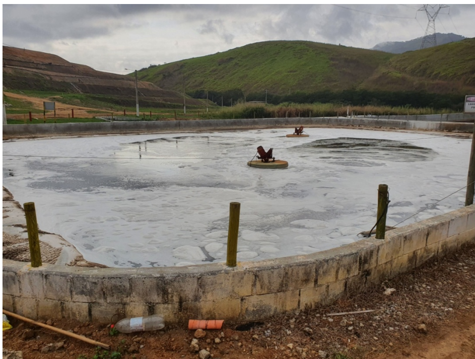
Figura 10: Lagoa de chorume com aerador em funcionamento, que são equipamentos que trabalham na superfície das lagoas e têm função de oxigenar o chorume, acarretando um processo mais rápido de decomposição.
