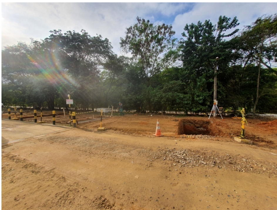
Figura 4: Vista da obra para instalação da nova balança de pesagem.
