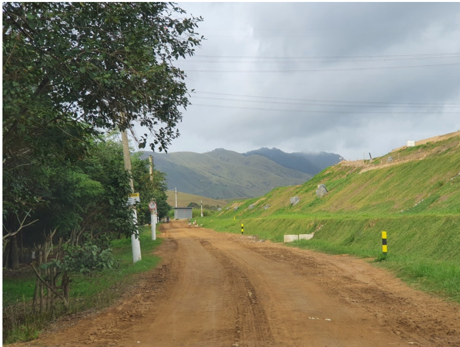
Figura 9: Estrada de acesso à Estação de Tratamento de Chorume.
