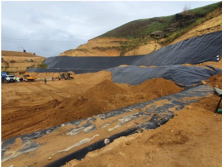
Figura 6: Vista das camadas com a aplicação da geomembrana.
