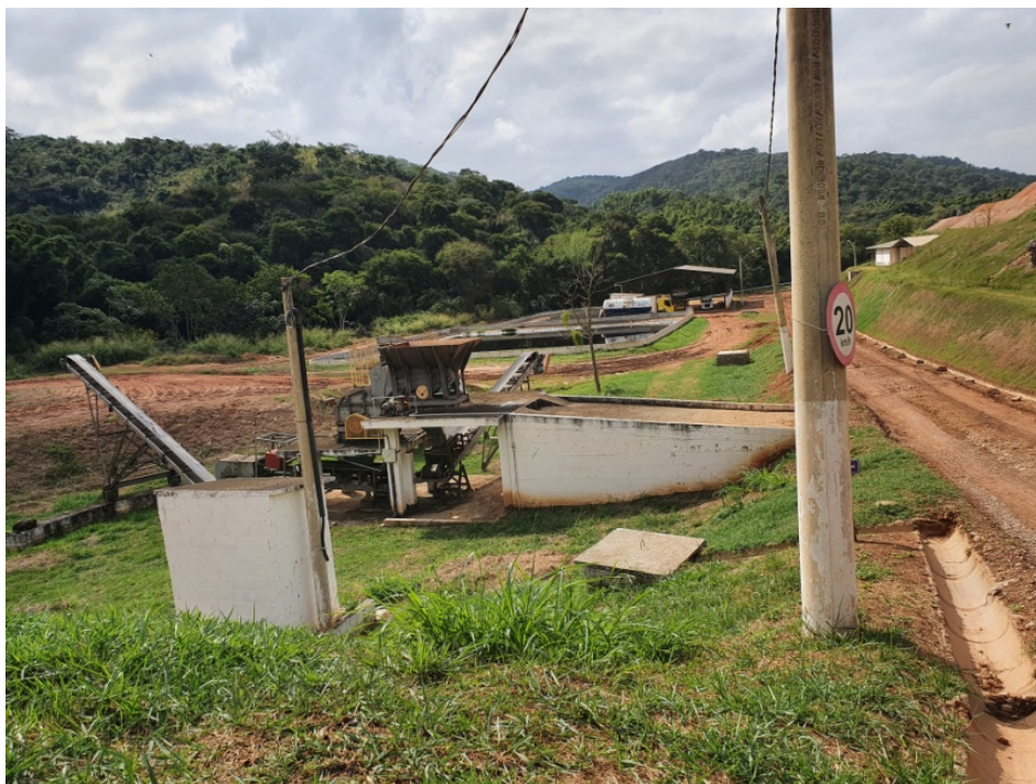
Figura 20: Britador disponibilizado para realizar a trituração de RCC. Inoperante.
