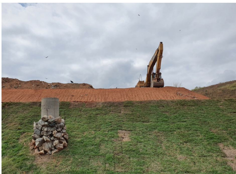
Figura 14: Vista de camada concluída com a presença de revestimento vegetal (gramínea) e dreno vertical de gás. Acima, camada concluída, porém, sem a presença de vegetação. Adiante, camada e escavadeira em operação. É notória a presença de aves.
