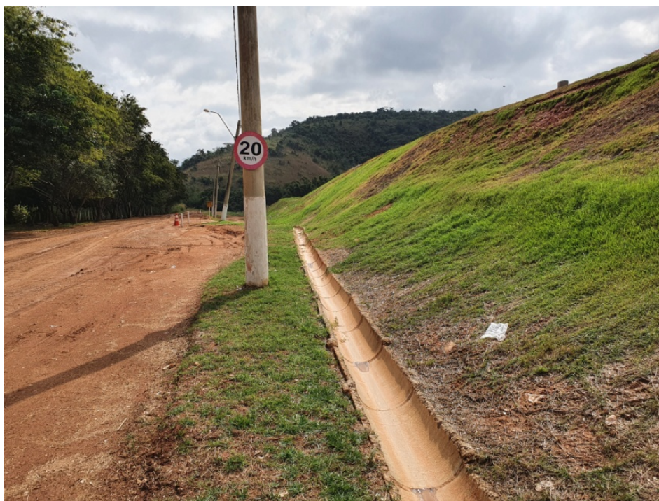
Figura 13: Vista de placa de sinalização interna e das linhas de drenagem horizontais.
