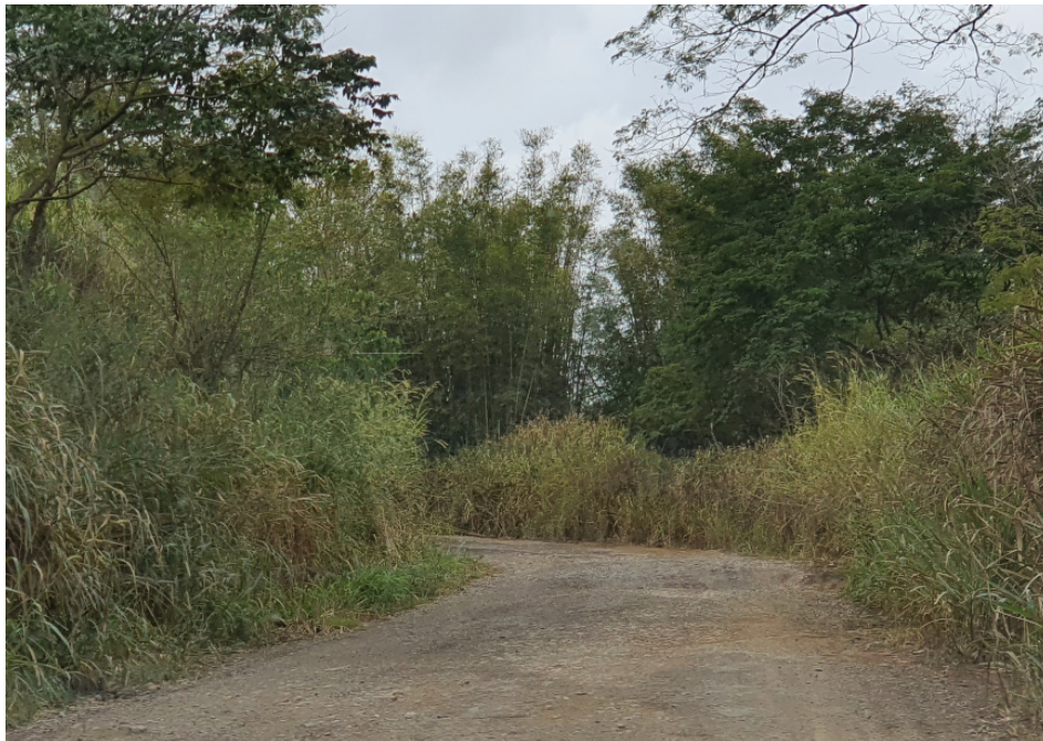
Figura 3: Vista da estrada de acesso com a presença de vegetação marginal invadindo a pista.
