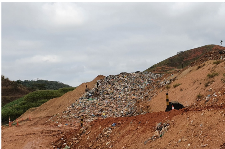
Figura 8: Vista da camada onde está sendo realizada a frente de trabalho, na célula B, etapa 1.
