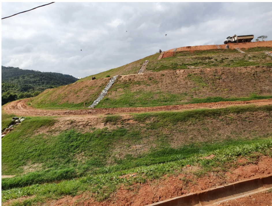
Figura 12: Vista de camadas concluídas da célula b, etapa 1.
