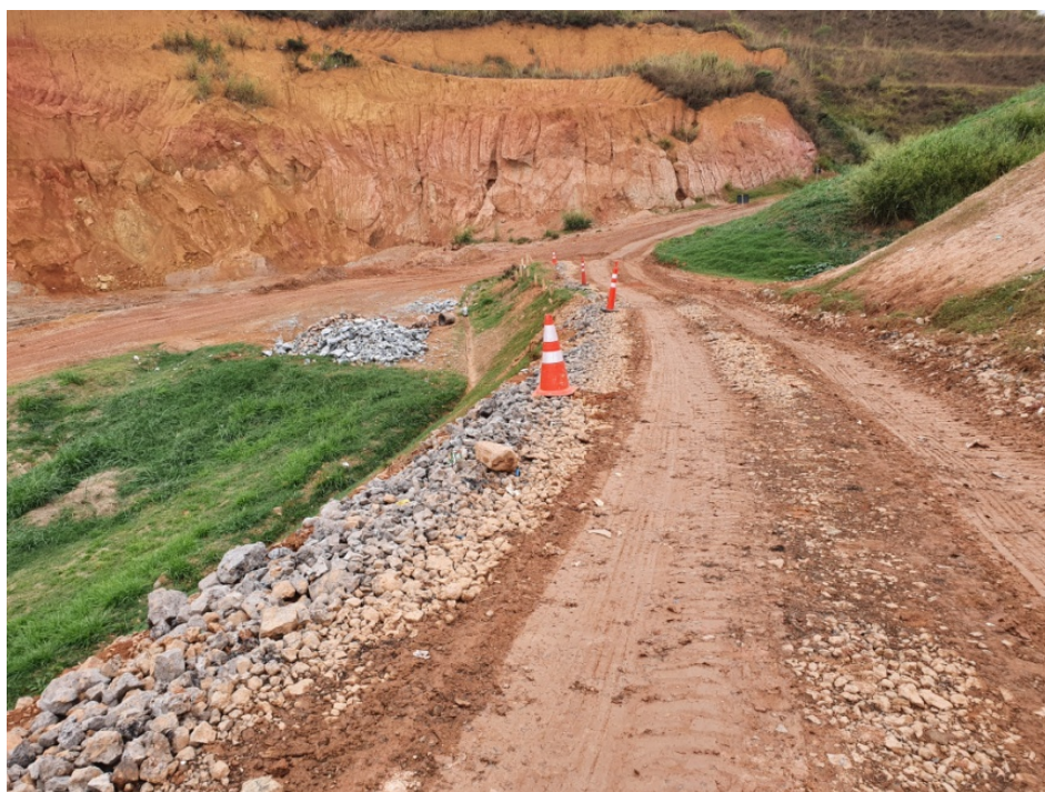
Figura 10: Rampa de acesso à frente de trabalho executada com mistura de solo e agregado siderúrgico.
