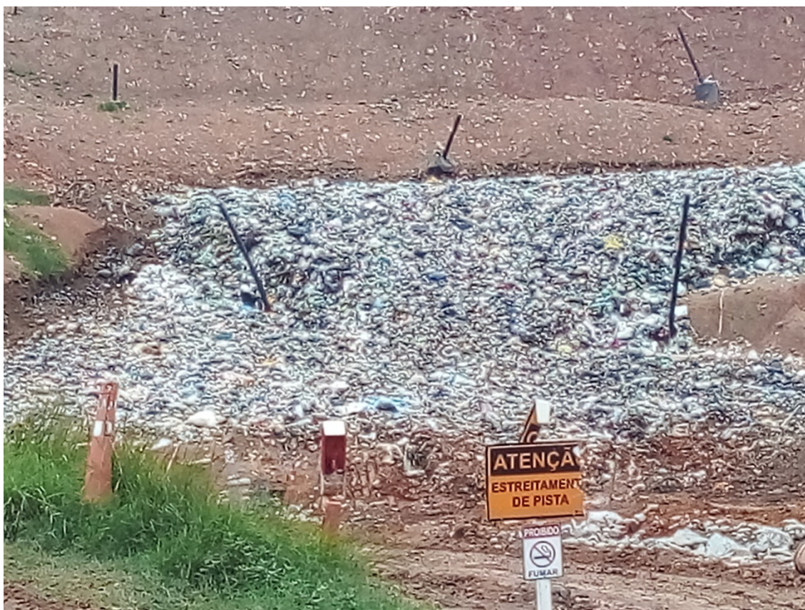
Figura 5: Frente de trabalho. Vale ressaltar que os resíduos ainda estavam sem cobertura pois a quantidade descarregada na manhã da fiscalização foi grande, a cobertura estava sendo realizada no decorrer da fiscalização.
