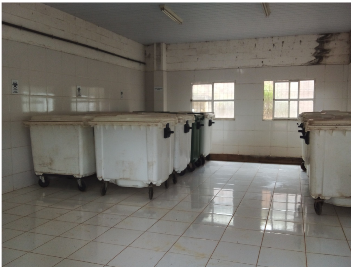
Figura 16: Abrigo temporário de RSS. Onde os resíduos são estocados
