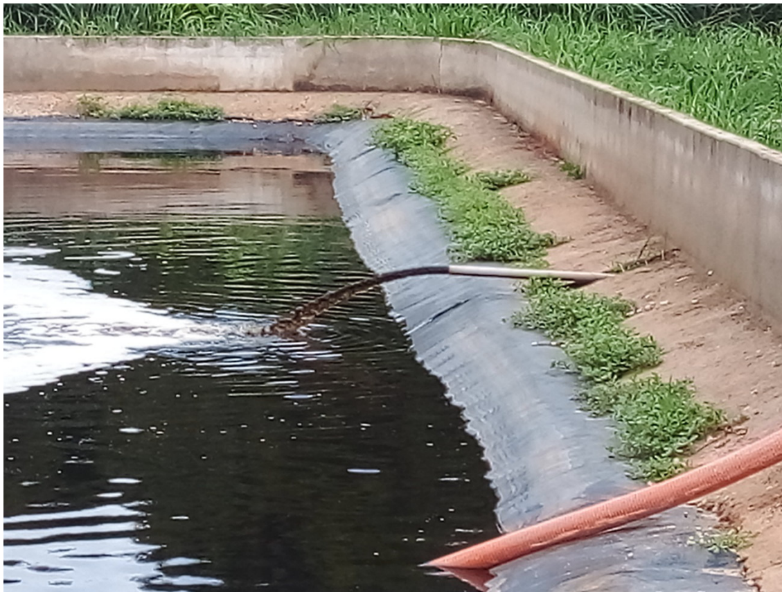
Figura 12: Lagoa de recebimento e armazenagem de chorume.
