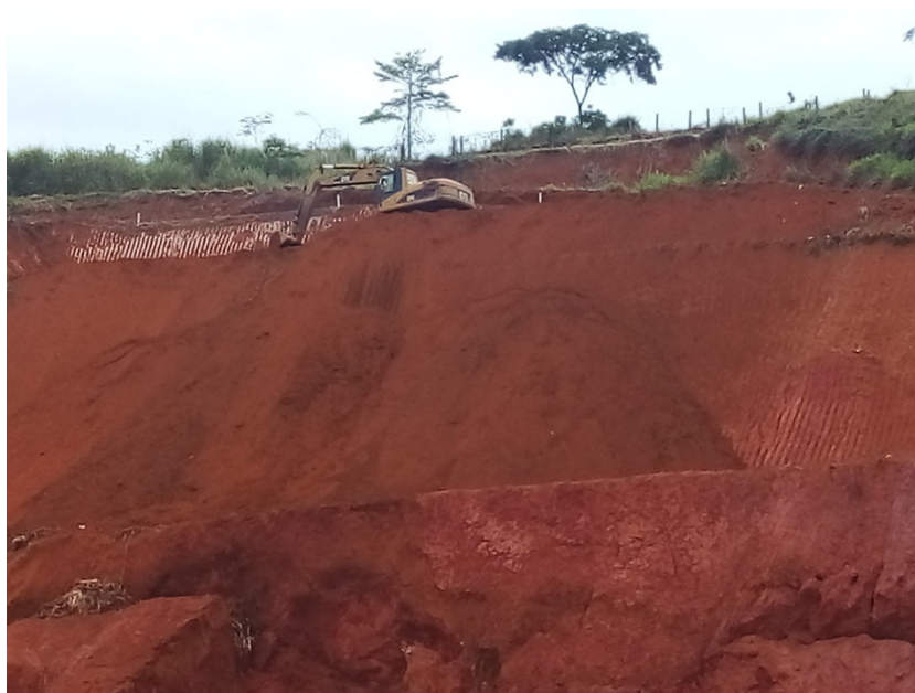
Figura 9: Escavação para preparação de uma nova cota
