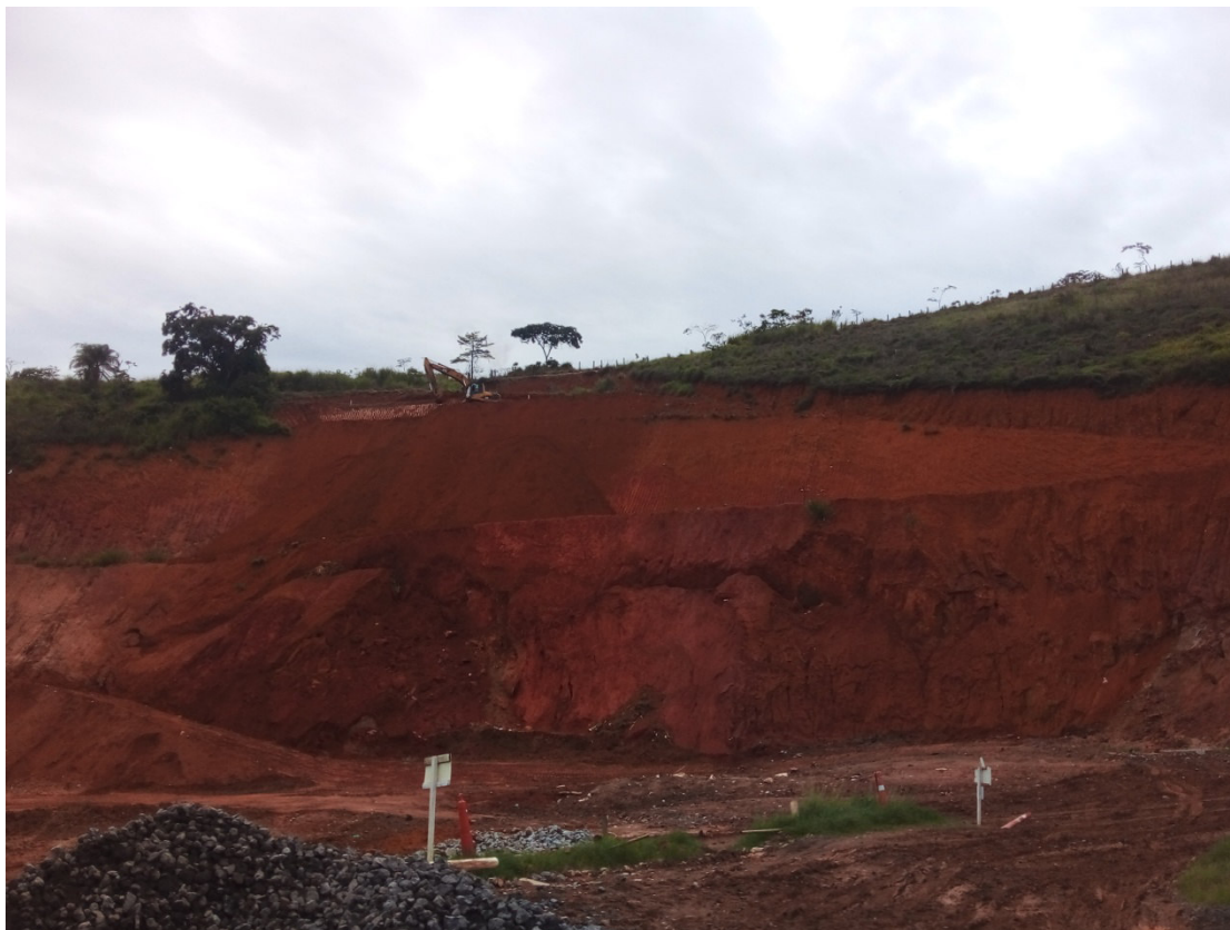
Figura 8: Escavação para preparação de uma nova cota
