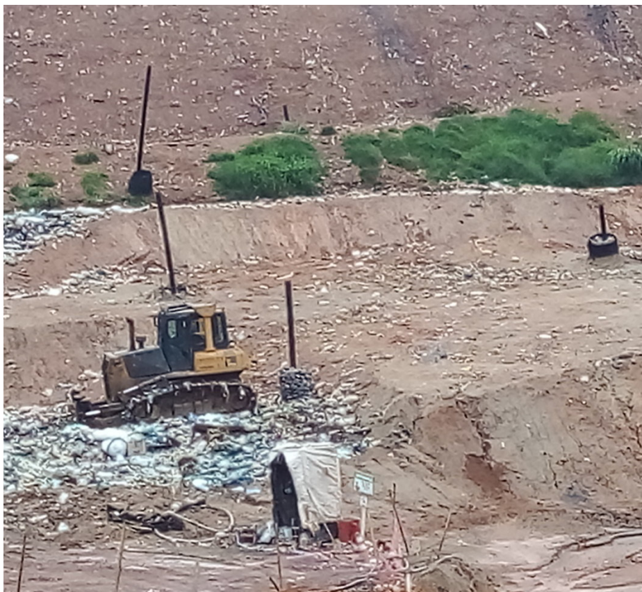
Figura 6: Frente de trabalho. Equipamento operando para recobrir os resíduos
