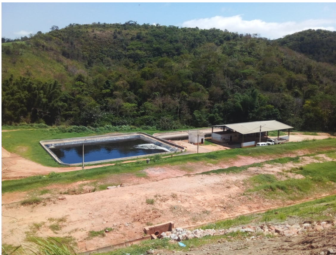
Figura 13: Vista panorâmica da lagoa de armazenagem de chorume
