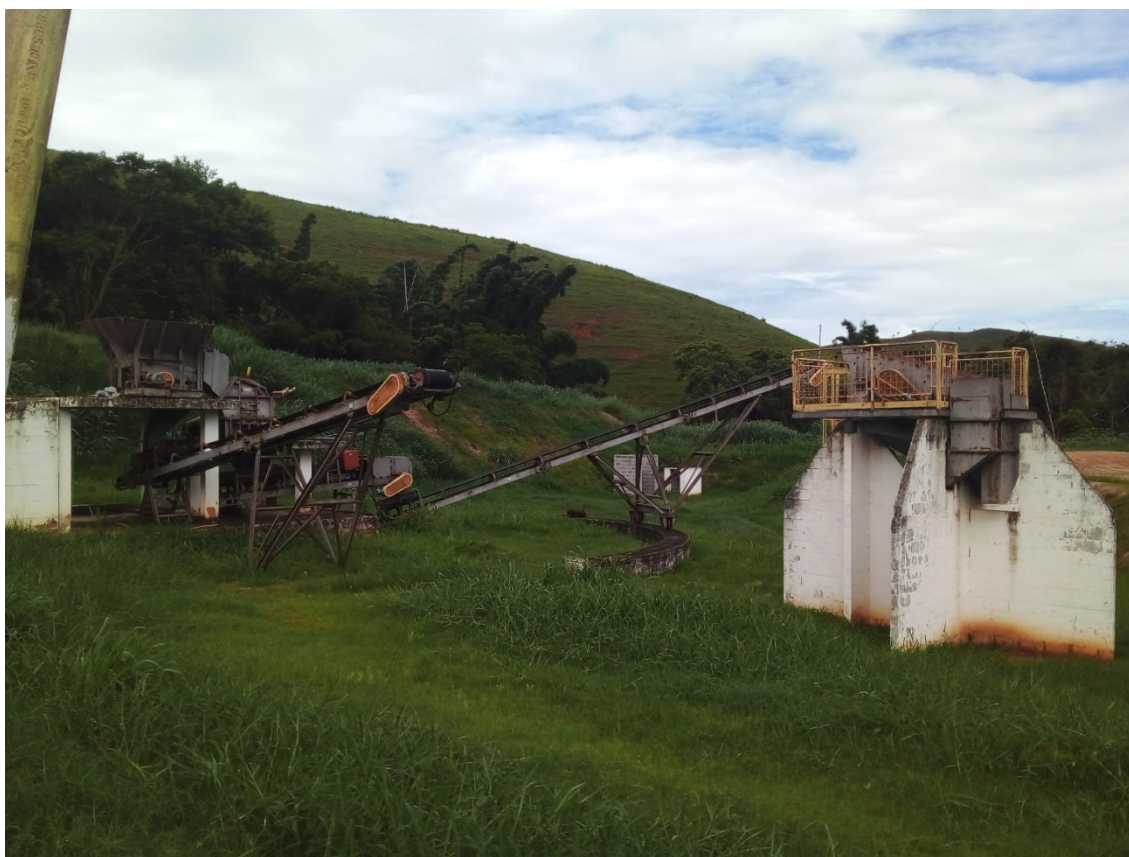
Figura 20: Britador de resíduos da construção civil. Há um funcionamento muito abaixo do esperado ,esporadicamente tem sido posto em operação
