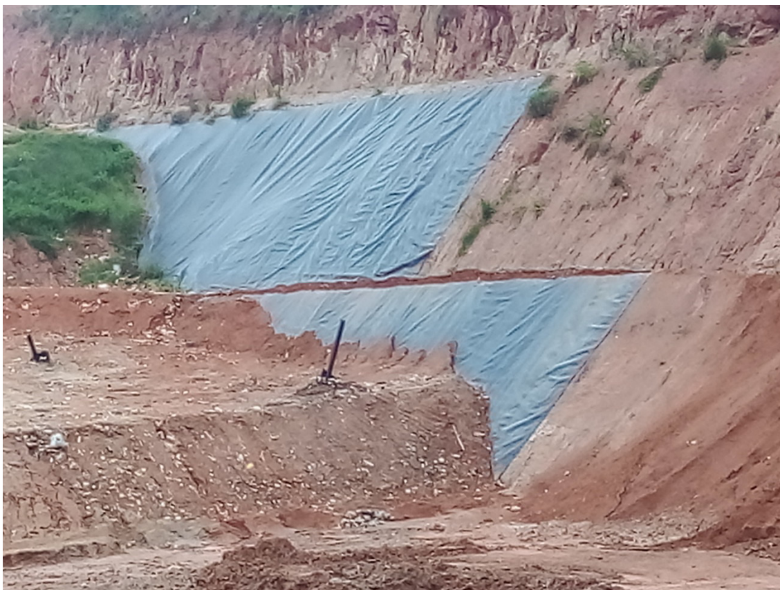
Figura 7: Aplicação da Geomembrana
