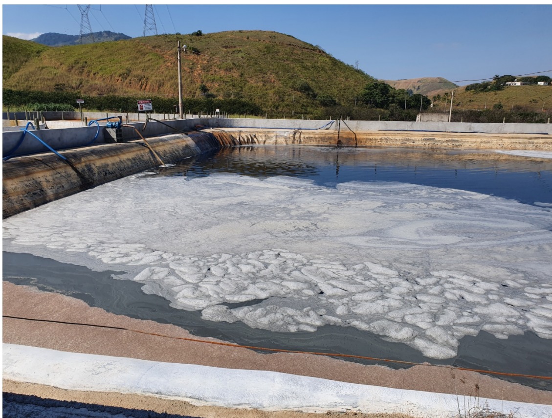
Figura 06: Lagoa de tratamento de chorume.
