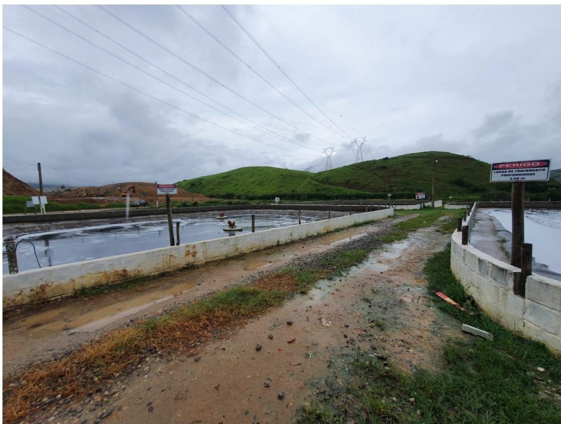
Figura 04: Lagoa de chorume com aerador em funcionamento.
