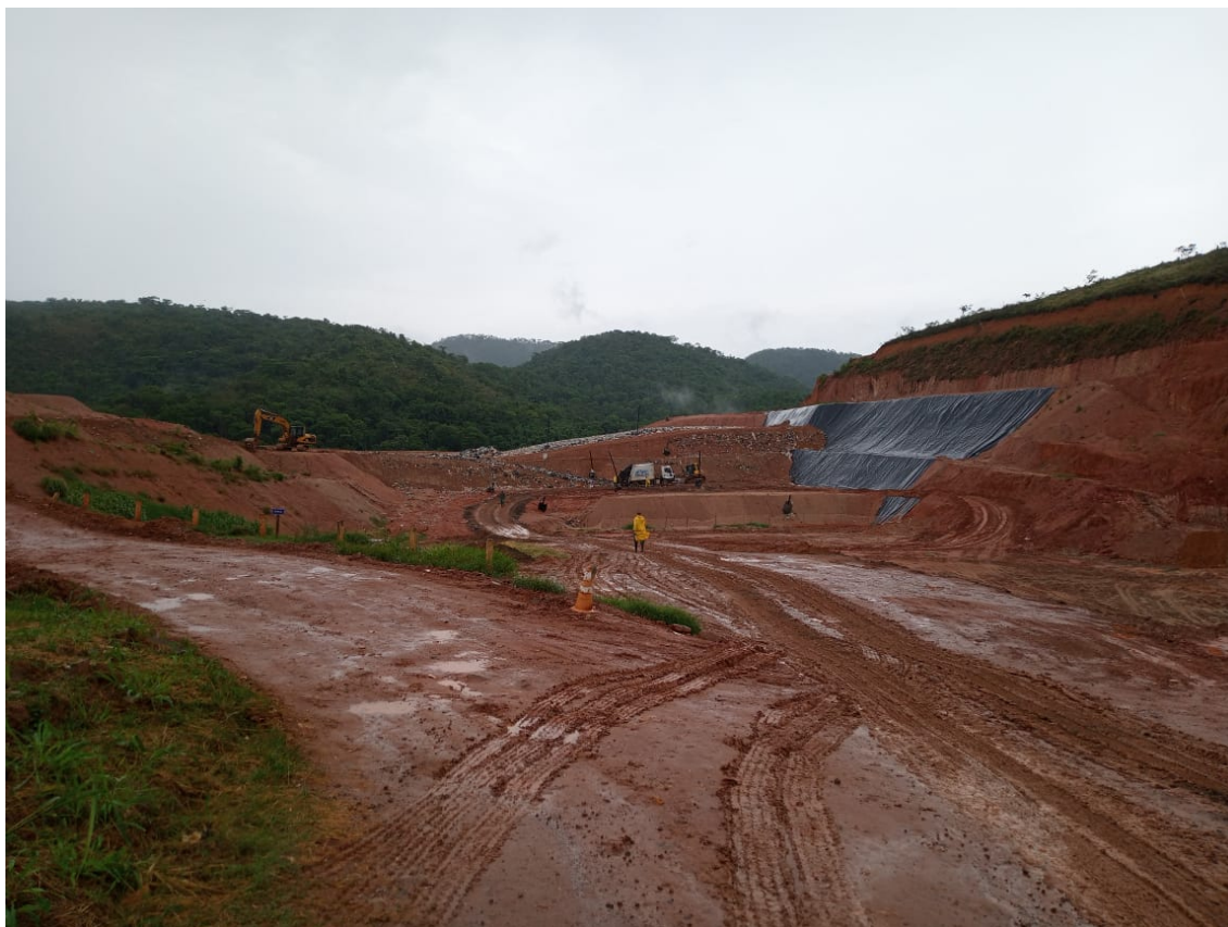
Figura 03: Vista da frente de trabalho.
