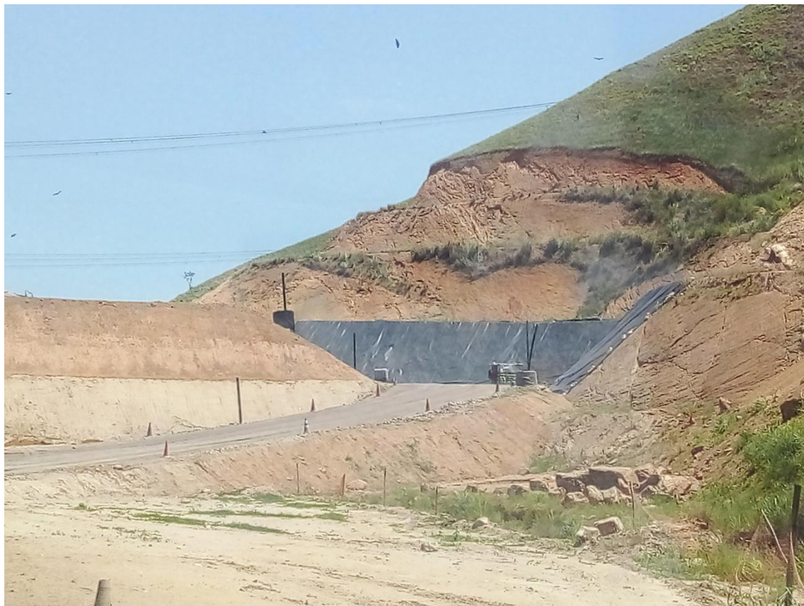
Figura 7: Preparação de nova célula para futura operação.
