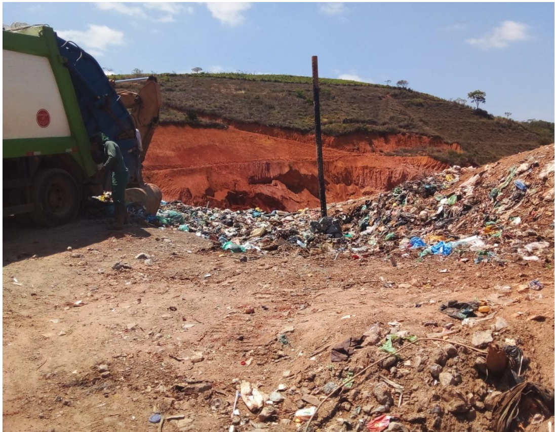
Figura 5: Frente de trabalho, caminhão descarregando
