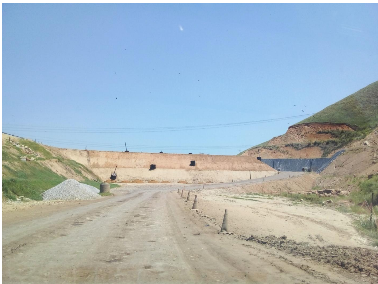
Figura 8: Preparação de nova célula para futura operação.
