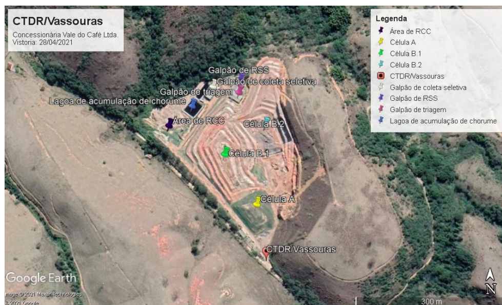
Figura 1: Vista aérea do CTDR/Vassouras. Fonte: Google Earth, 28/04/2021.
