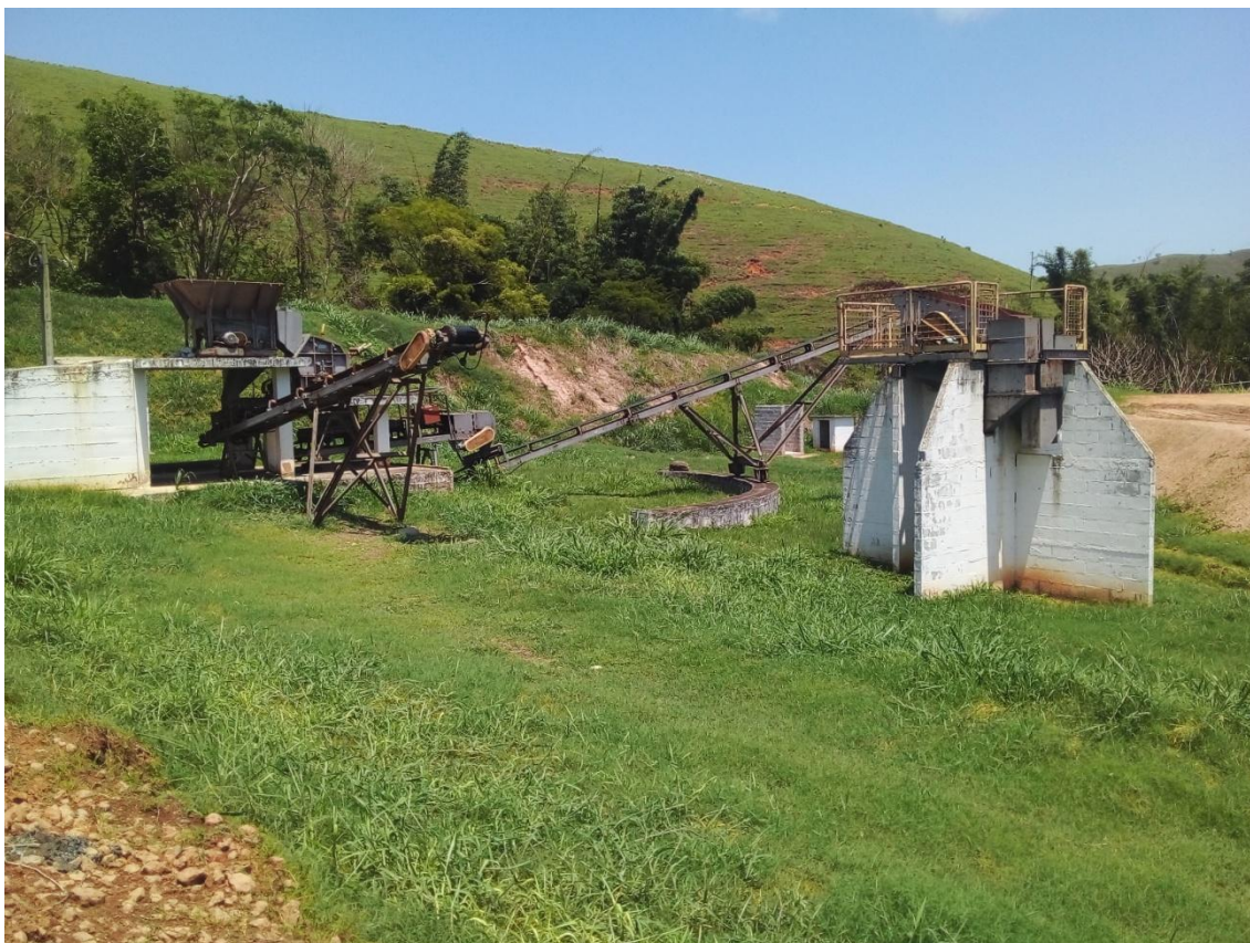
Figura 17: Britador de resíduos da construção civil. Há um funcionamento muito abaixo do esperado ,esporadicamente tem sido posto em operação
