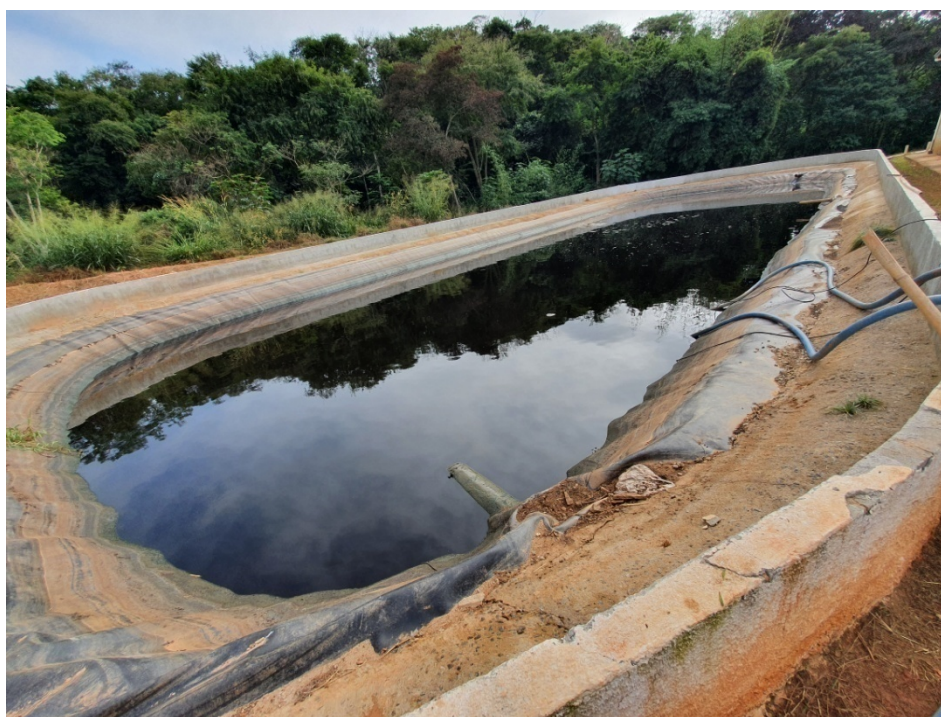
Figura 8: Lagoa de armazenamento de chorume.
