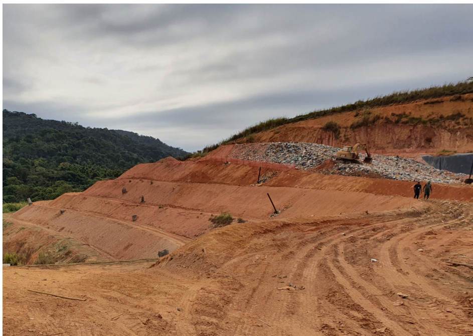
Figura 5: Vista de camadas operadas e da frente de trabalho, à direita.
