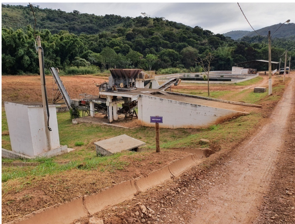
Figura 11: Britador de resíduos da construção civil.
