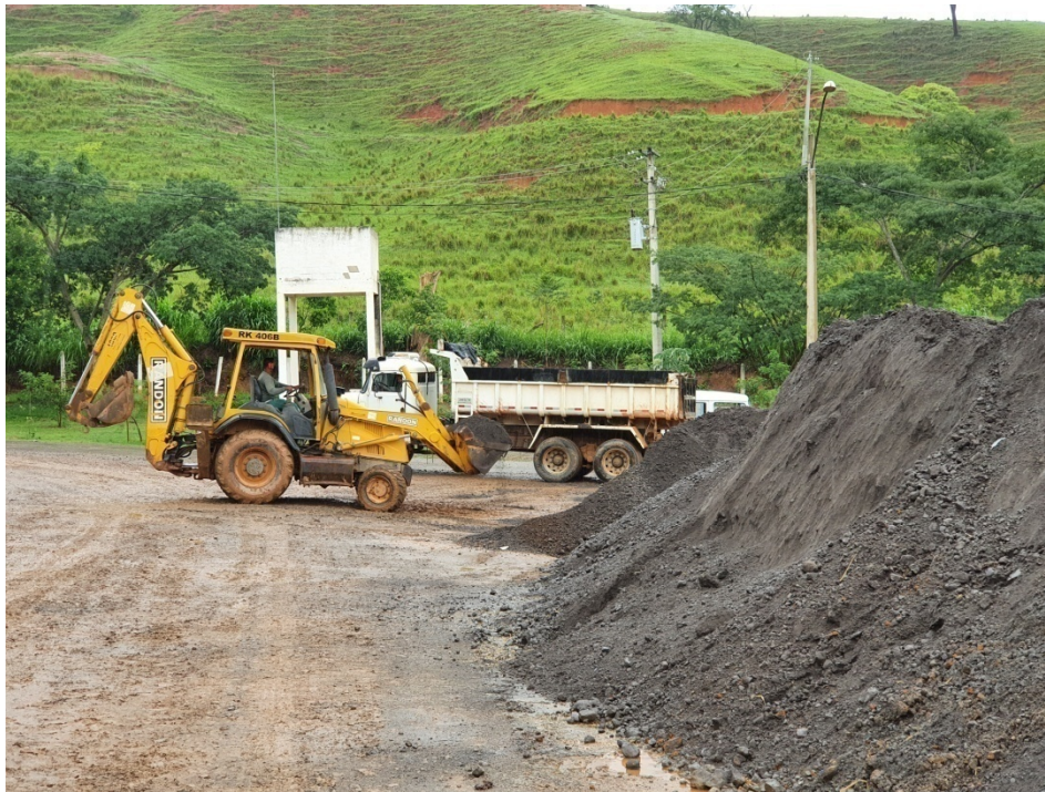
Figura 8: Vista do agregado utilizado para pavimentação as vias e da estrada de acesso ao aterro. Nota-se retroescavadeira realizando o carregamento desse material para os caminhões.
