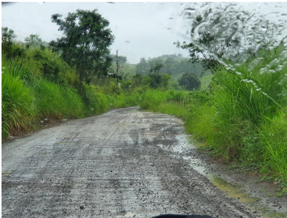
Figura 2: Estrada de acesso apresentando boas condições.
