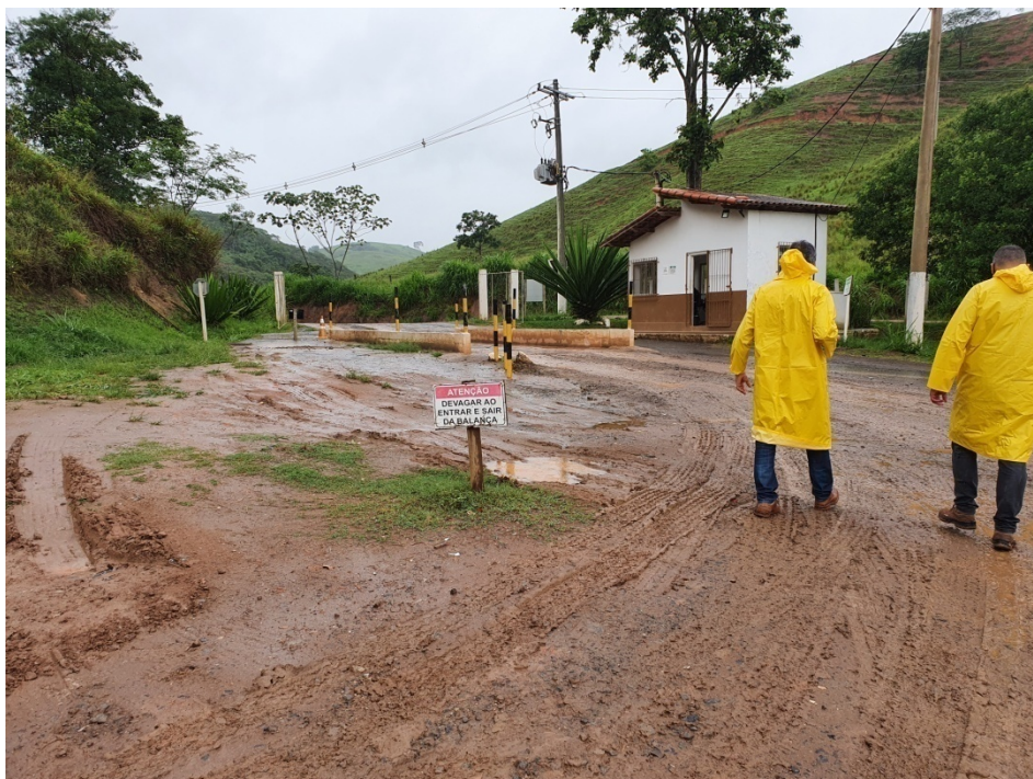
Figura 9: Entrada do CTDR e balança de pesagem, vista de dentro.
