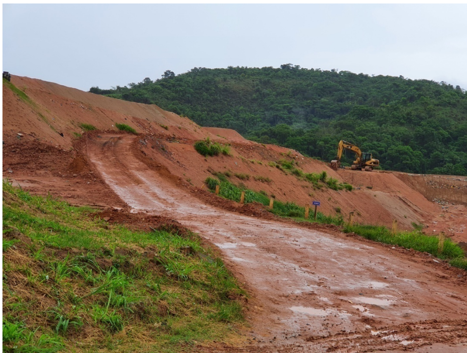
Figura 5: Vista da rampa de acesso e camadas da etapa 1, da célula b.
