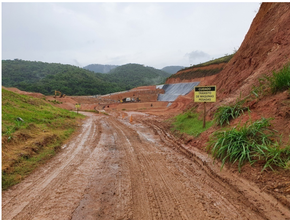
Figura 7: Acesso à frente de trabalho.
