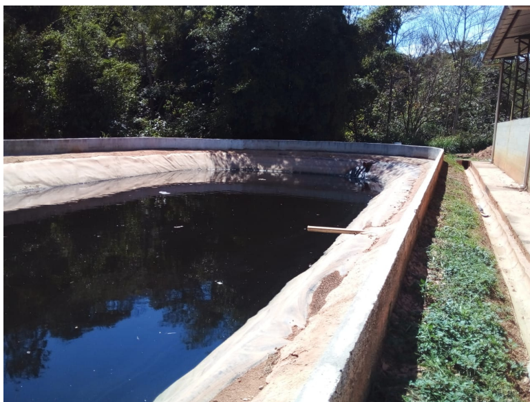
Figura 08: Lagoa de recebimento e armazenamento de chorume.
