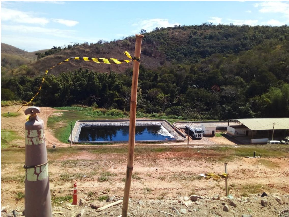
Figura 11: Vista panorâmica da lagoa de armazenamento de chorume
