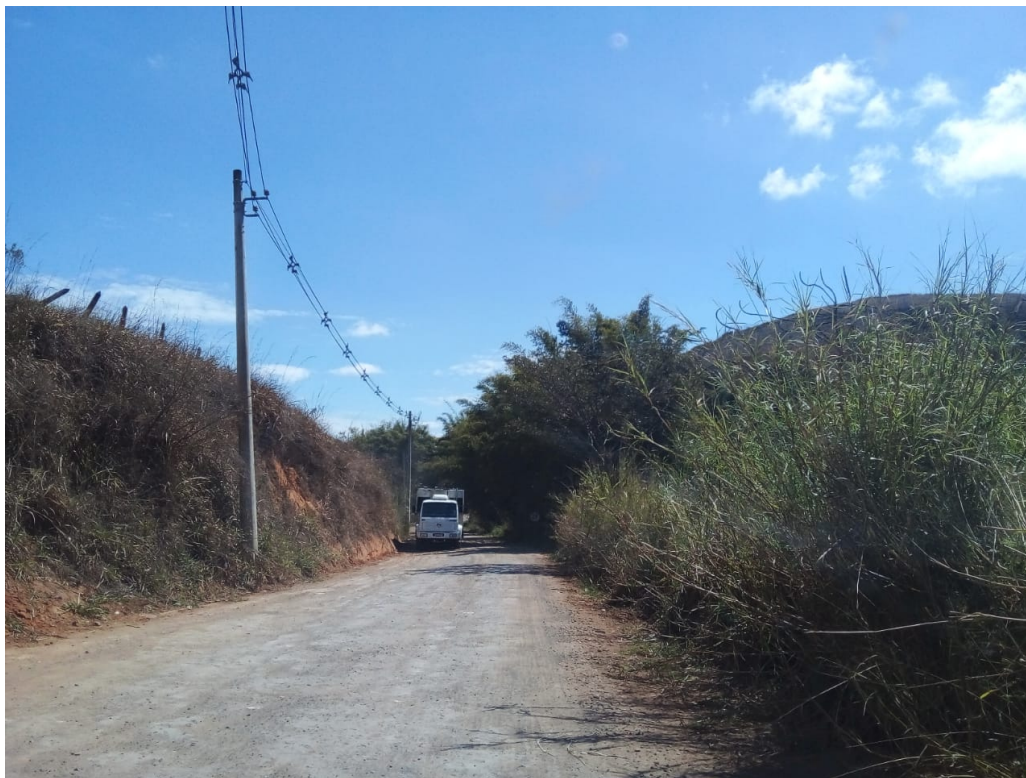
Figura 2: Estrada de acesso apresentando boas condições.
