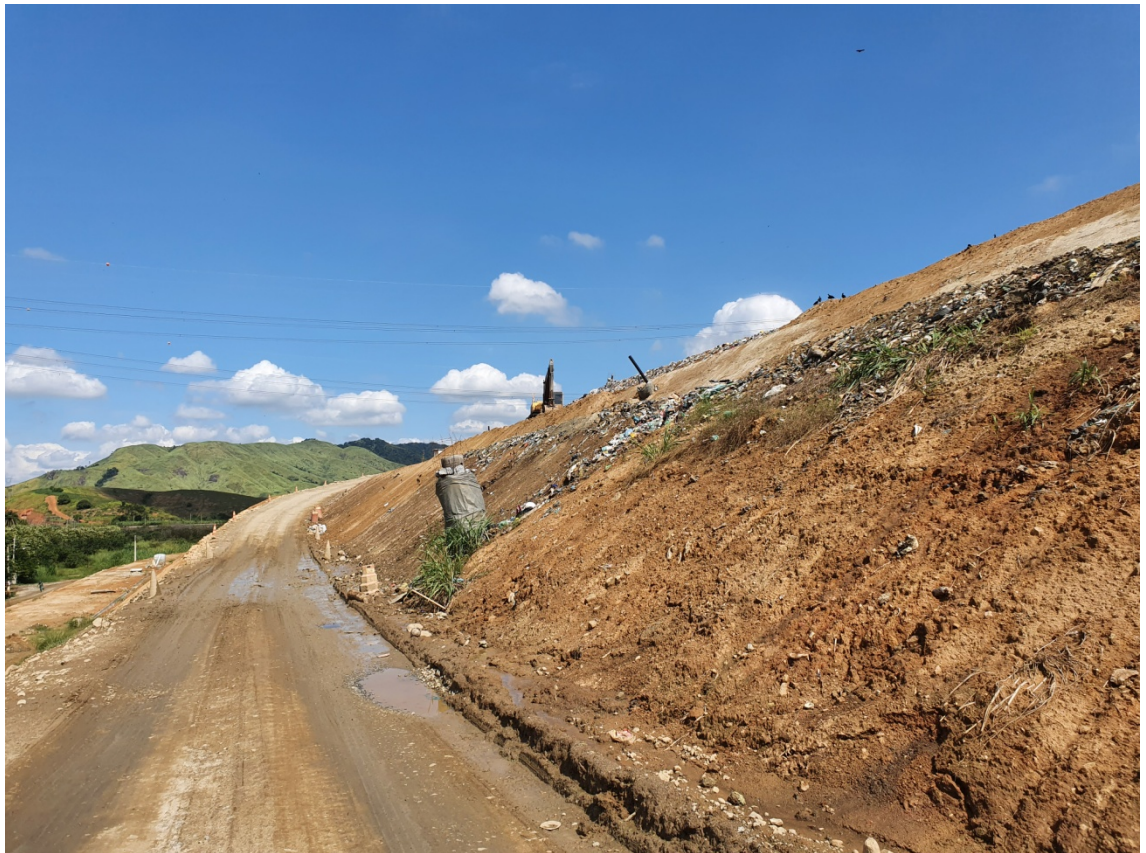
Figura 02: Vista da chegada da frente de trabalho.
