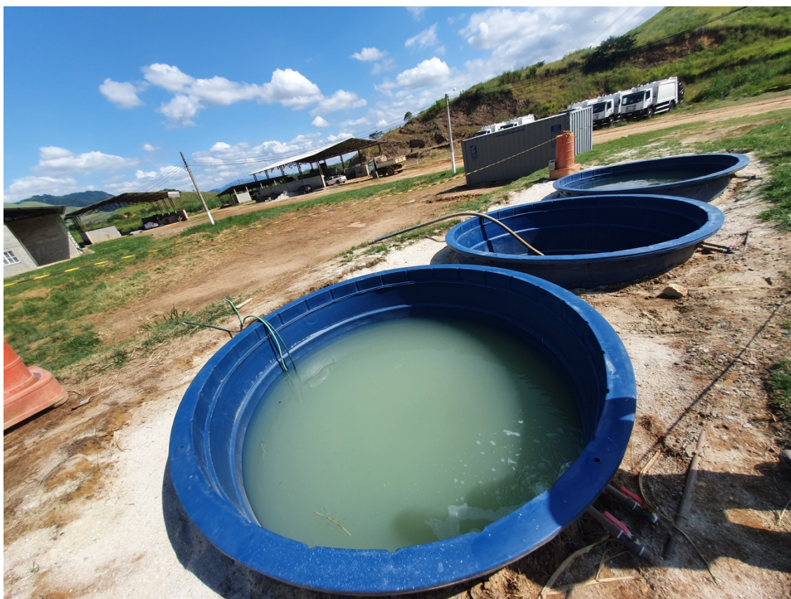
Figura 07: água de reuso proveniente do tratamento do chorume.
