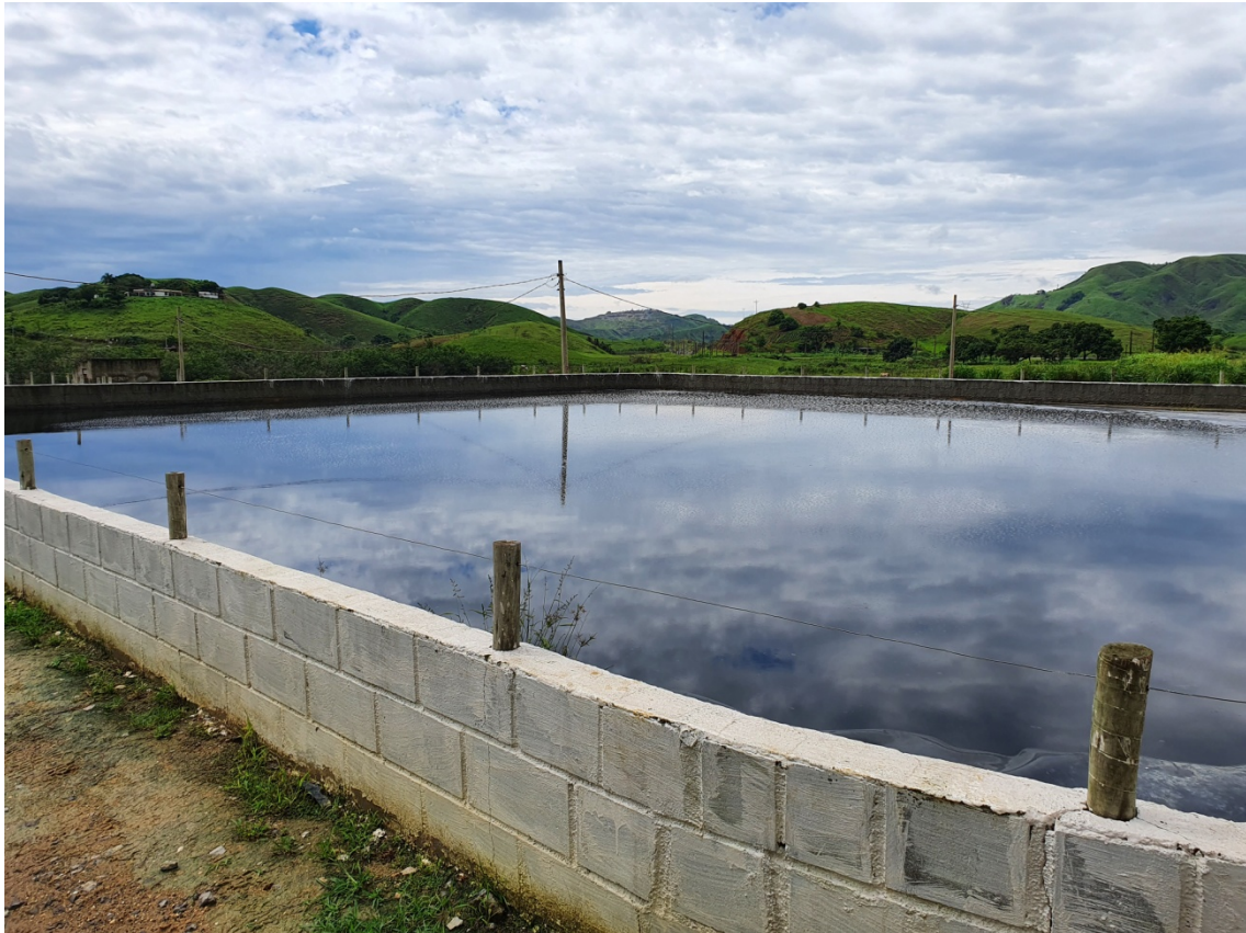
Figura 09: Lagoa de tratamento de chorume.
