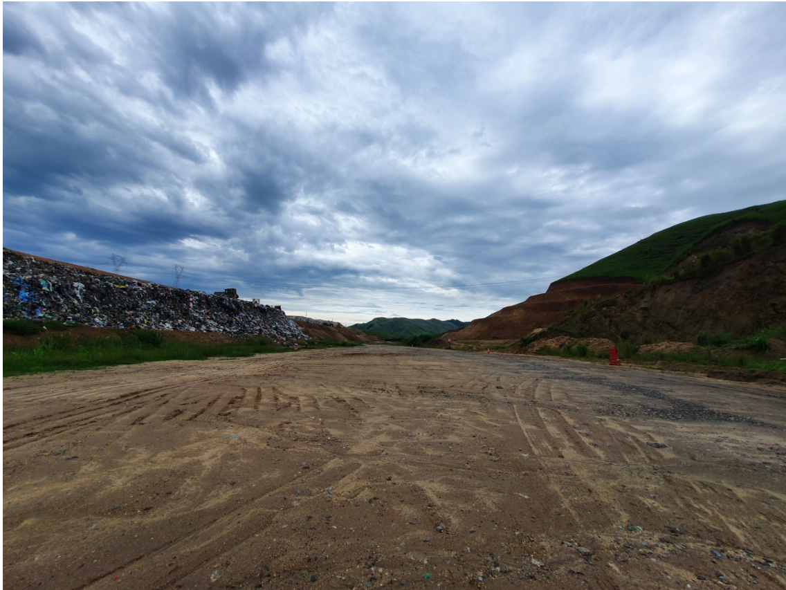
Figura 03: Vista da frente de trabalho .
