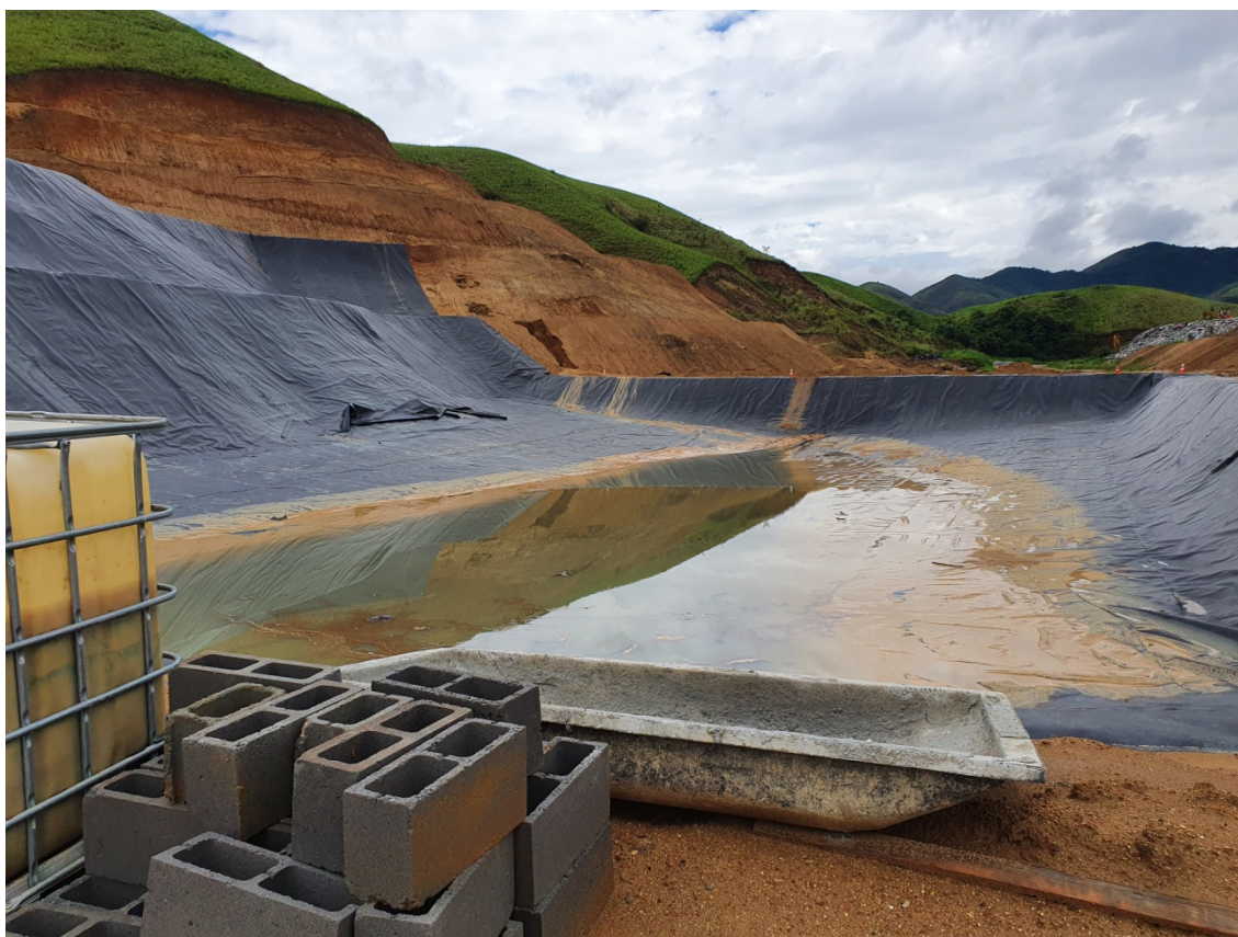
Figura 07: Nova área de trabalho sendo preparada.
