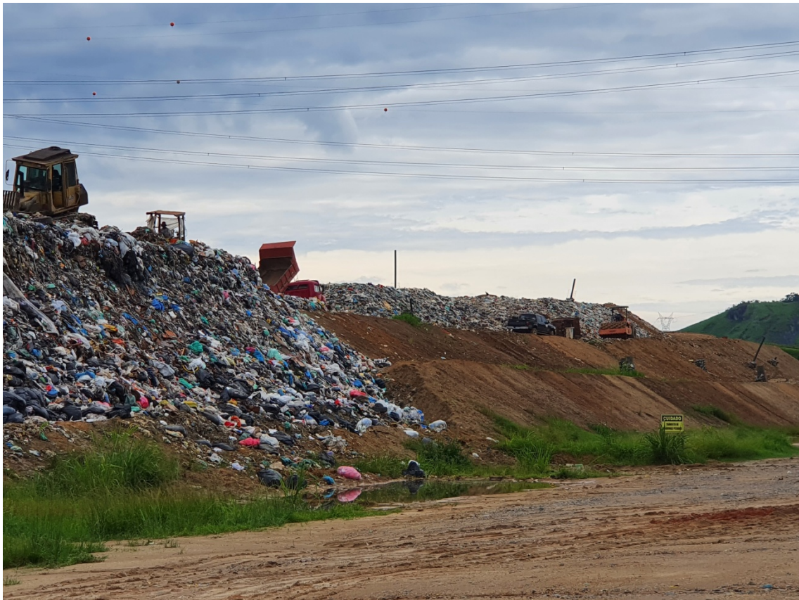
Figura 04: Vista da frente de trabalho .
