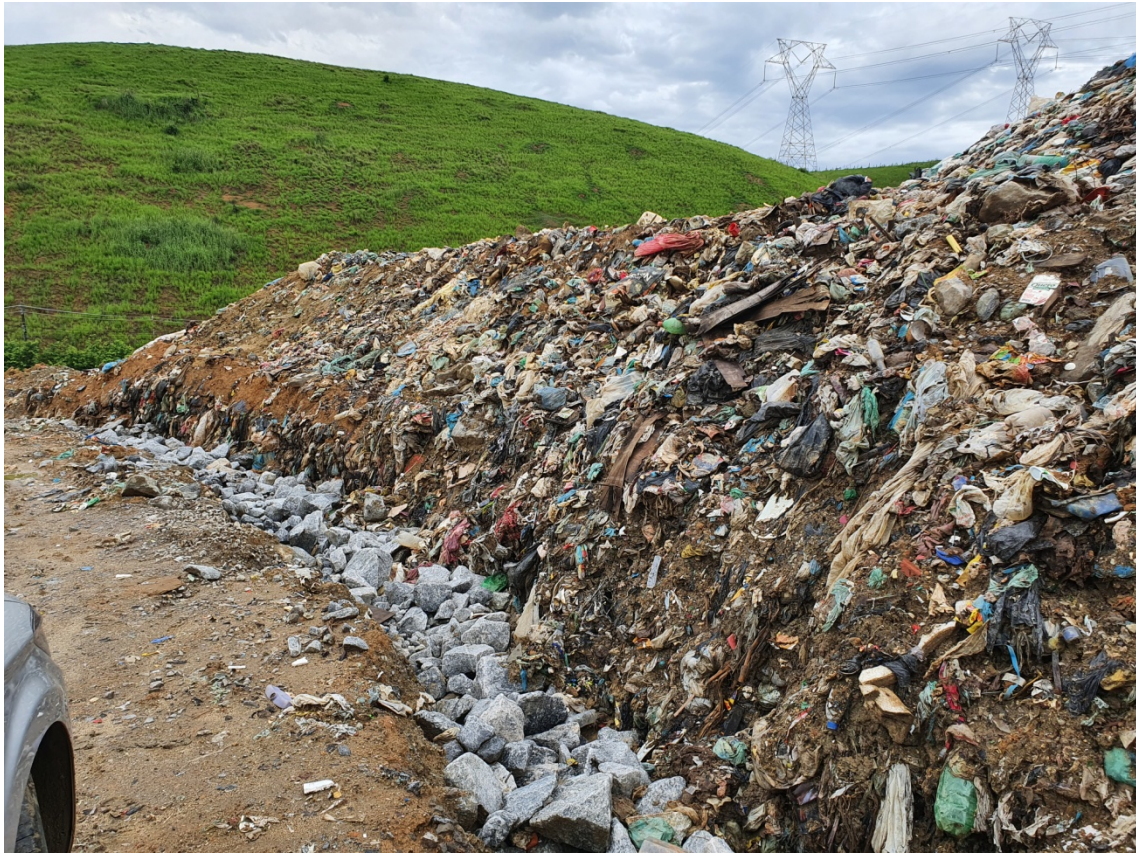
Figura 06: Vista de um talude sem cobertura vegetal e descobrimento do resíduo.
