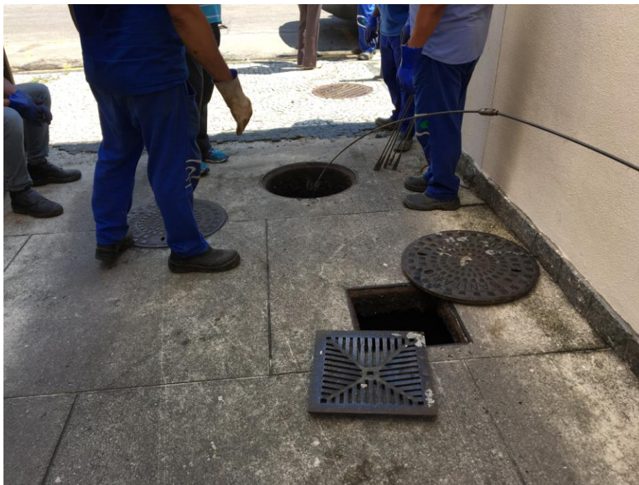
DESENTUPIMENTO DA CAIXA DE PASSAGEM/INSPEÇÃO DE ESGOTO
