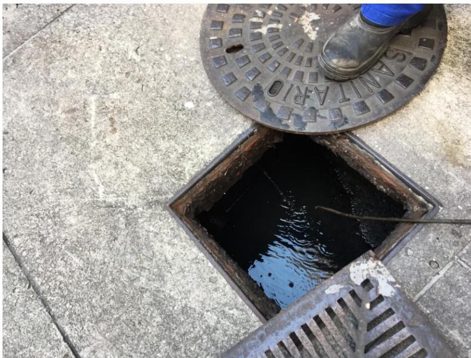
CAIXA DE PASSAGEM/INSPEÇÃO DE ÁGUAS PLUVIAIS - CONTRIBUINTE AO SISTEMA DE ESGOTO
