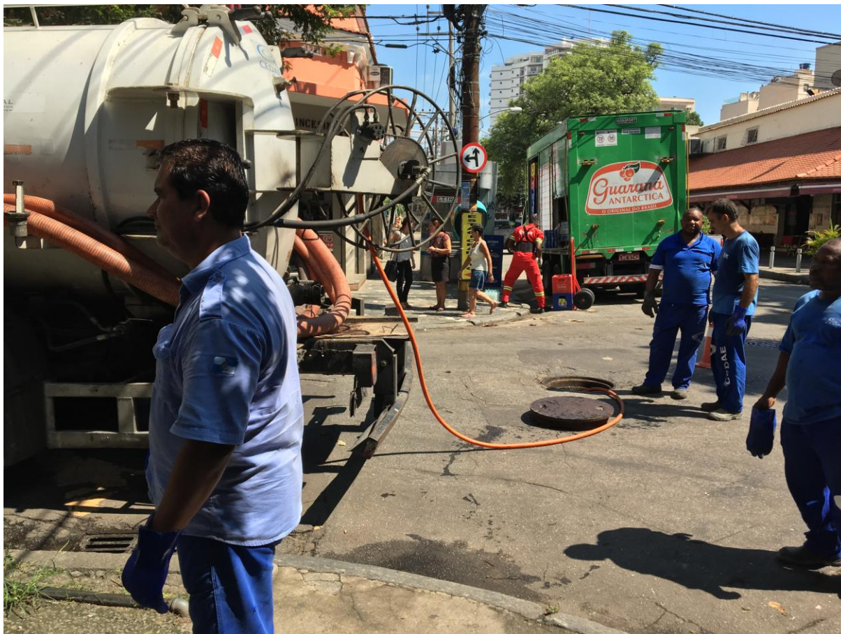
ESQUINA DA RUA DONA MARIA COM ALMIRANTE JOÃO CÂNDIDO BRASIL - EQUIPE DA CEDAE DESOBSTRUINDO A REDE COLETORA DE ESGOTO SANITÁRIO
