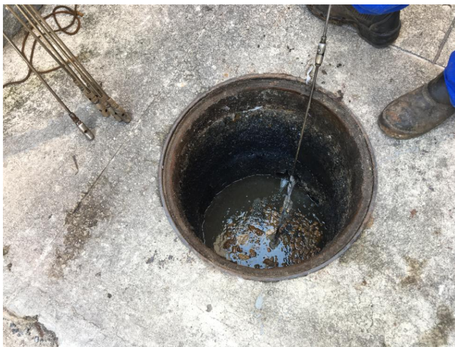
CAIXA DE PASSAGEM/INSPEÇÃO DE ESGOTO NO EDIFÍCIO (DESENTUPIDA)
