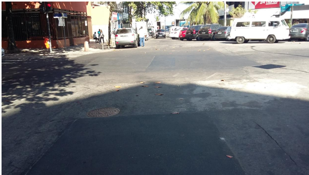
LOCAL DO ROMPIMENTO DA TUBULAÇÃO - SERVIÇOS DE REPARO CONCLUÍDOS
