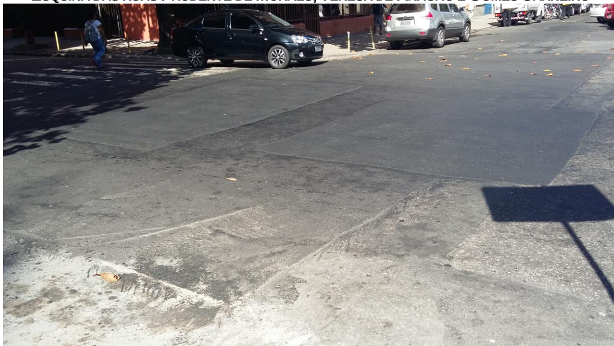
LOCAL DO ROMPIMENTO DA TUBULAÇÃO DE CONCRETO E DIÂMETRO DE 1.500 MM ESQUINA DAS RUAS PRUDENTE DE MORAES, TERESA DE ARAGÃO E GOMES CARNEIRO
