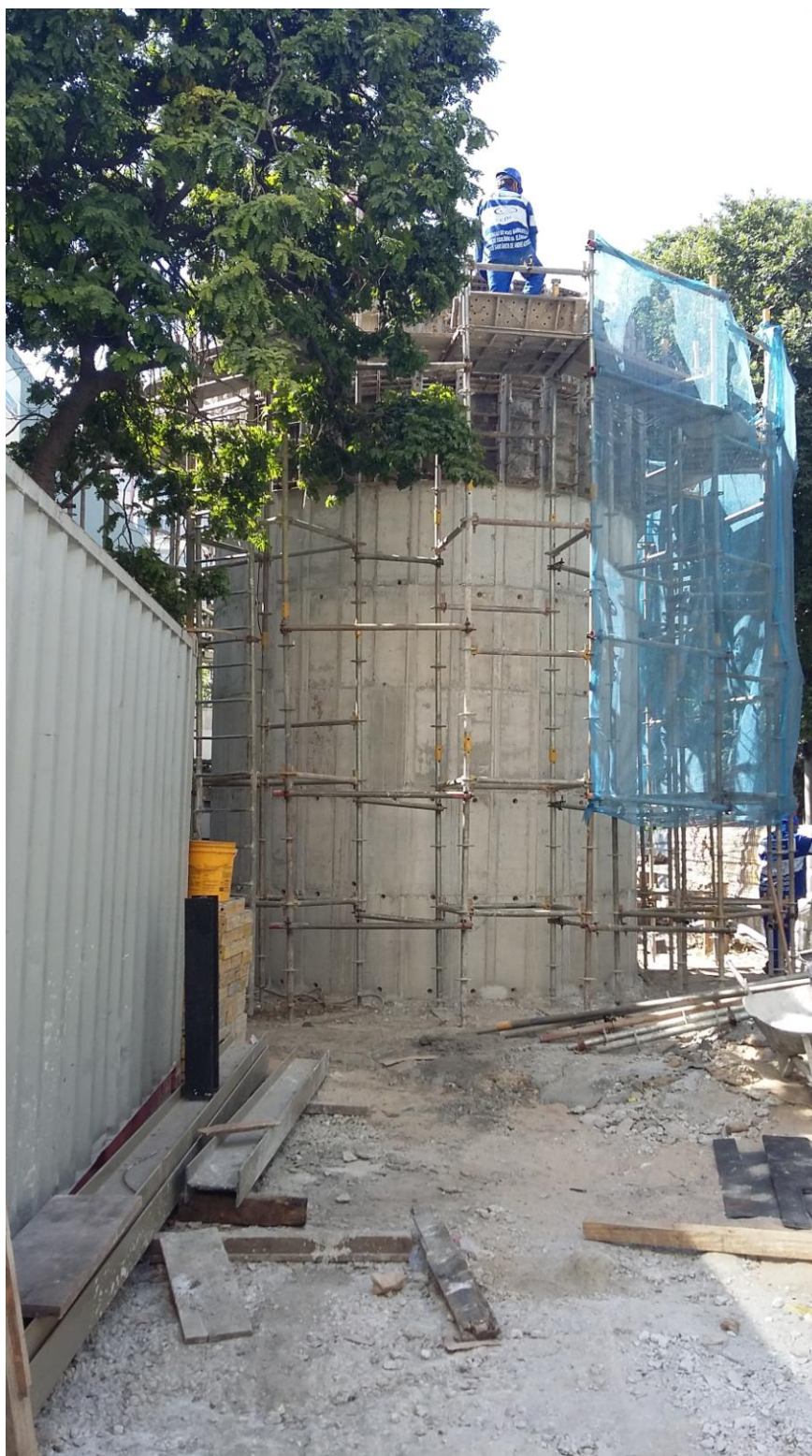
CHAMINÉ DE EQUILÍBRIO - EM EXECUÇÃO
