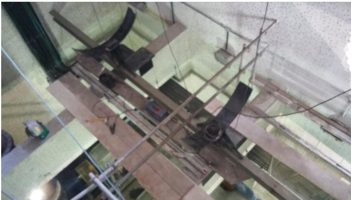
OBRAS NO INTERIOR DA ESTAÇÃO ELEVATÓRIA MONTAGEM PARA O RECEBIMENTO DO NOVO BARRILETE DE INTERLIGAÇÃO
