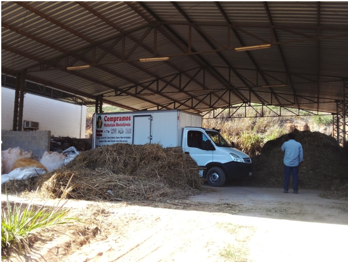
Figura 15: Unidade de triagem e leira de compostagem
