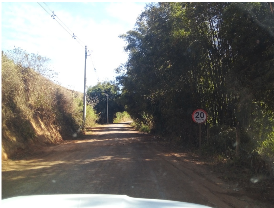
Figura 2: Estrada de acesso apresentando boas condições.
