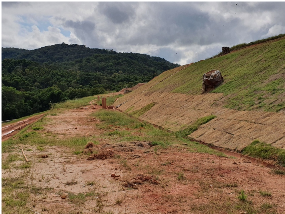
Figura 11: Vista parcial de camada com cobertura vegetal.
