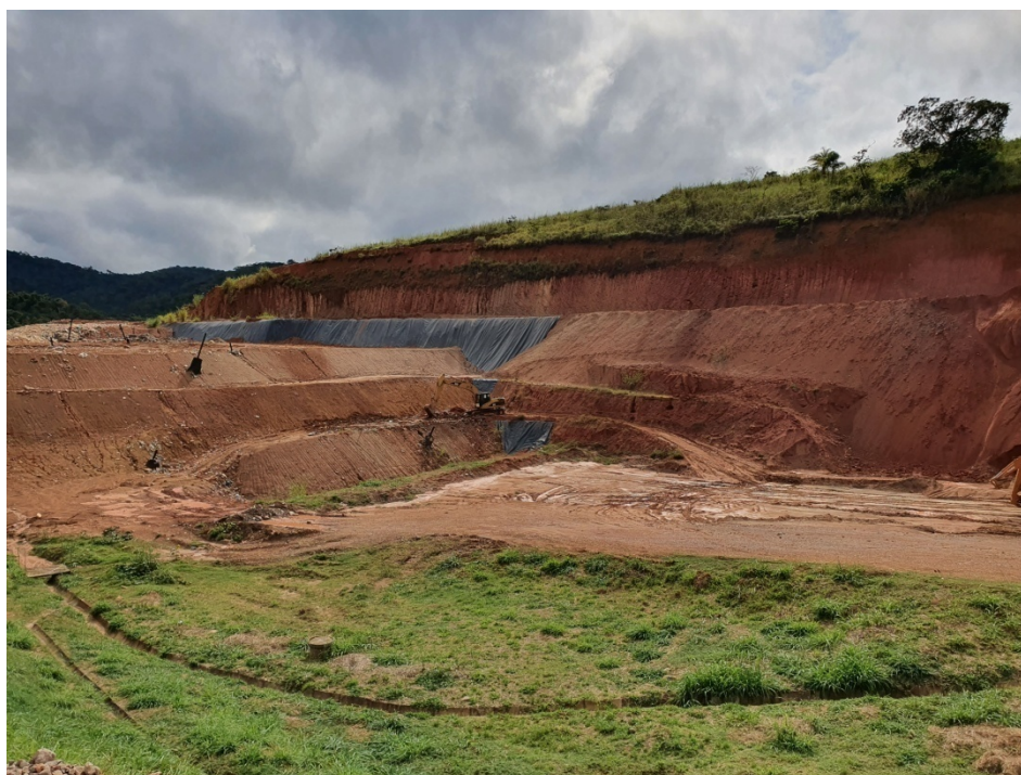
Figura 9: Camadas da célula b, etapa 2, com cobertura.
