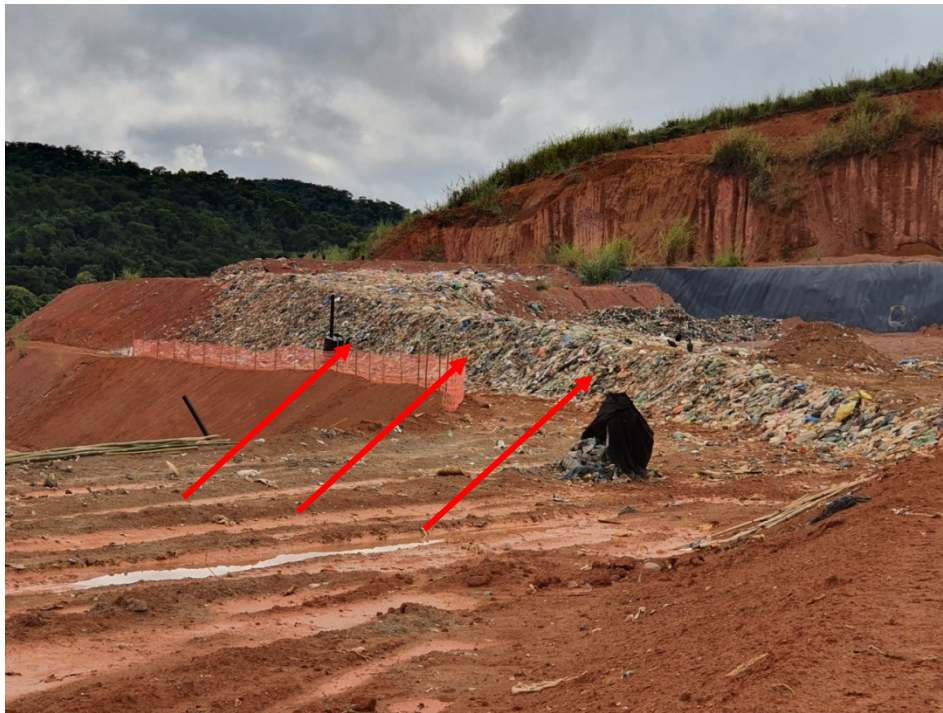
Figura 6: Construção de rampa de acesso, conforme indicada pelas setas.
