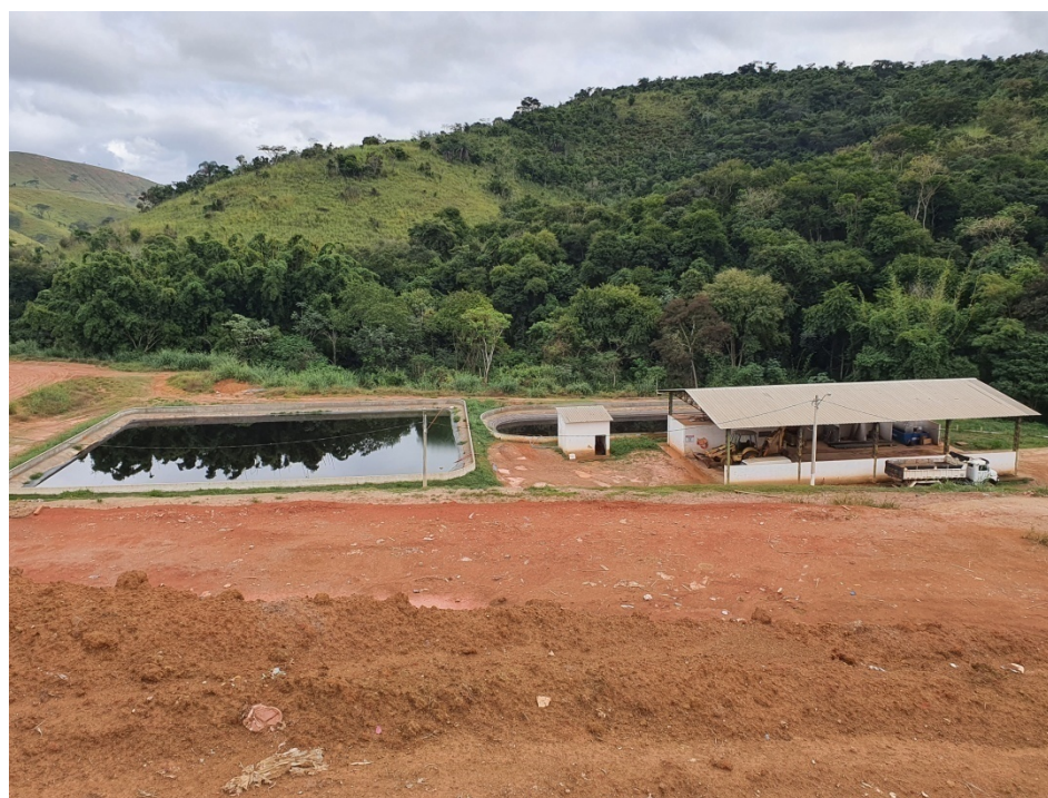
Figura 12: Vista das lagoas de armazenamento de chorume.
