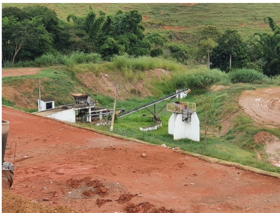
Figura 13: Britador de resíduos da construção civil.
