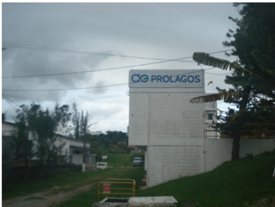
Foto 03 – Prédio do Centro de Comando da ETA
