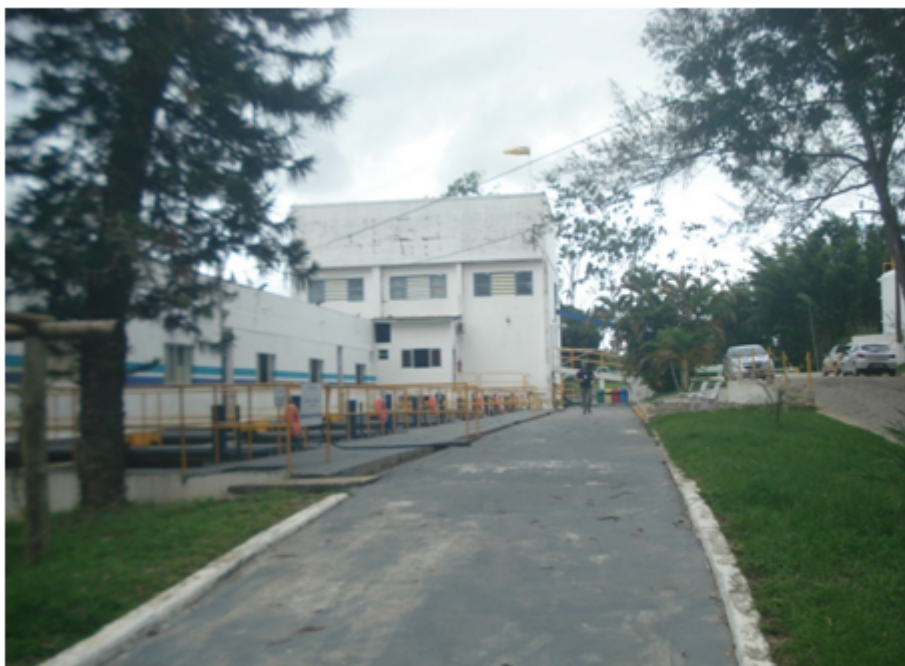
Foto 02 – Alameda Principal da ETA
