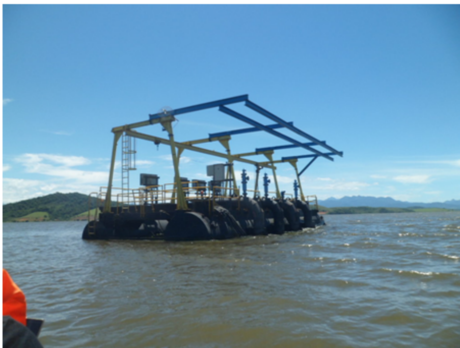
Foto 07 – Balsa de Captação da Água a 100m da ETA
