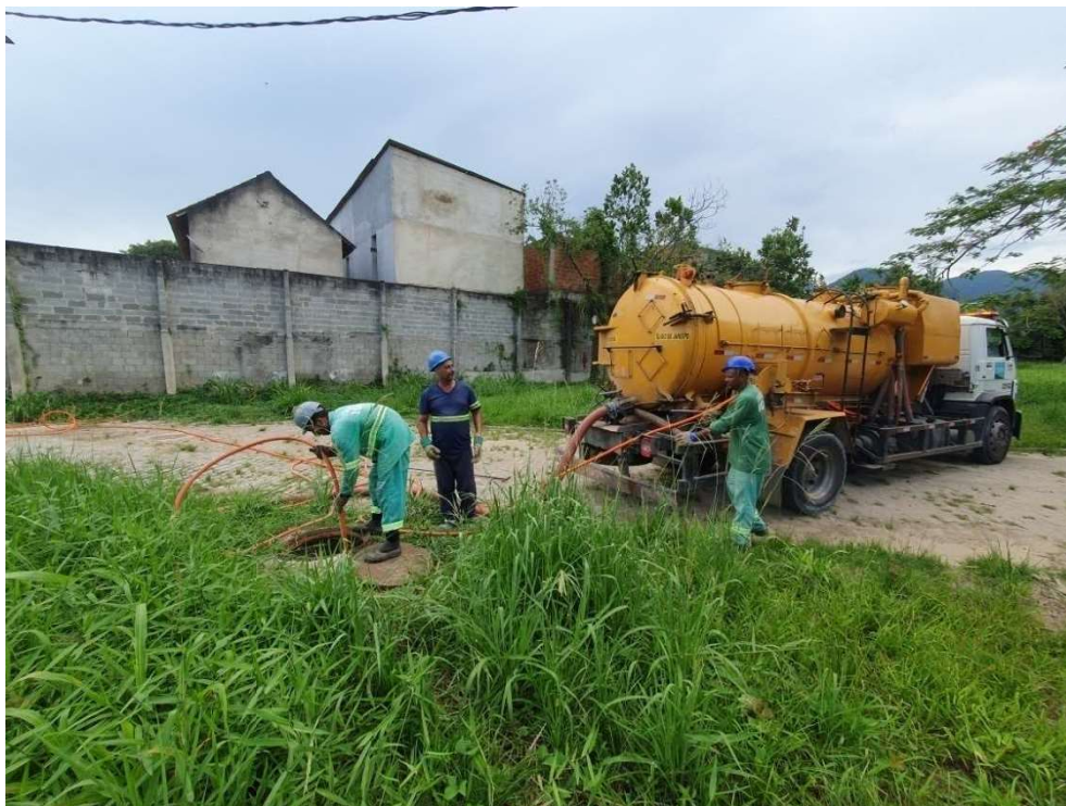
Equipe da Igua realizando a desobstrução da tubulação alta
