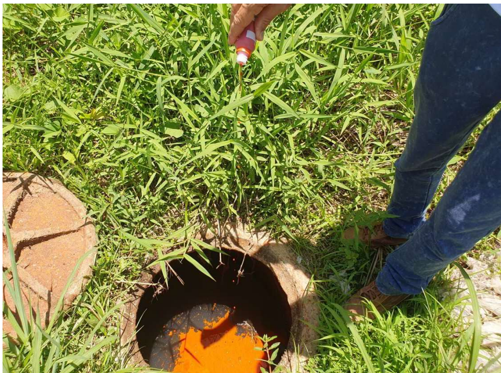
Teste com corante para verificar encaminhamento da rede interna que estava afogada, parte do Condado de York
