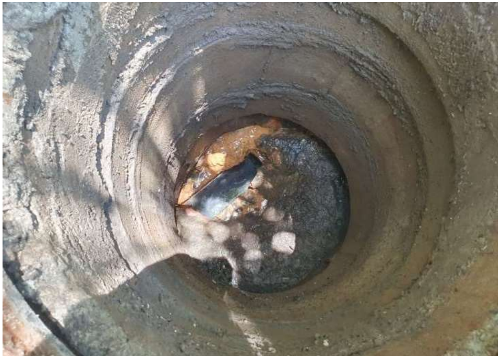
PV na calha, construído onde havia obstrução, parte alta do Condado de York
