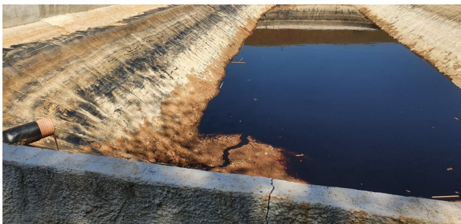
Figura 05: Lagoa de armazenamento de chorume, cujo efluente é recolhido por caminhões para posterior tratamento.
