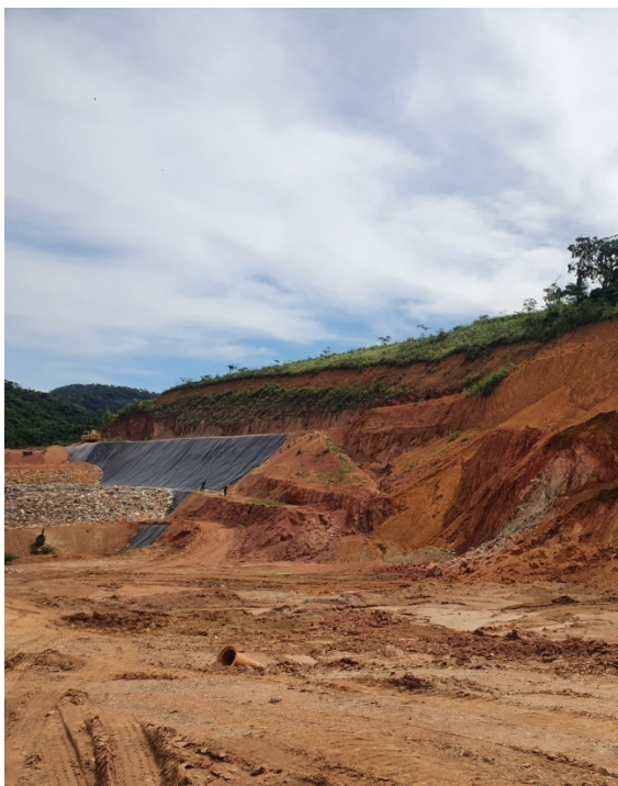
Figura 4: Jazida utilizada para recobrimento de resíduos e pavimentação das vias e, ao fundo, frente de trabalho.
