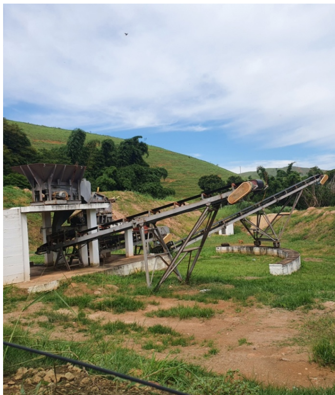
Figura 7: Britador de resíduos da construção civil inoperante.
