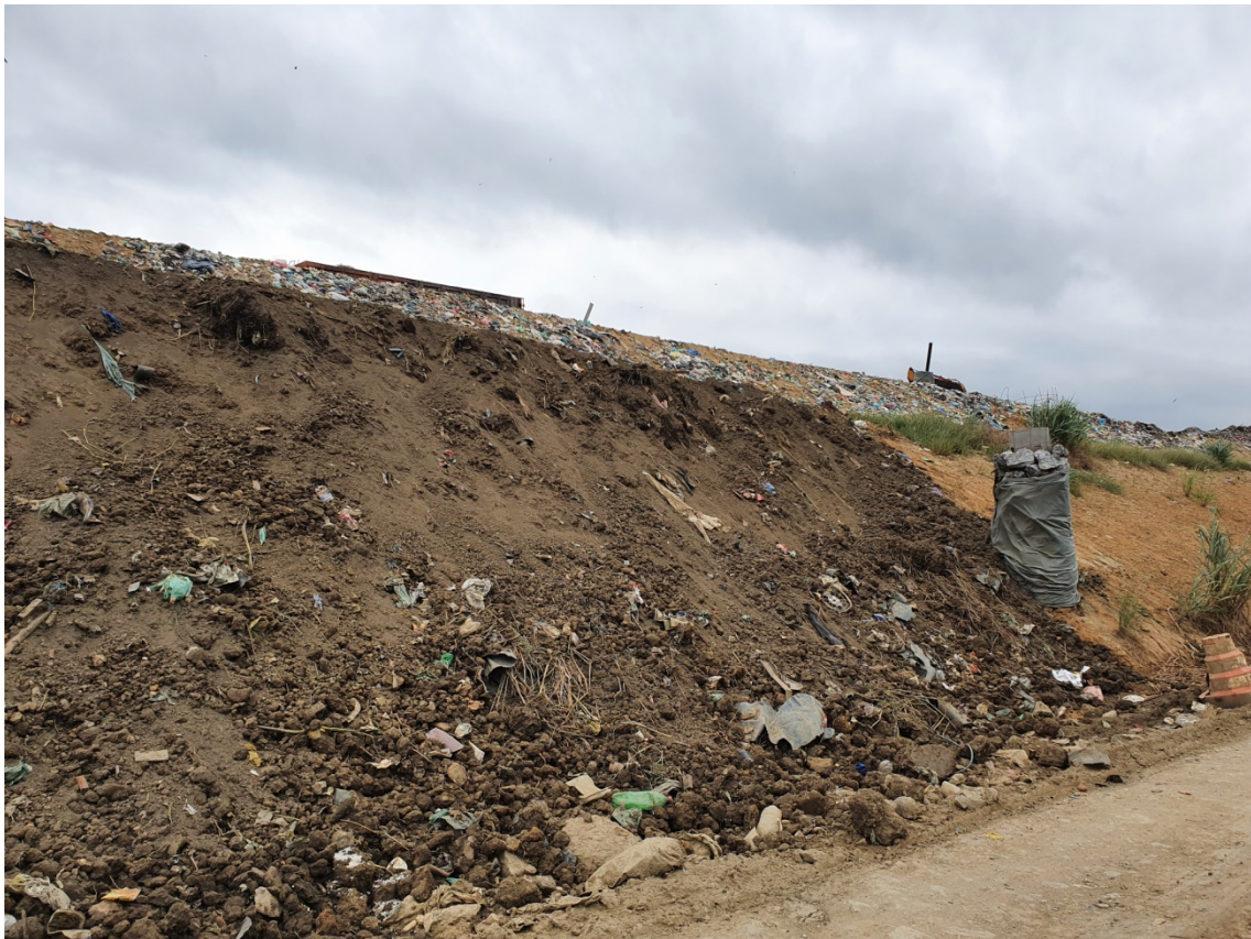
Figura 03: Vista do talude sem cobertura vegetal suscetível a erosão e vetores.
