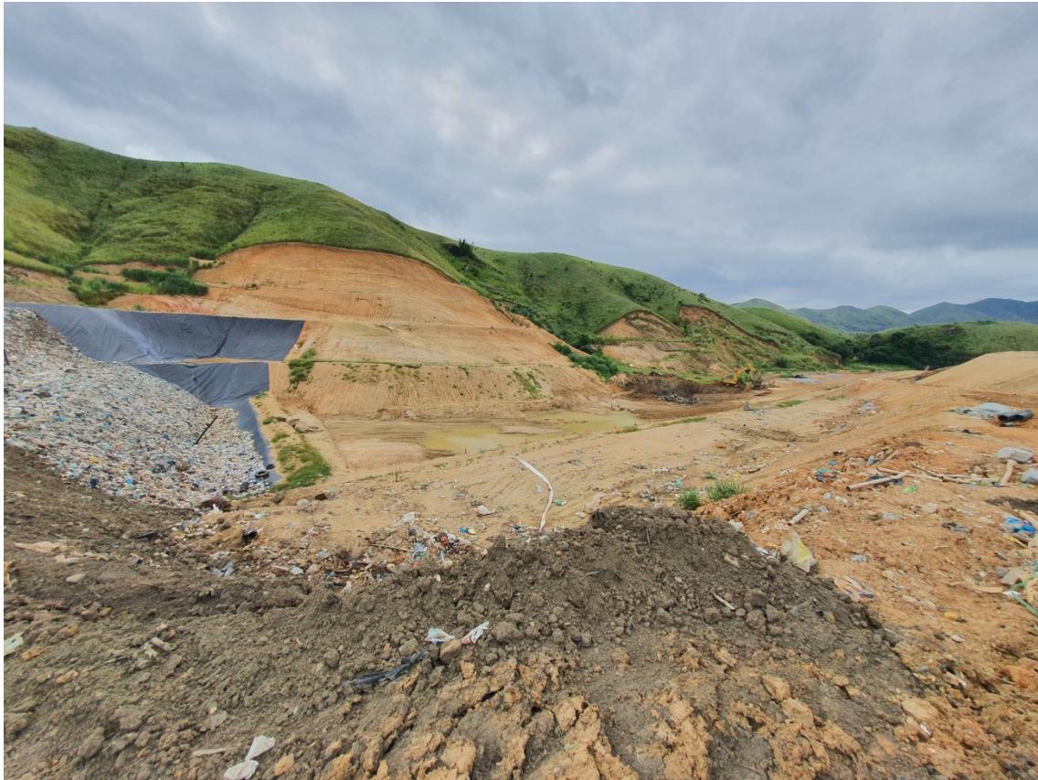
Figura 04: vista da frente de trabalho.
