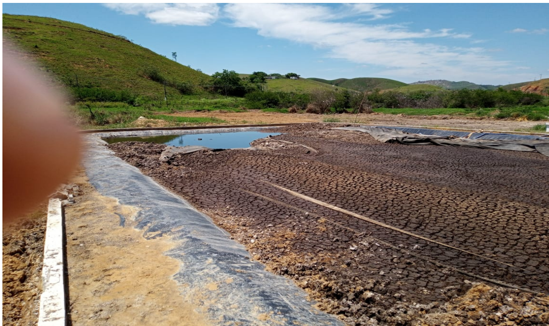
Figura 5: Lagoa de chorume em processo de limpeza.
