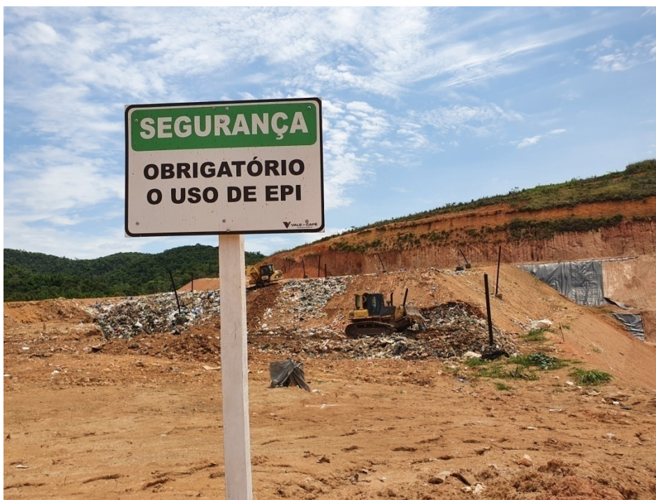
Figura 04: Vista frente de trabalho.
