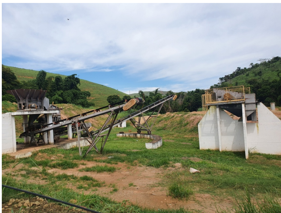
Figura 08: Britador de resíduos da construção civil inoperante.
