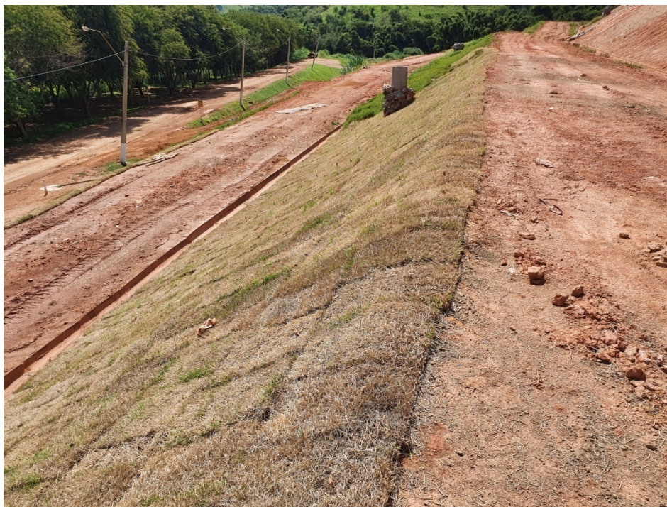
Figura 12: Vista de talude com gramíneas.
