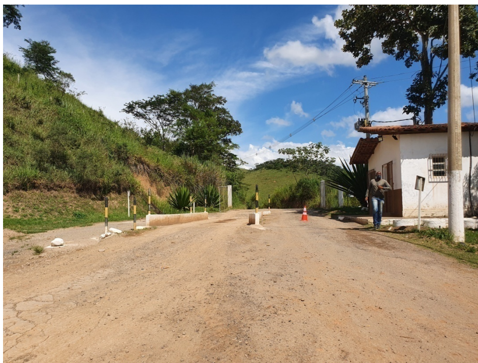
Figura 4: Vista da entrada do complexo e balança de pesagem.
