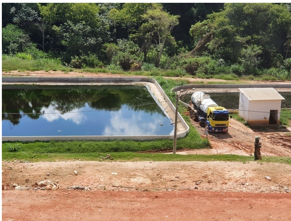
Figura 13: Lagoa de armazenamento de chorume.
