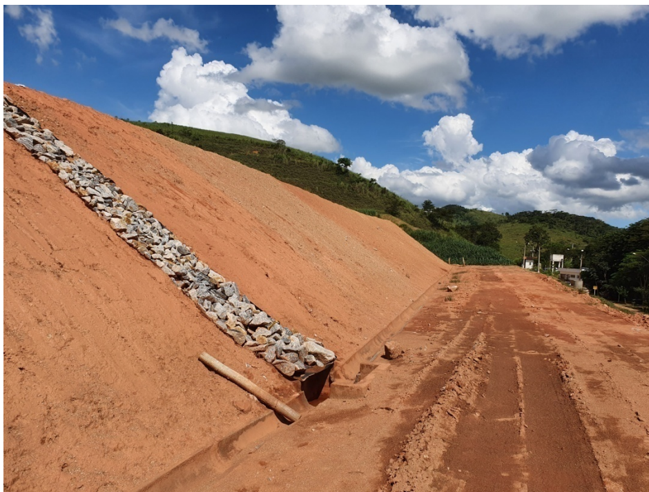
Figura 11: Vista de talude concluído, ainda com ausência de vegetação.
