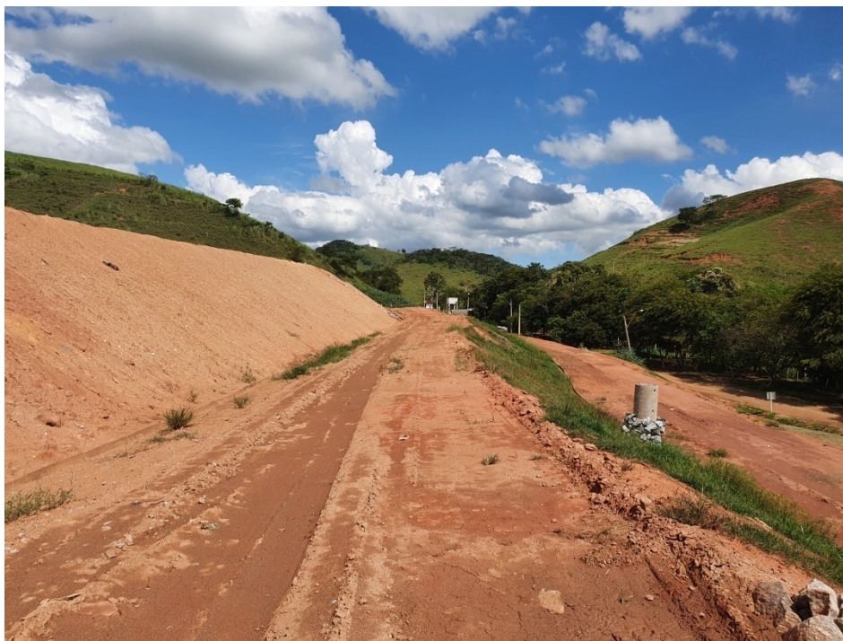
Figura 10: Foto tirada em cima de um talude com sua operação finalizada. À esquerda, vista de outro talude concluído.
