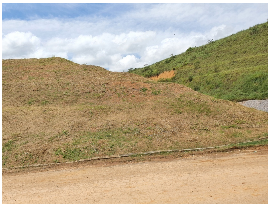
Figura 7: Vista da célula A a ser remediada.
