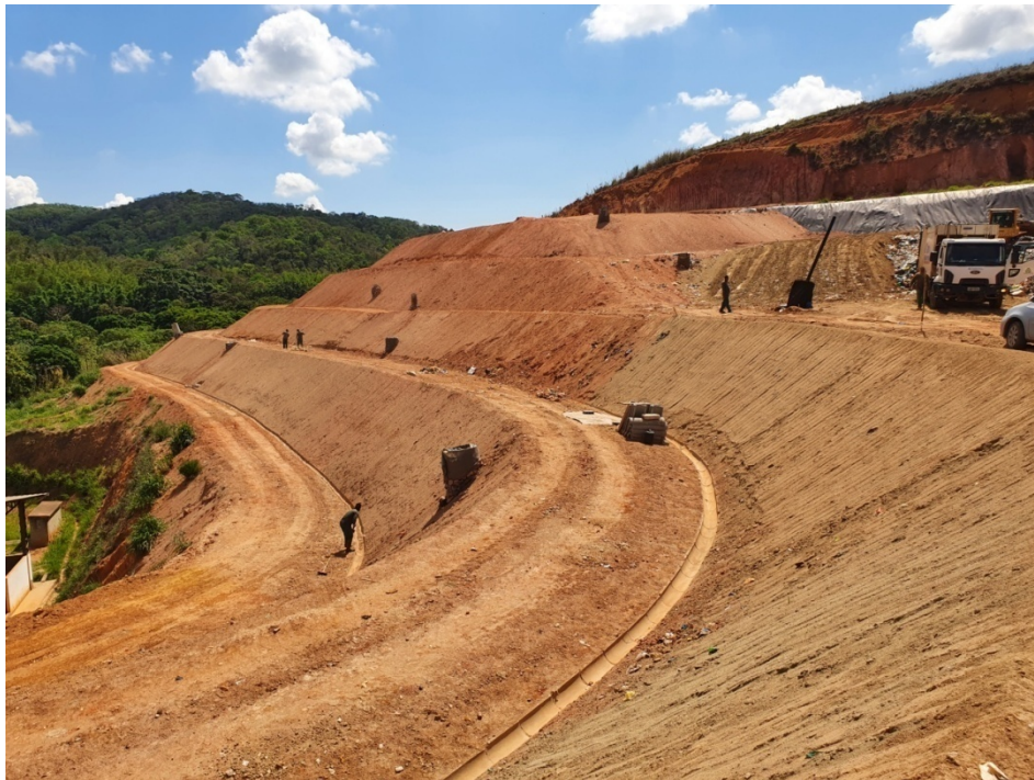
Figura 6: Vista dos taludes com a implementação das canaletas de drenagem, porém, ainda sem a cobertura vegetal.
