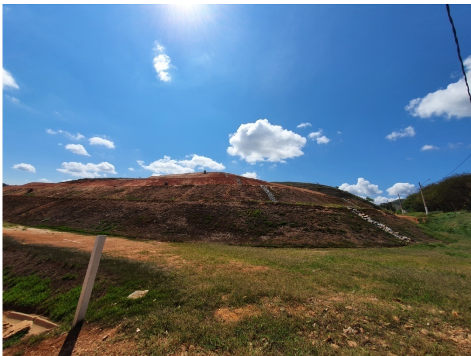
Figura 7: Vista dos taludes já operados. Célula b, etapa 2.
