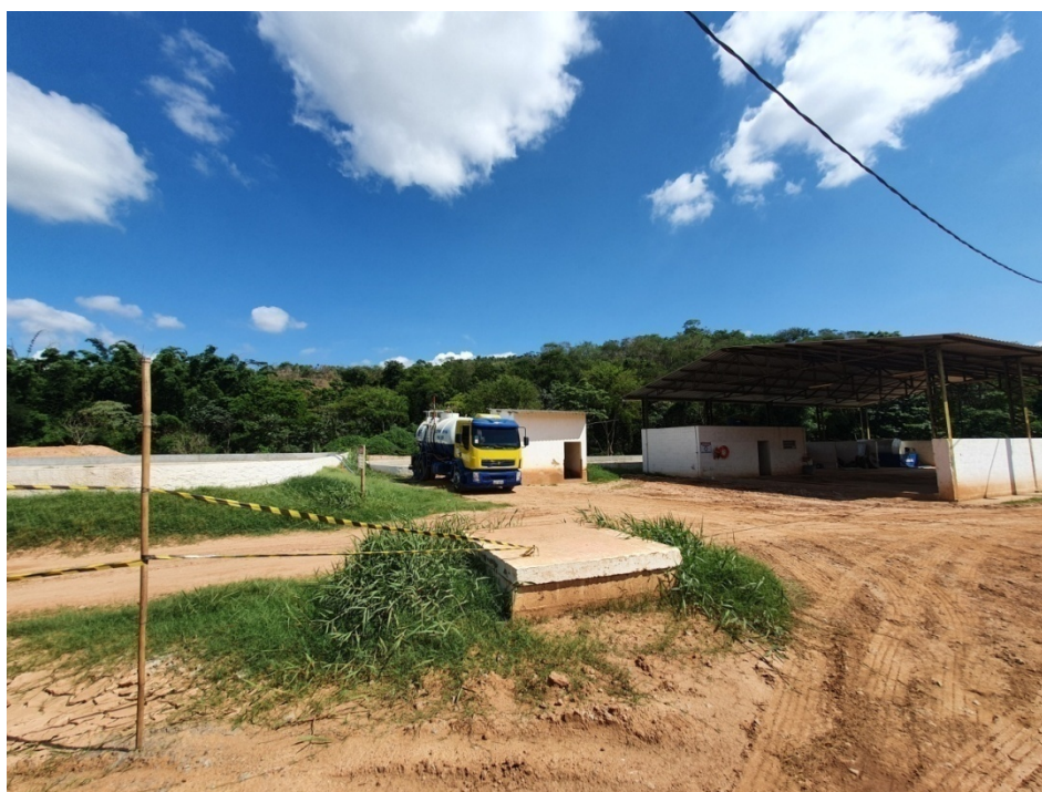
Figura 8: Vista da lagoa de armazenamento de chorume (à esquerda), caminhão usado para o recolhimento de chorume que será levado para estação de tratamento e galpão de triagem (à direita).
