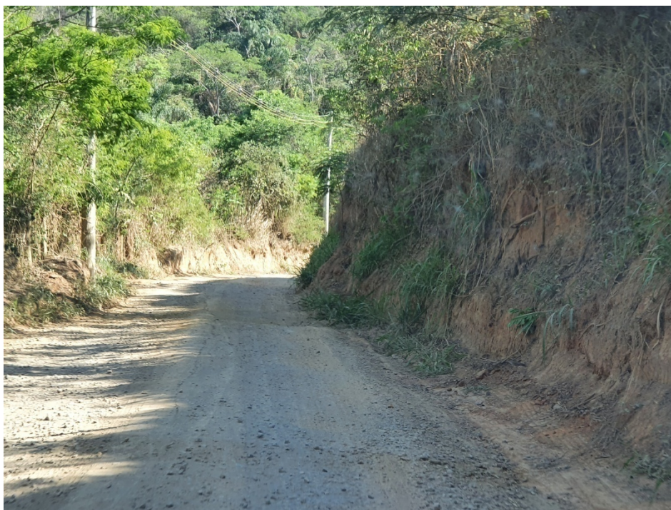
Figura 2: Estrada de acesso apresentando boas condições.
