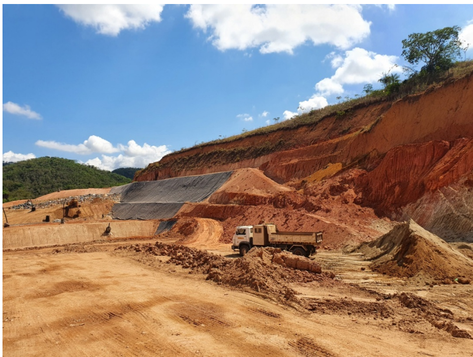
Figura 5: Vista da frente de trabalho, à esquerda, e da jazida utilizada para recobrimento dos resíduos à direita.
