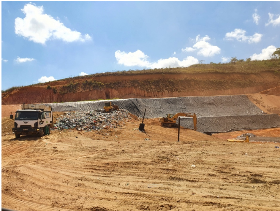
Figura 4: Vista da frente de trabalho
