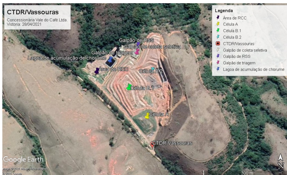
Figura 1: Vista aérea do CTDR/Vassouras. Fonte: Google Earth, 28/04/2021.
