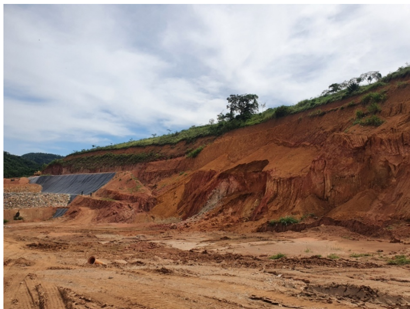
Figura 5: Jazida utilizada para recobrimento de resíduos e pavimentação das vias e, ao fundo, frente de trabalho.
