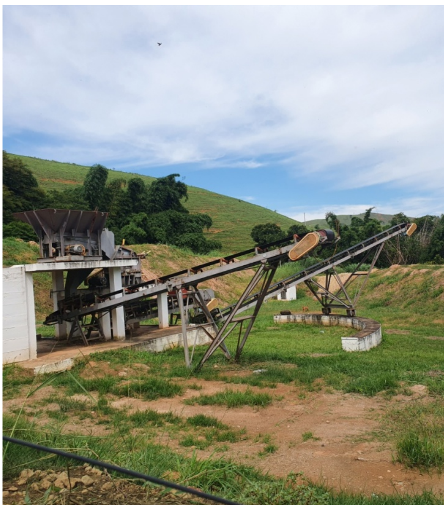
Figura 10: Britador de resíduos da construção civil inoperante.
