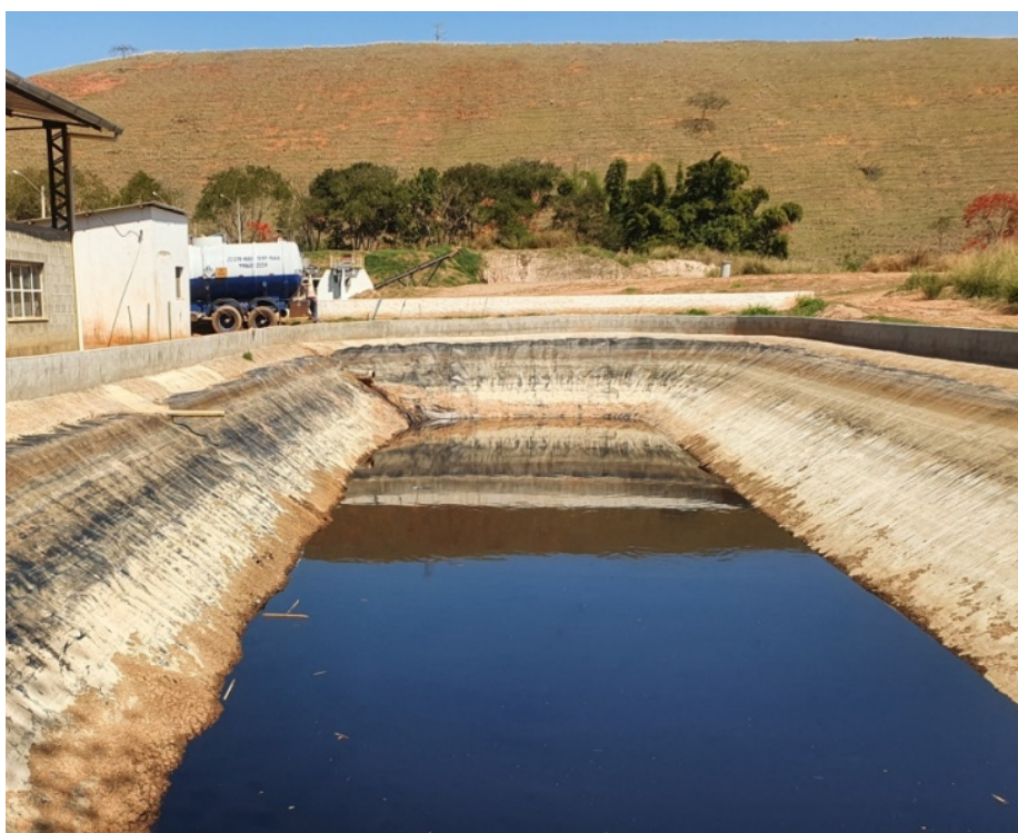
Figura 07: Lagoa de armazenamento de chorume, cujo efluente é recolhido por caminhões para posterior tratamento.
