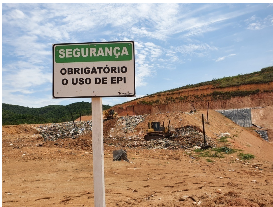
Figura 06: Vista frente de trabalho.
