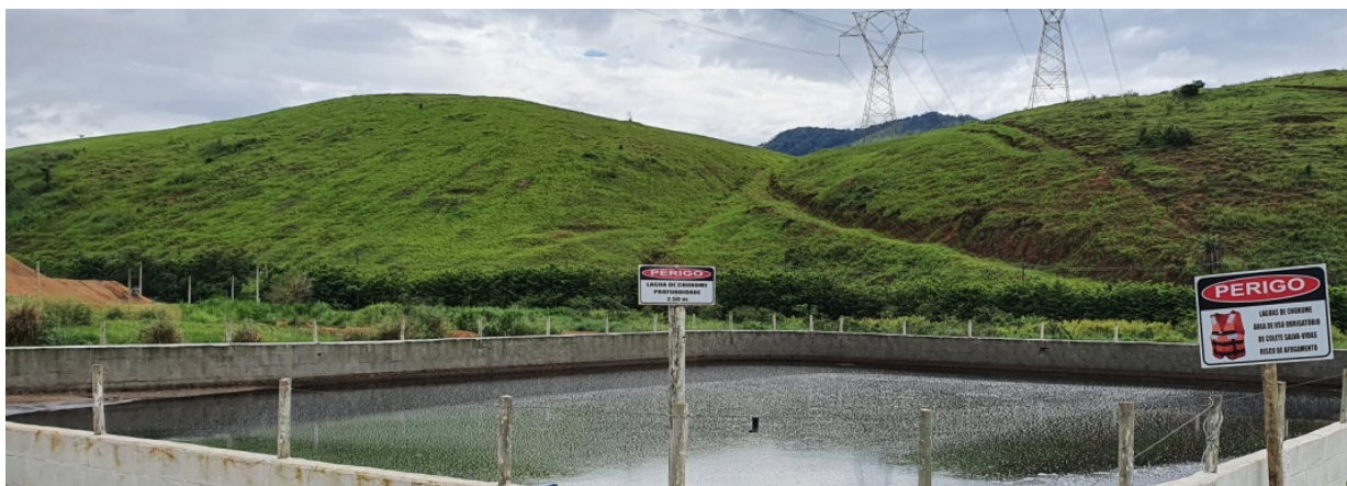
Figura 6: Lagoa de tratamento de chorume.
