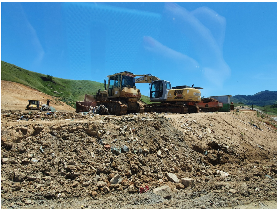
Figura 02: Vista da frente de trabalho.
