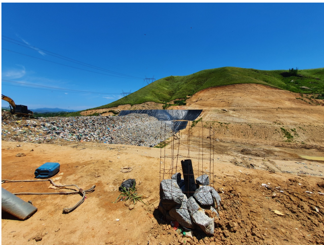
Figura 03: Vista da frente de trabalho.
