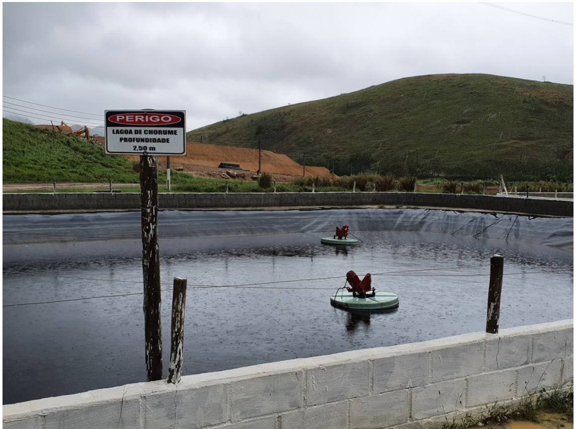
Figura 5: Lagoa de chorume com aerador.
