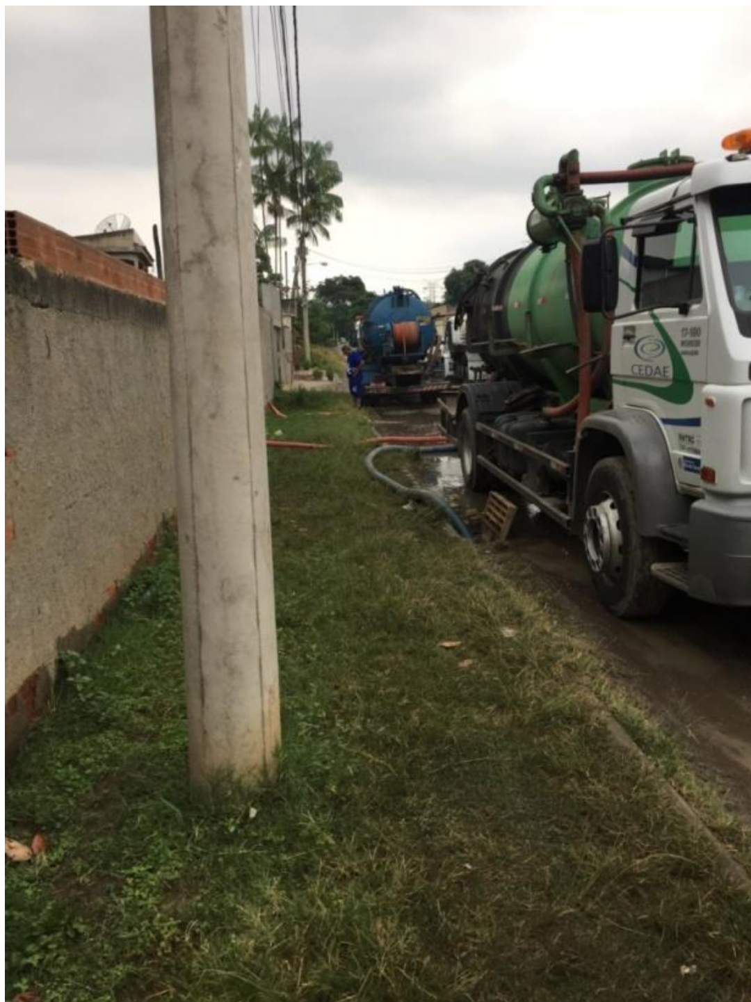
EQUIPE DA CEADÉ REALIZANDO LIMPEZA
