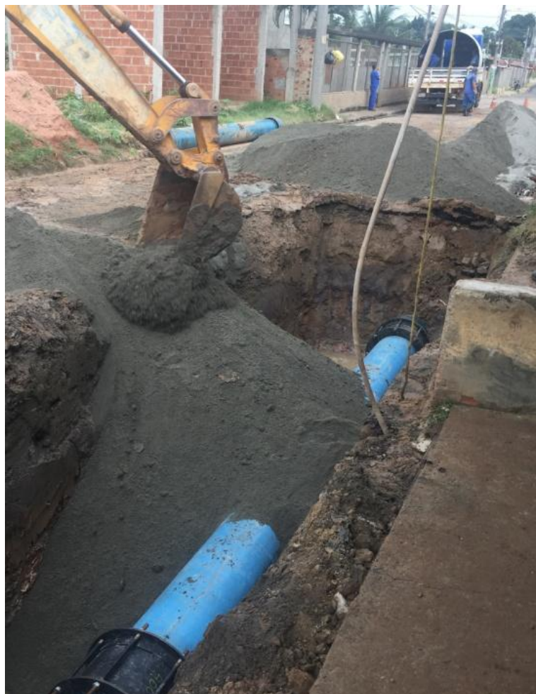
TUBULAÇÃO SUBSTITUÍDA E EM CARGA
