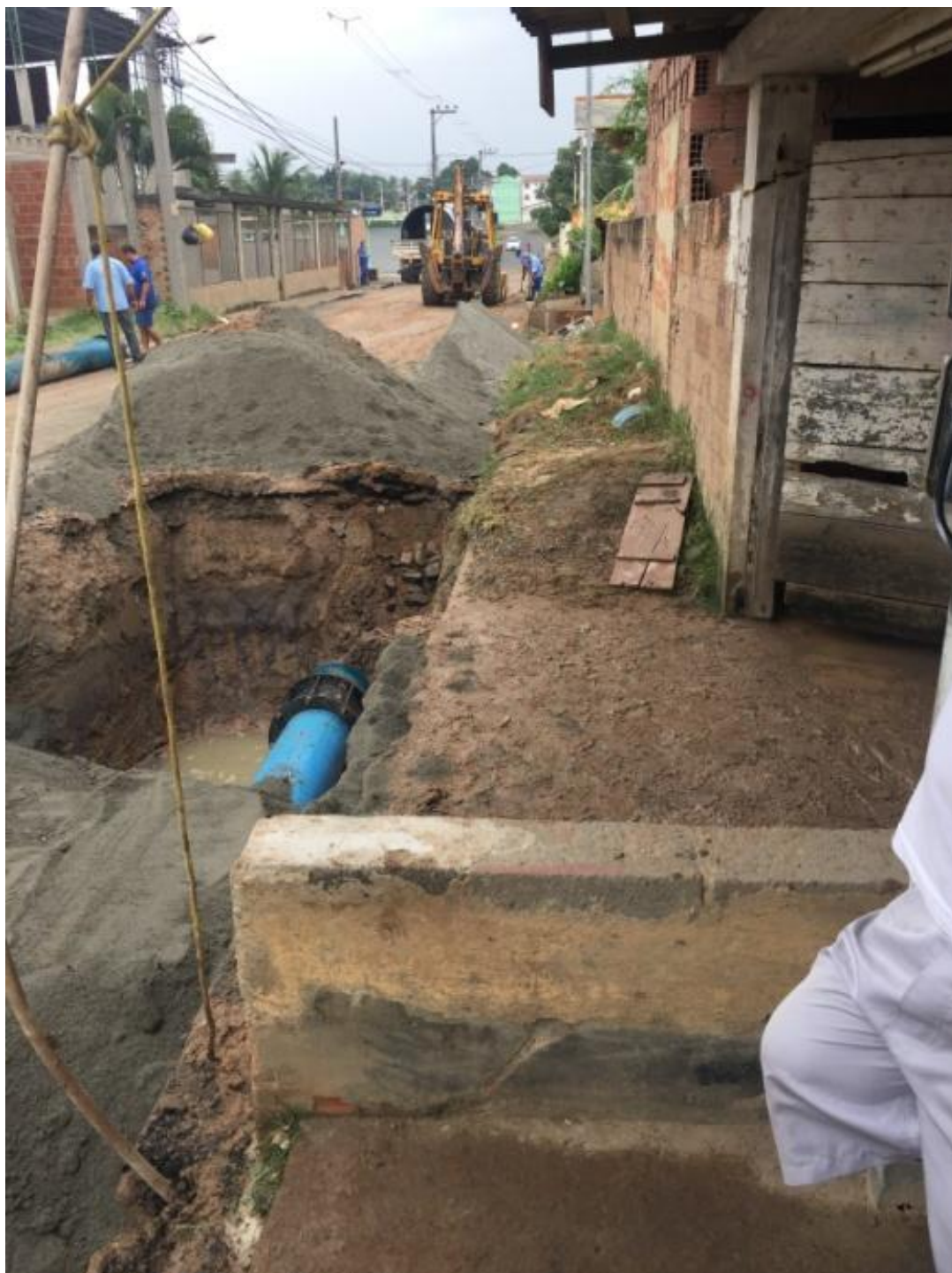
TUBULAÇÃO SUBSTITUÍDA E EM CARGA
