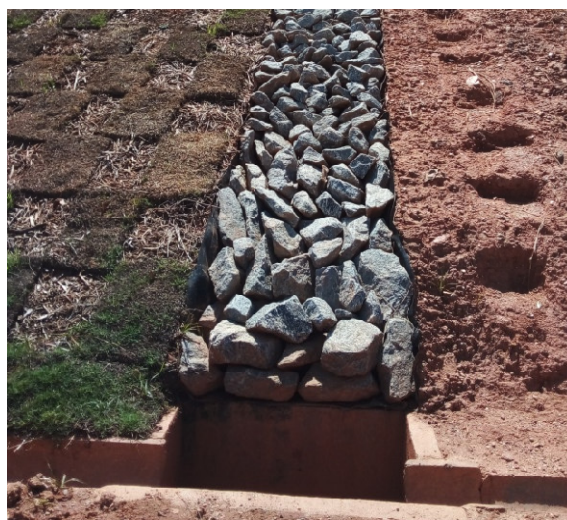
Figura 10: Drenagem do talude
