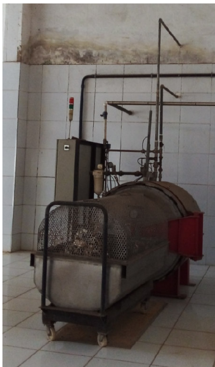
Figura 24: Autoclave disponibilizada para realizar o tratamento de RSS. Inoperante
