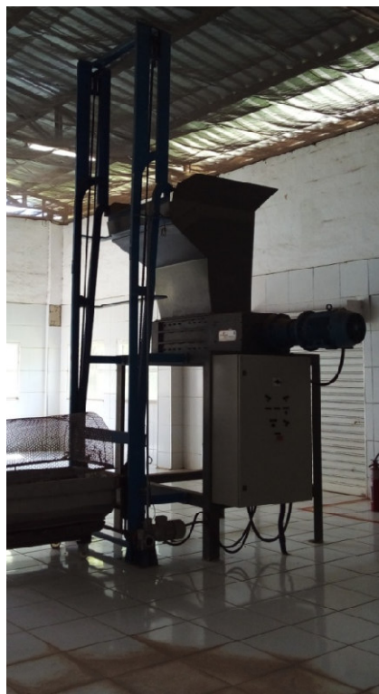
Figura 23: Autoclave disponibilizada para realizar o tratamento de RSS. Inoperante.
