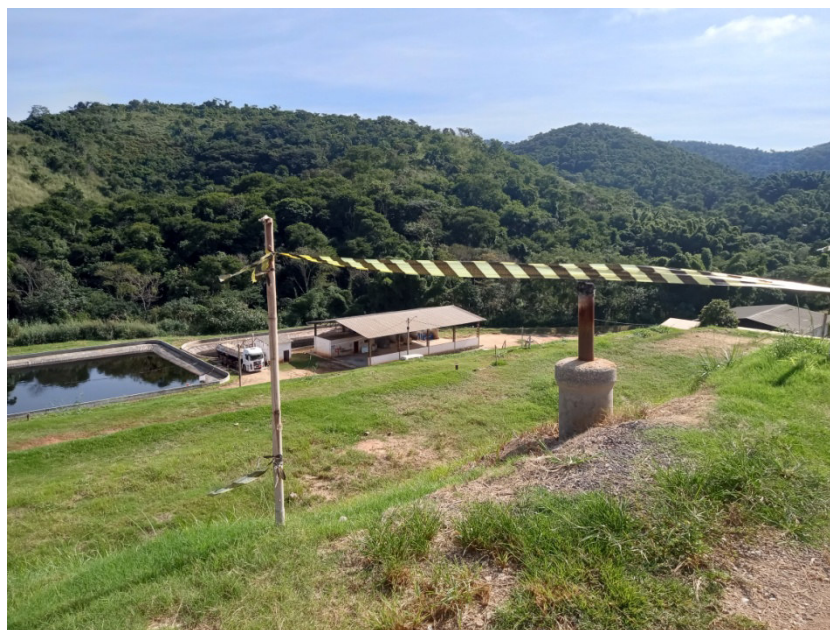
Figura 18: Vista aérea lagoa de chorume e no detalhe, o queimador.
