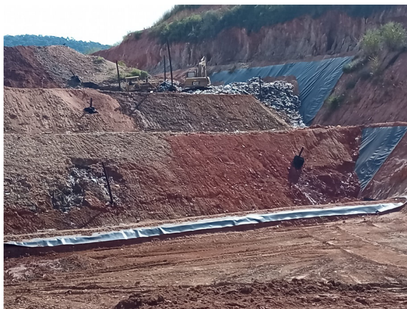
Figura 7: Frente de trabalho. Equipamento compactando resíduos
