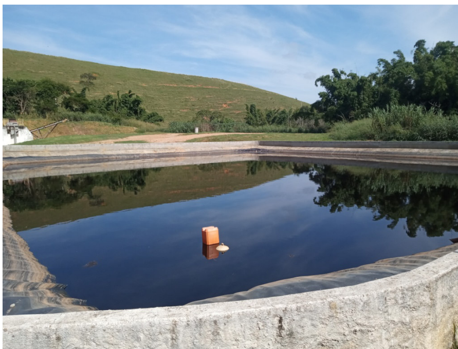
Figura 13: Lagoa de recebimento e armazenagem de chorume.
