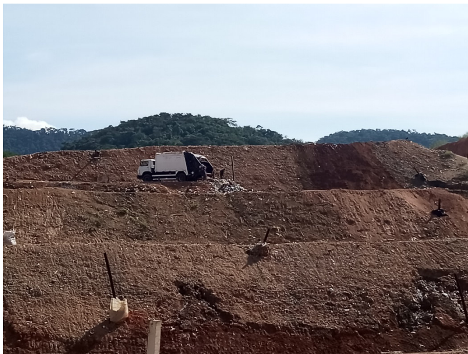
Figura 6: Frente de trabalho. Caminhão descarregando.
