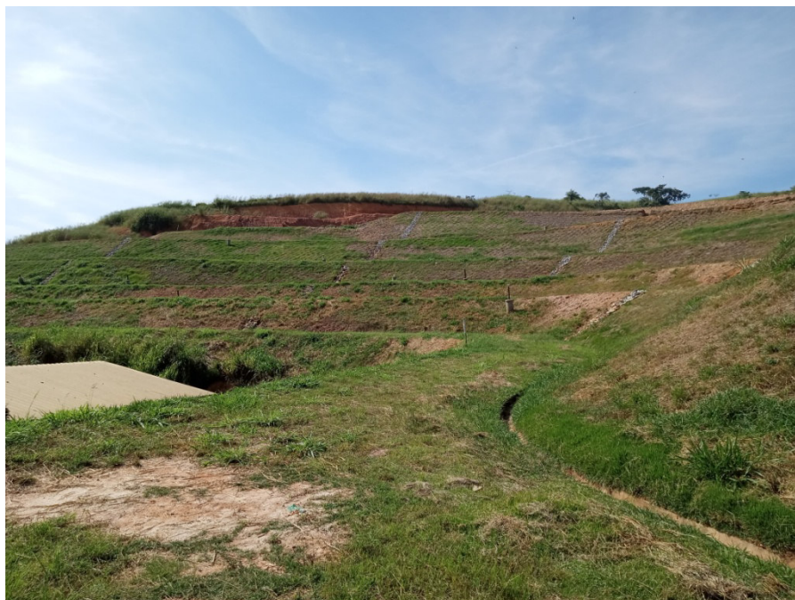
Figura 11: Recomposição vegetal do talude
