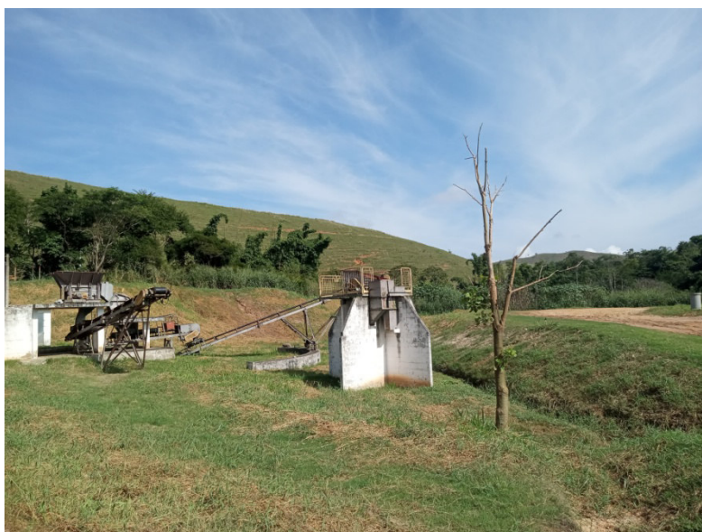
Figura 25: Britador de resíduos da construção civil. Há um funcionamento muito abaixo do esperado ,esporadicamente tem sido posto em operação
