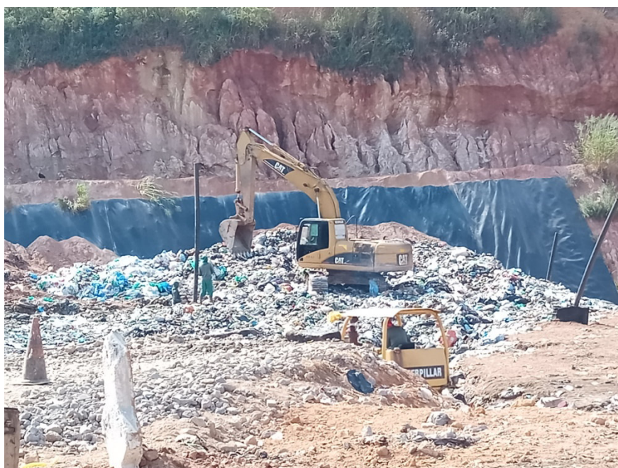
Figura 8: Frente de trabalho. Equipamento compactando resíduos e visão da Geo membrana ao fundo
