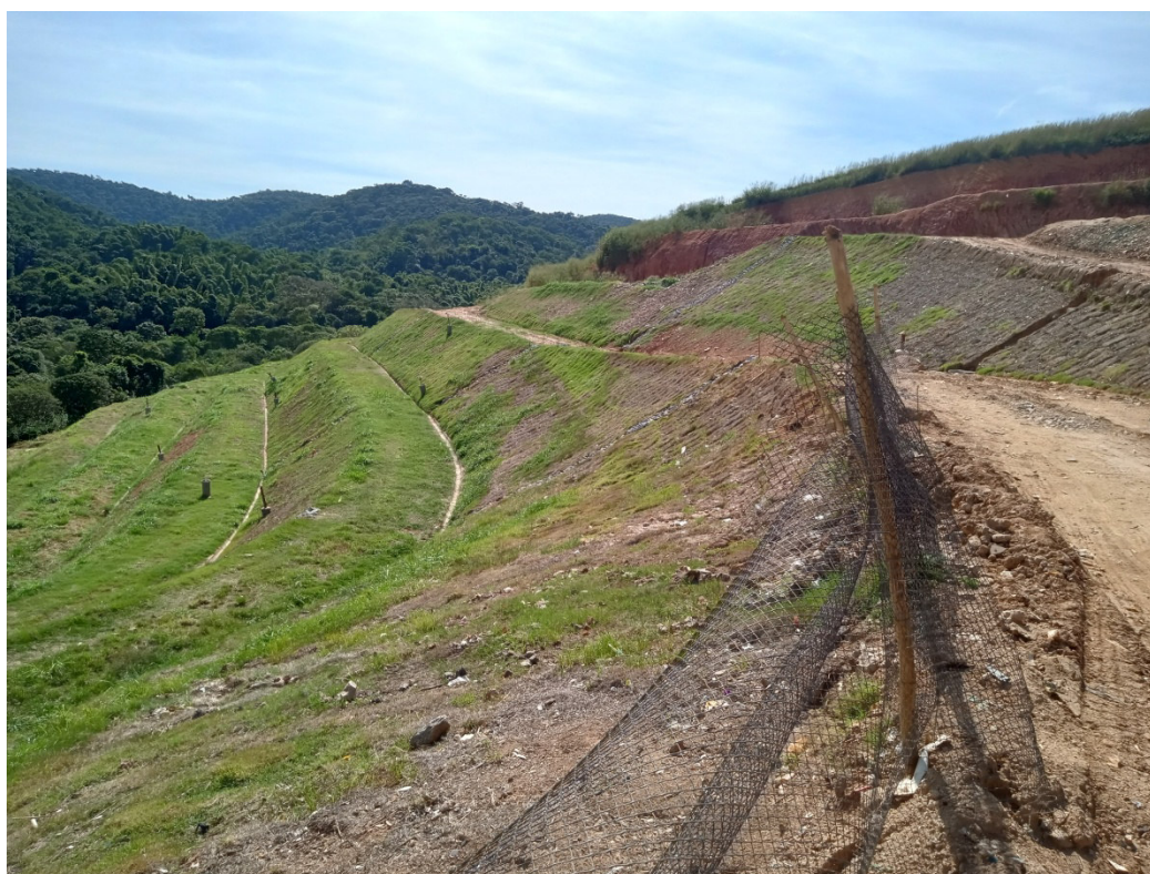
Figura 12: Recomposição vegetal do talude
