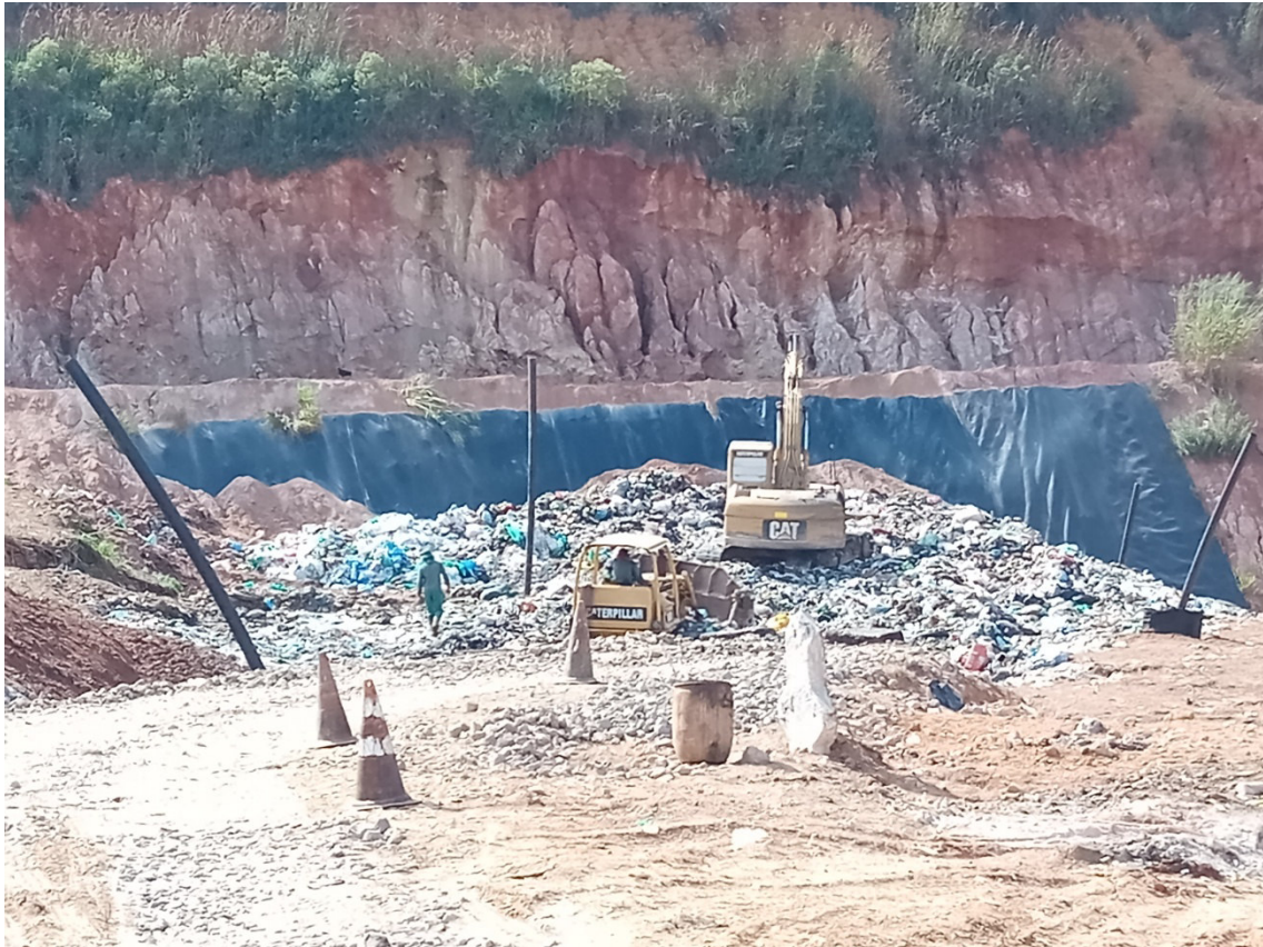
Figura 9: Frente de trabalho. Equipamento compactando resíduos e visão da Geo membrana ao fundo
